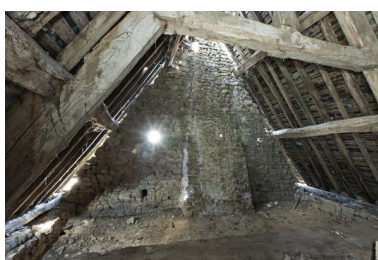
Ferme de charpente nord et manteau de cheminée. Phot. Yves Guillotin IVR52_20185300509NUCA
