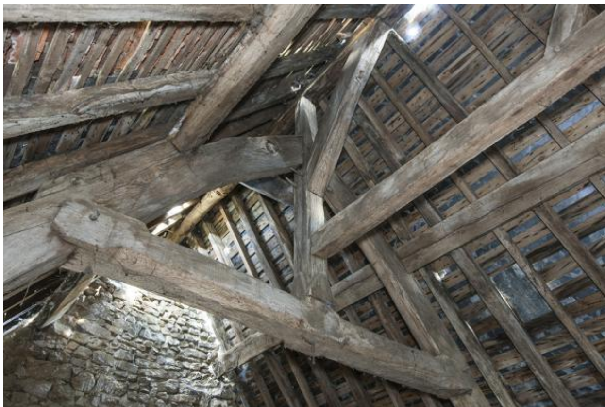
Ferme de charpente nord.
