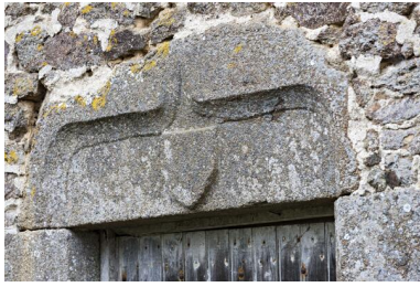
Linteau à accolade, écu fruste. Phot. Yves Guillotin IVR52_20235301243NUCA
