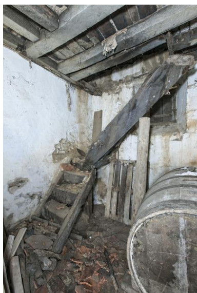
Escalier, échelle de meunier, pièce nord. Phot. Yves Guillotin IVR52_20185300500NUCA
