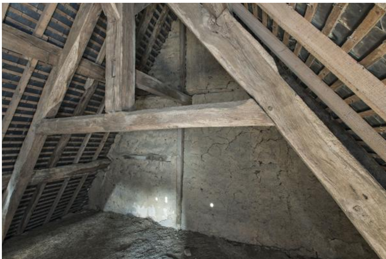
Maison de Bignon, ferme sud de la charpente.
