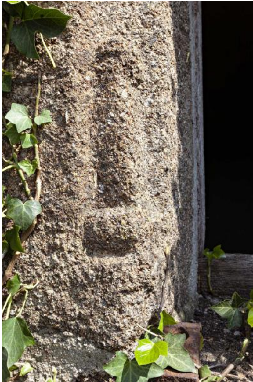
Détail du congés de la fenêtre de la salle basse.
