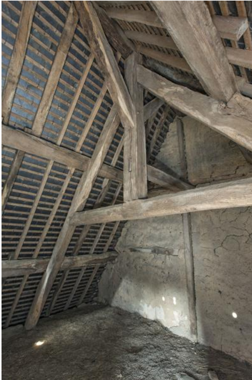
Maison de Bignon, ferme sud de la charpente.
