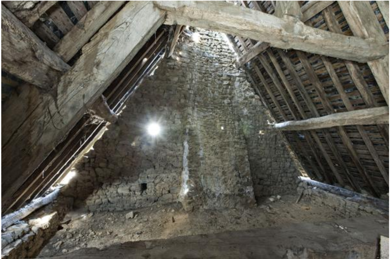
Ferme de charpente nord et manteau de cheminée.
