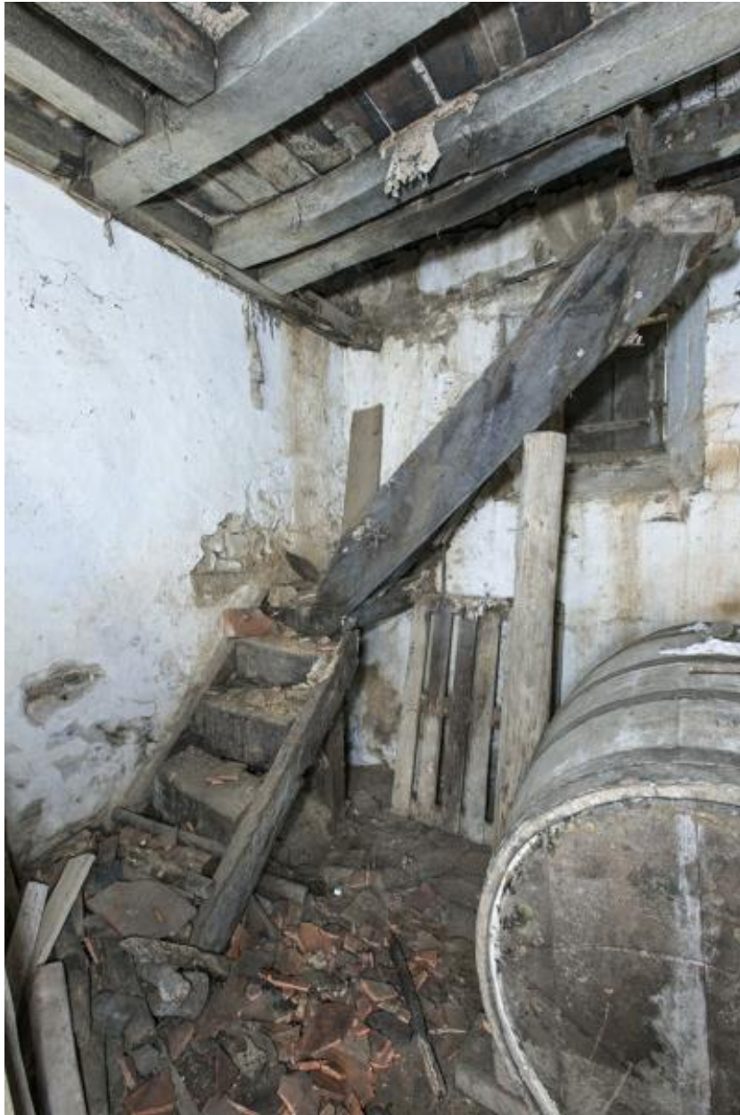
Escalier, échelle de meunier, pièce nord.
