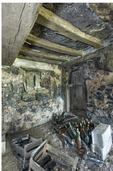
Maison de Bignon, cave sous la pièce sud. Phot. Yves Guillotin IVR52_20185300501NUCA
