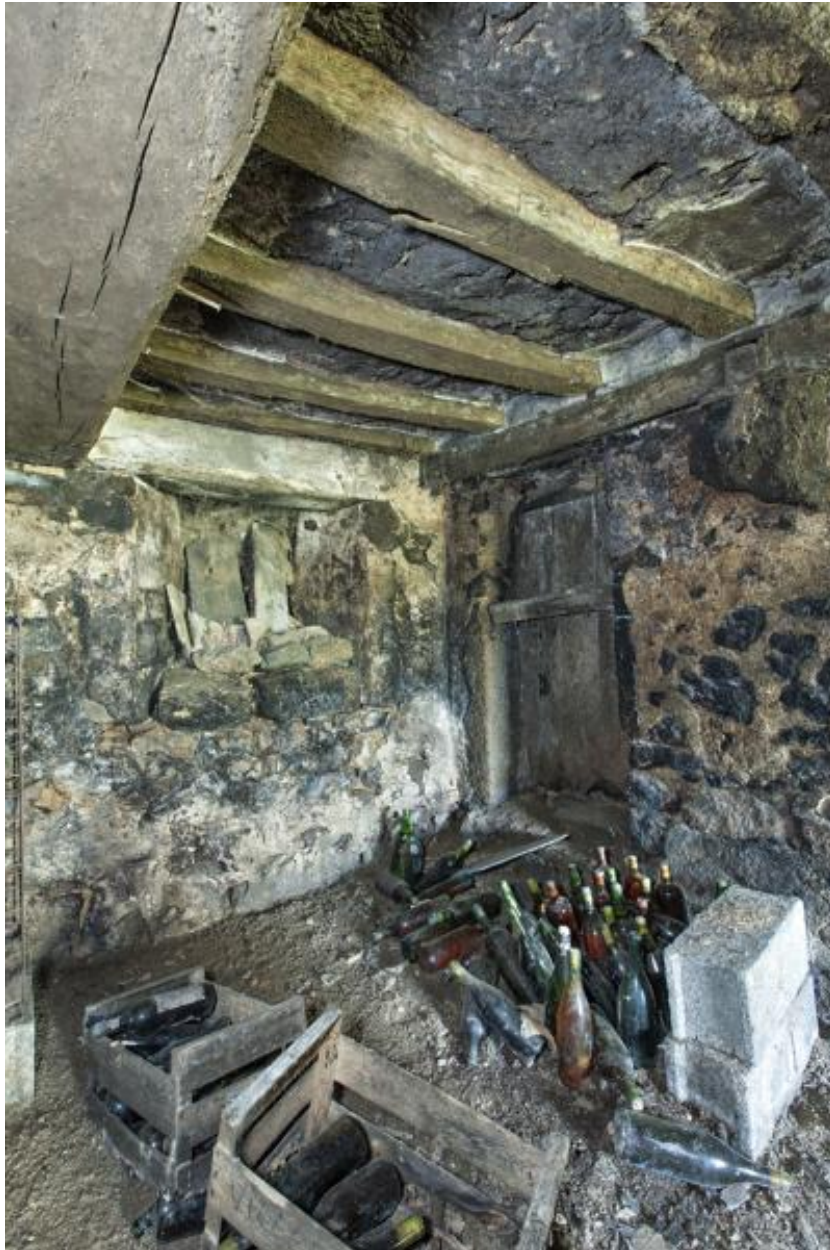
Maison de Bignon, cave sous la pièce sud.
