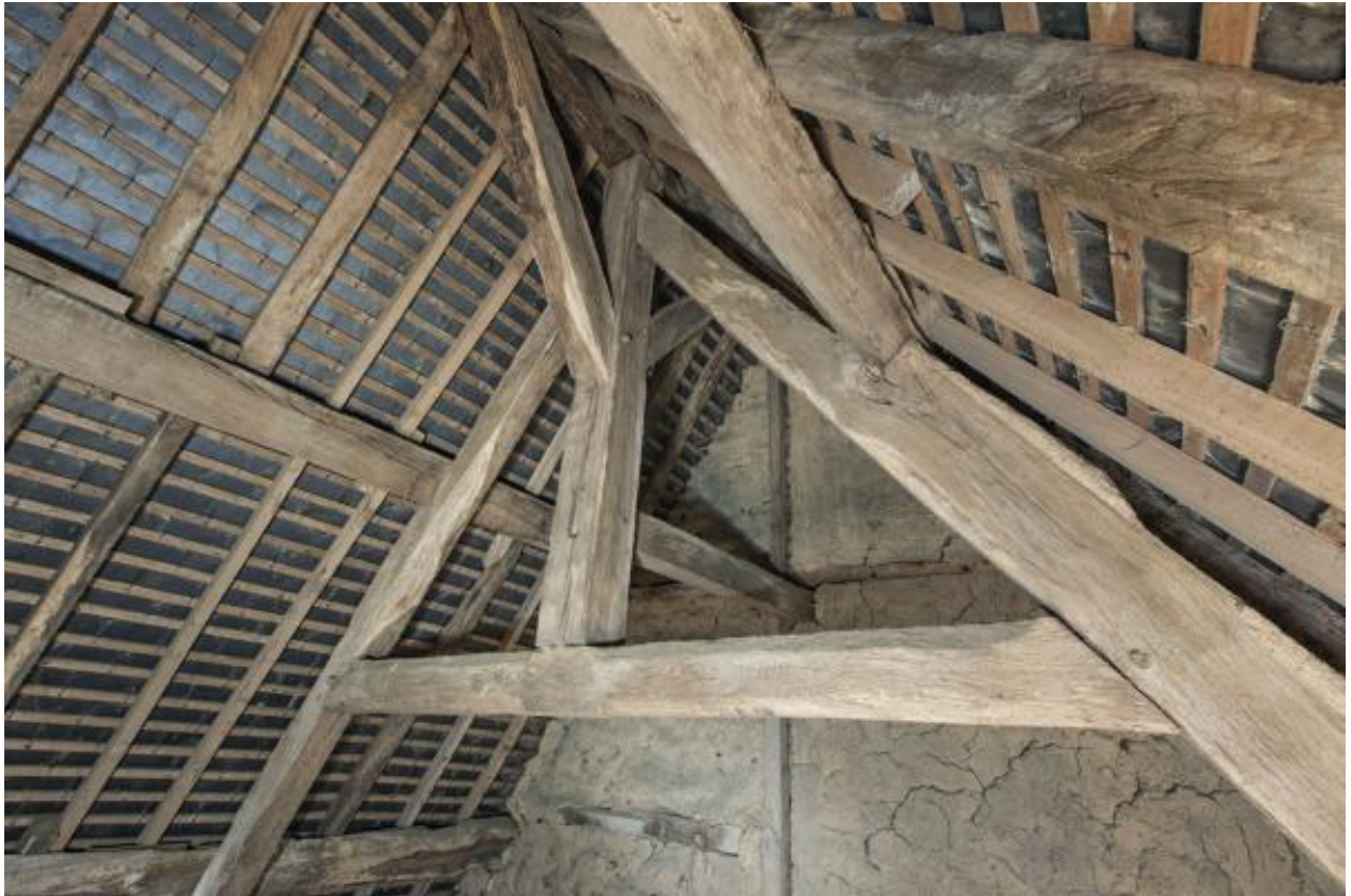
Ferme sud de la charpente.
