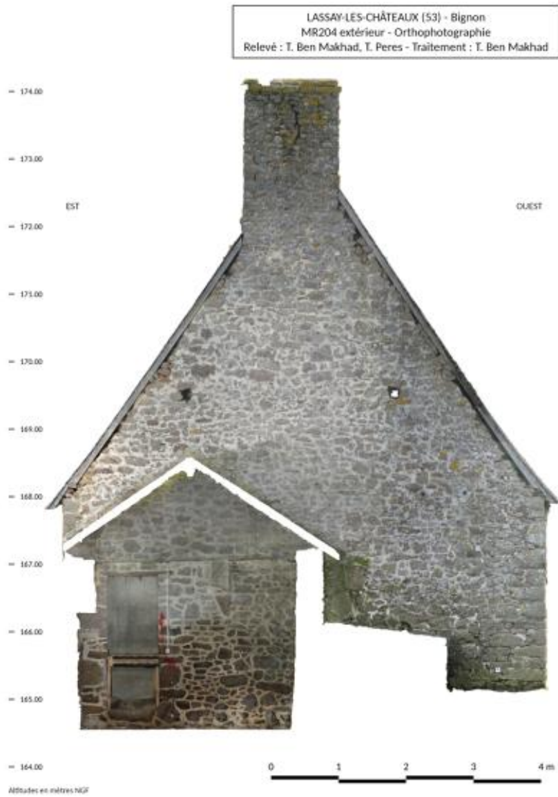
Orthophotographie du mur-pignon nord.
