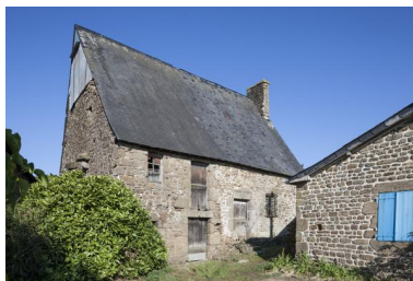
Maison de Bignon, façade orientale. Phot. Yves Guillotin IVR52_20185300428NUCA
