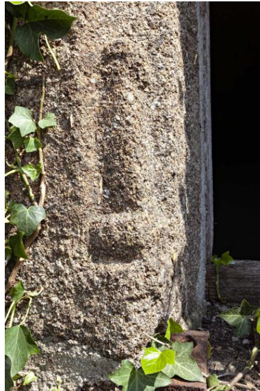
Détail du congés de la fenêtre de la salle basse. Phot. Yves Guillotin IVR52_20215300258NUCA
