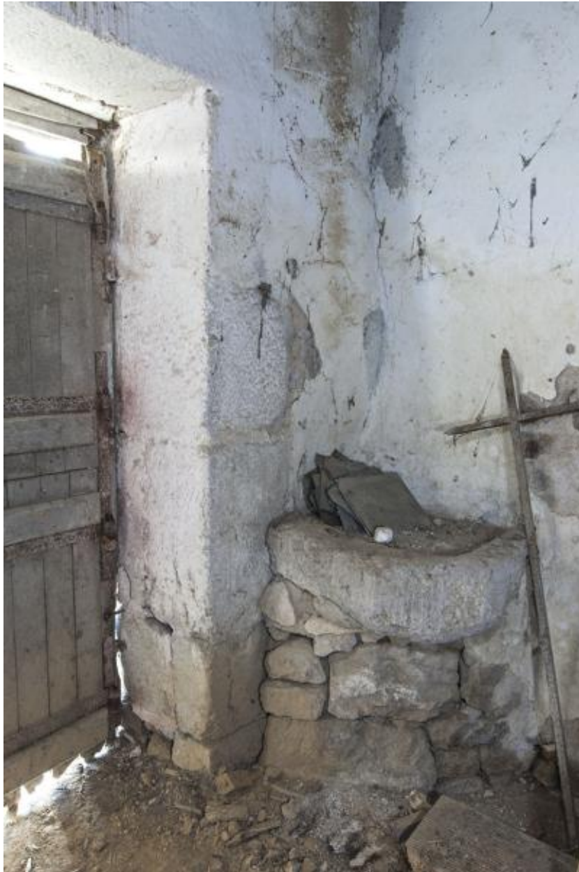
Pierre d'évier dans la pièce nord du rez-de-chaussée.
