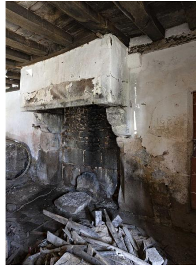
Cheminée de la salle basse. Phot. Yves Guillotin IVR52_20215300255NUCA
