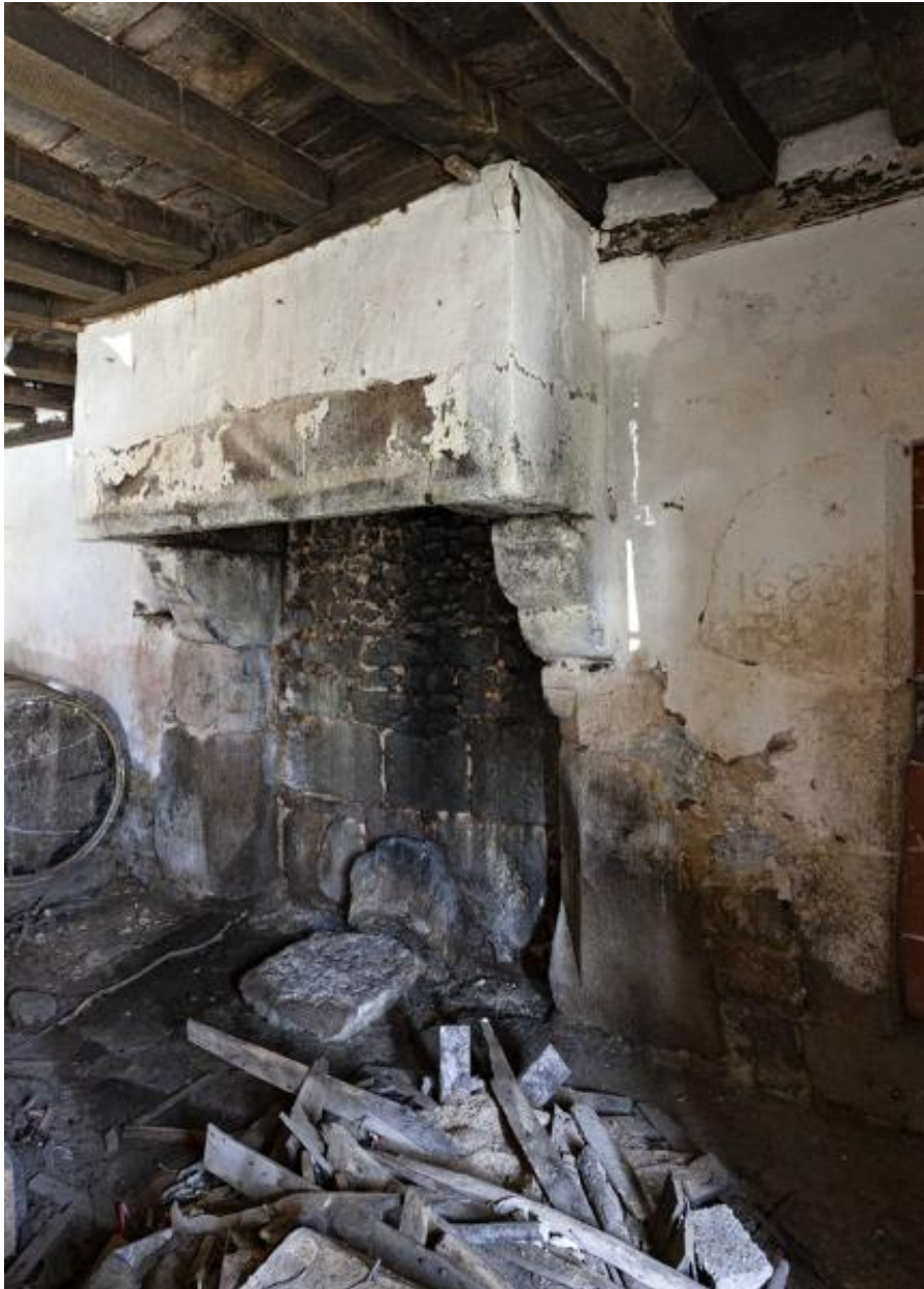
Cheminée de la salle basse.
