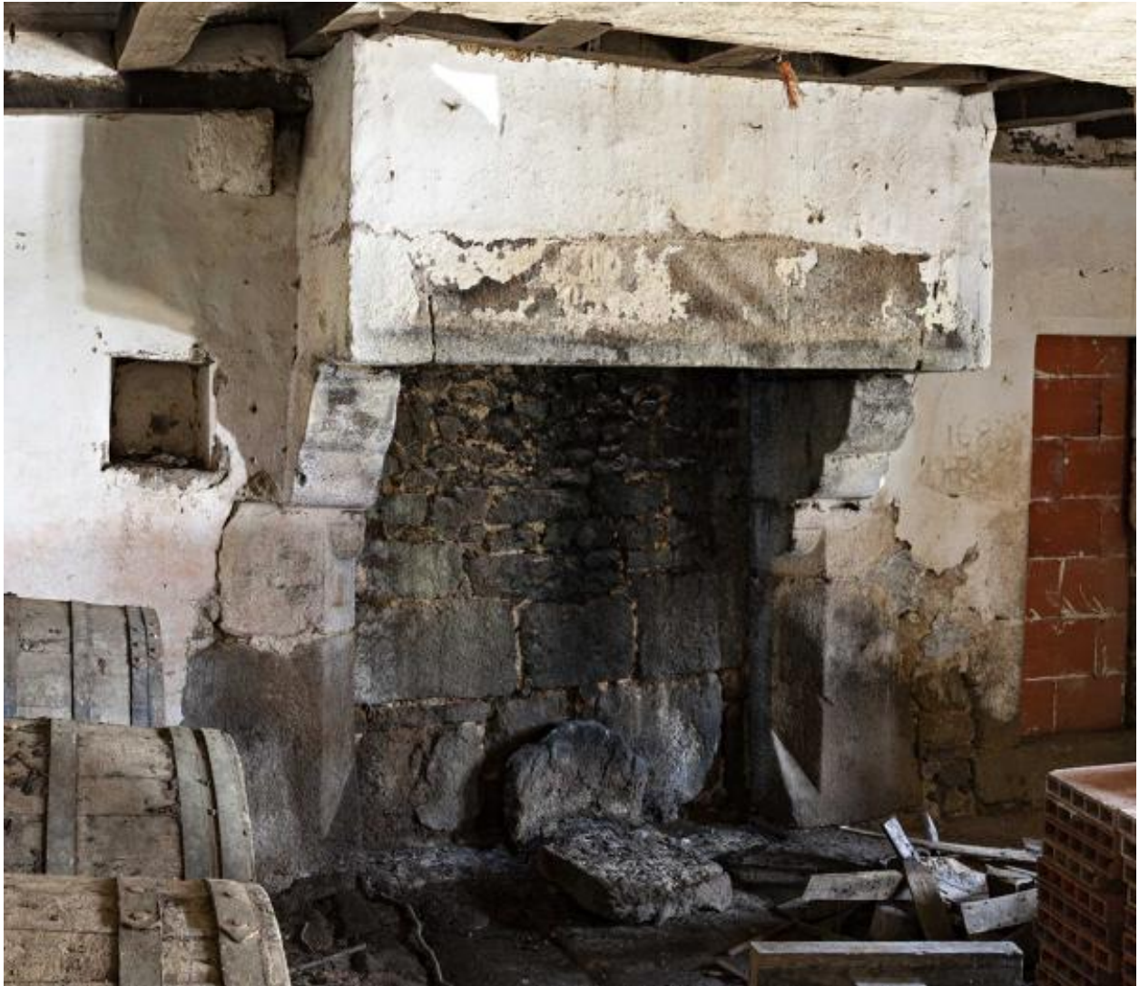
Cheminée de la salle basse, vue de face.
