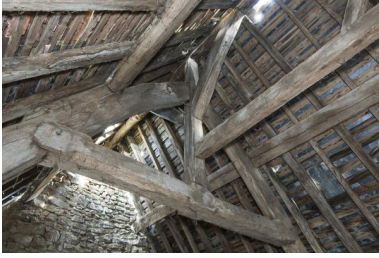
Ferme de charpente nord. Phot. Yves Guillotin IVR52_20185300508NUCA
