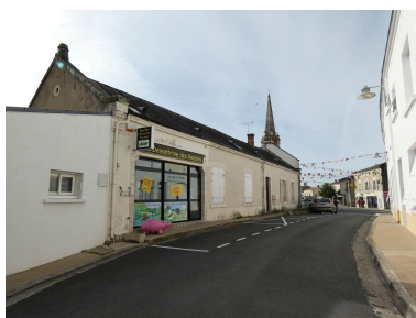
Le bâtiment vu depuis le nord. Phot. Yannis Suire IVR52_20228500382NUCA
