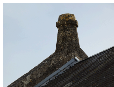
Amortissement au sommet d'un des deux murs pignons découverts. Phot. Yannis Suire IVR52_20228500381NUCA
