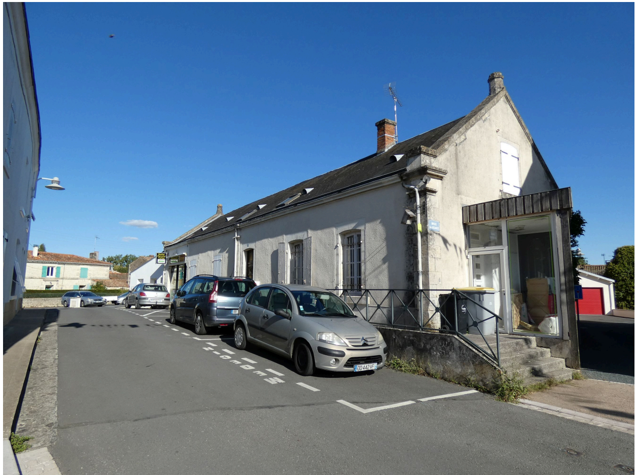
L'ancienne école puis bureau de poste vu depuis le sud-ouest.
