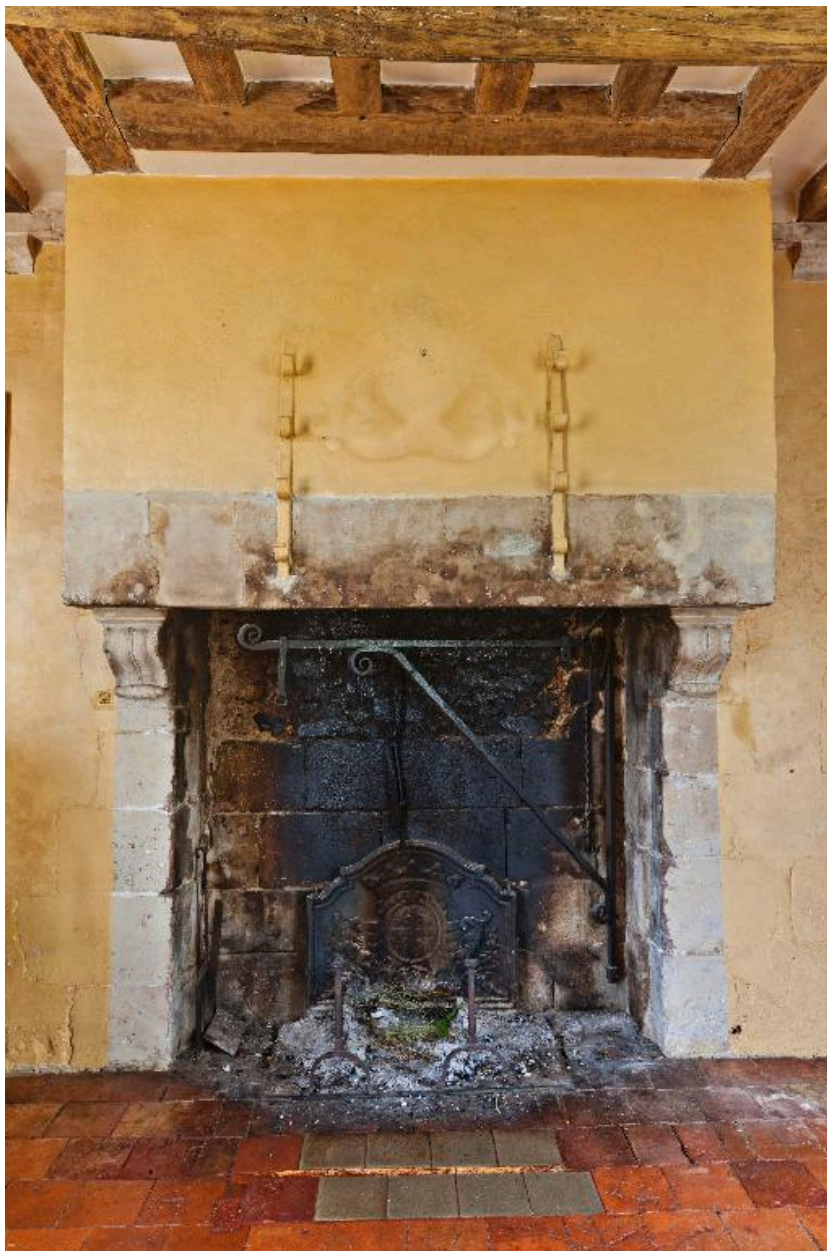
Cheminée de la pièce de gauche du logis, 3e quart du XVIe siècle.
