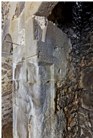
Détail de la cheminée du fournil. Le départ de l'arc qui couvrait la cheminée est bien visible sous le premier claveau de l'arc en place. Phot. Yves Guillotin IVR52_20147201801NUCA
