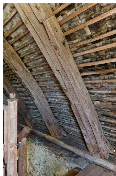
Détail de la charpente de la remise et du logement. Phot. Yves Guillotin IVR52_20147201689NUCA
