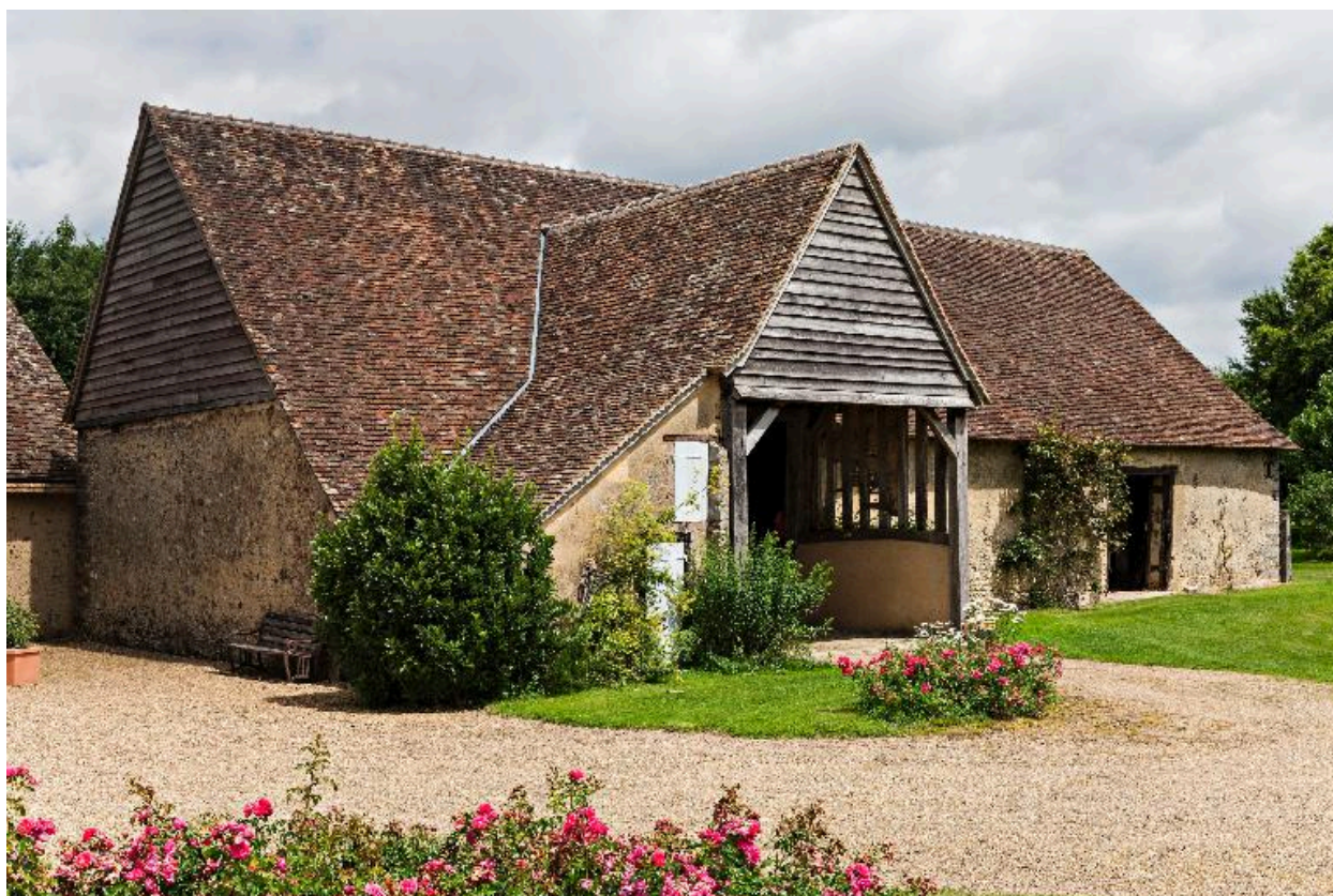
Elévation sur cour de la grange.
