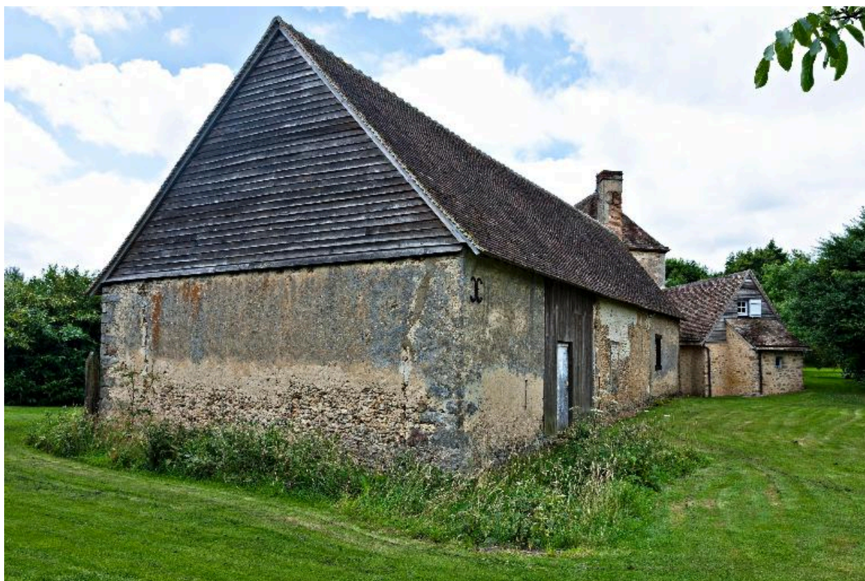
La grange vue depuis l'est.
