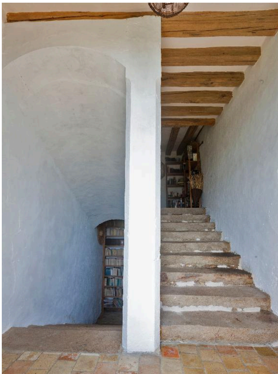
Escalier du logis, vu de l'étage.
