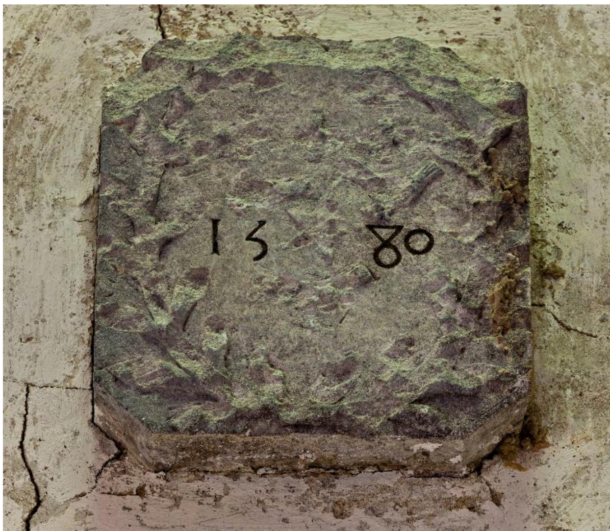
Armoiries buchées et date portée de la voûte du fournil.
