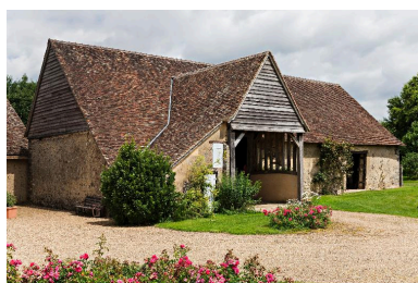
Elévation sur cour de la grange. Phot. Yves Guillotin IVR52_20147201790NUCA
