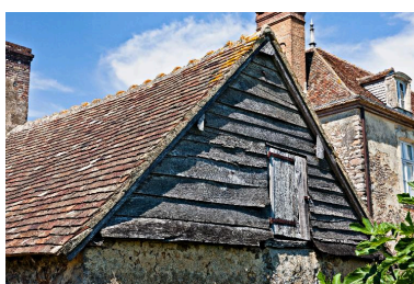
Détail du pignon sud du corps en prolongement du fournil. Phot. Yves Guillotin IVR52_20147201696NUCA
