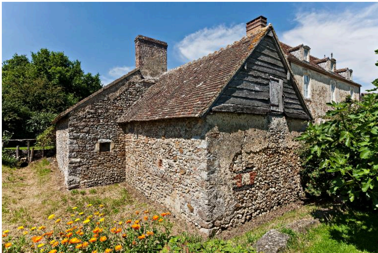
Vue du fournil et du fossé depuis l'ouest.
