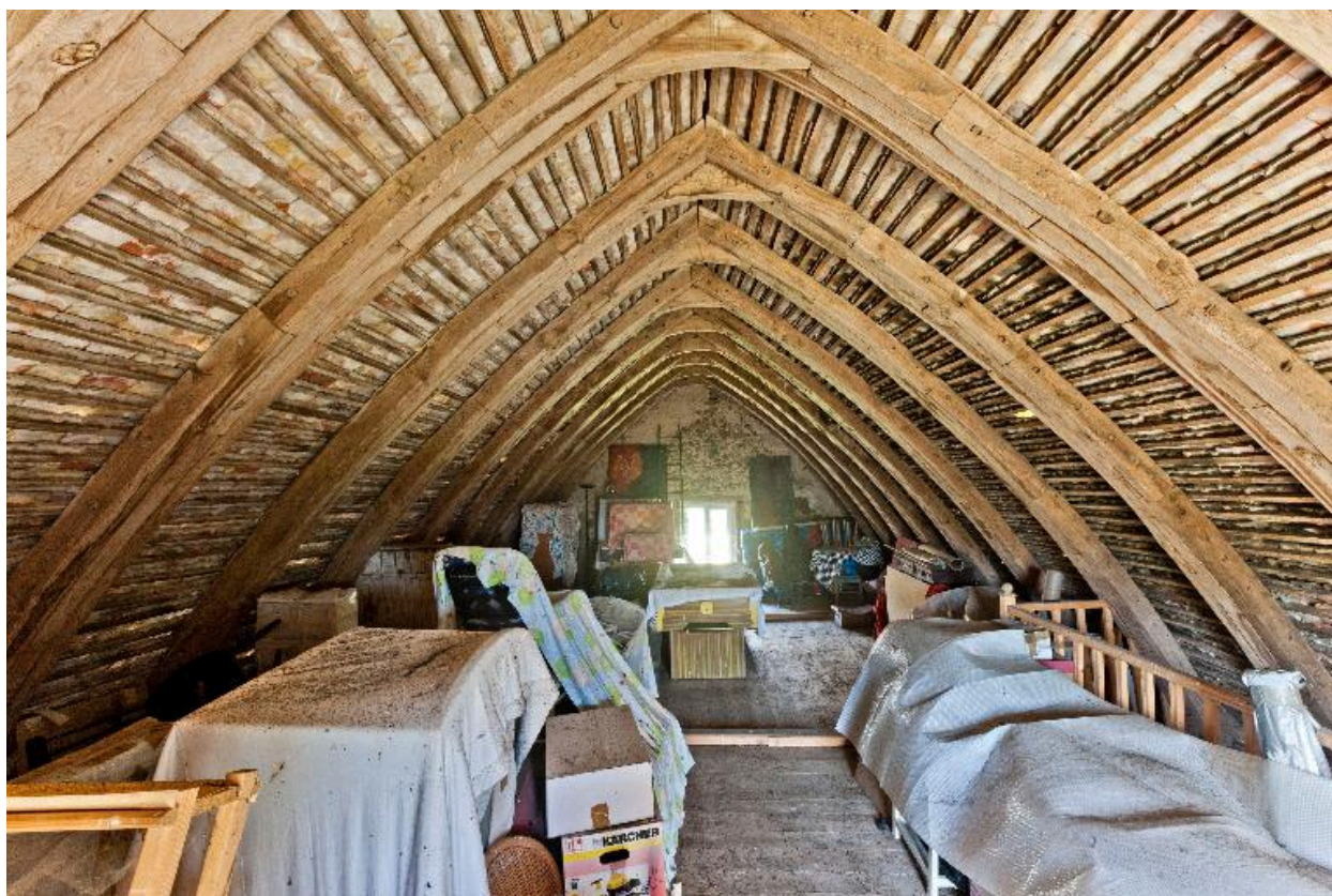
Vue de la charpente de la remsie et du logement.
