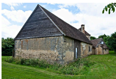
La grange vue depuis l'est. Phot. Yves Guillotin IVR52_20147201792NUCA
