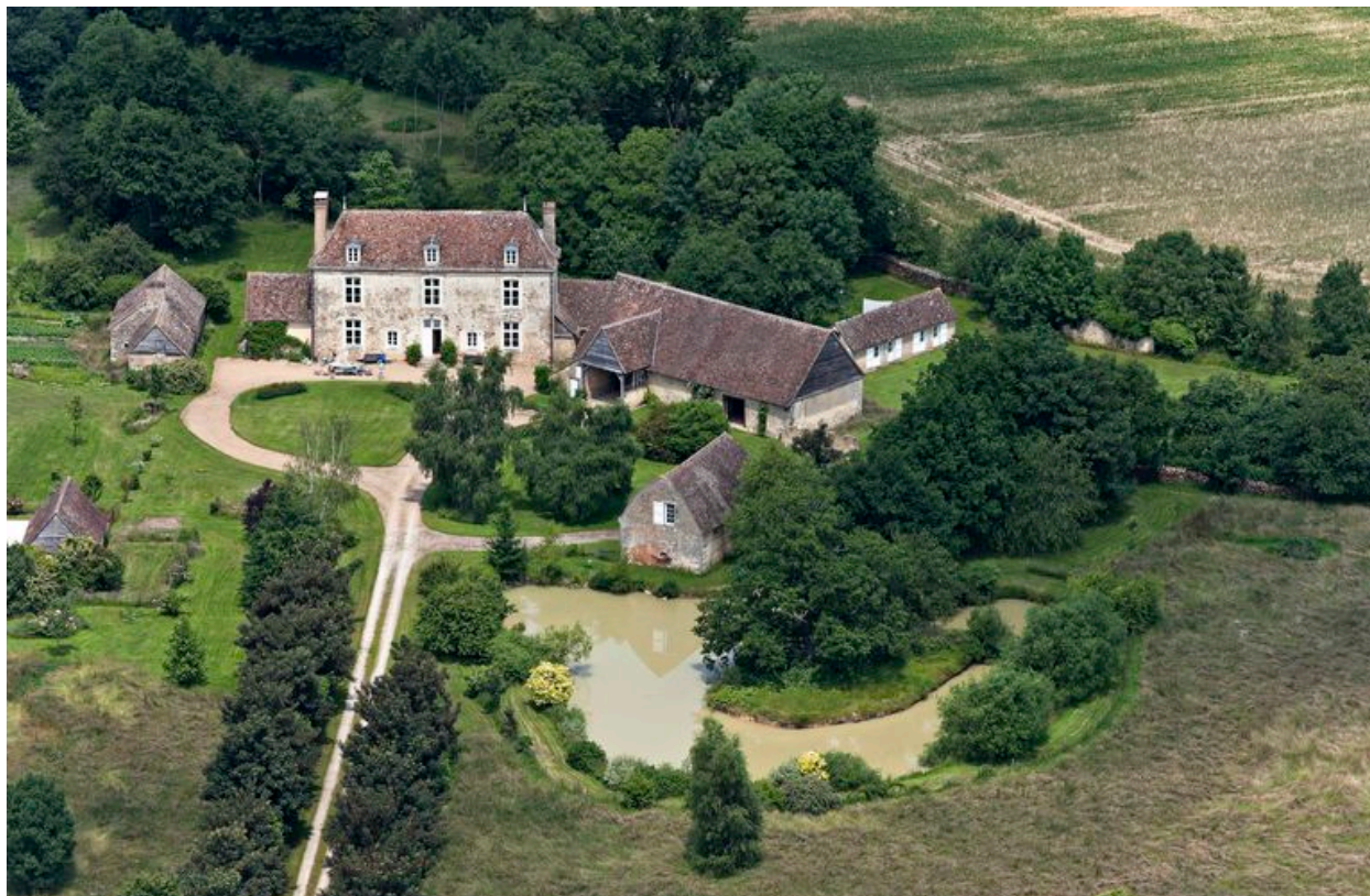
Vue aérienne depuis le sud. A droite, les vestige du logis de la ferme de La Bouilleterie.
