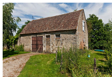
Elévations sur cour de la remise et du logement. Phot. Yves Guillotin IVR52_20147201692NUCA
