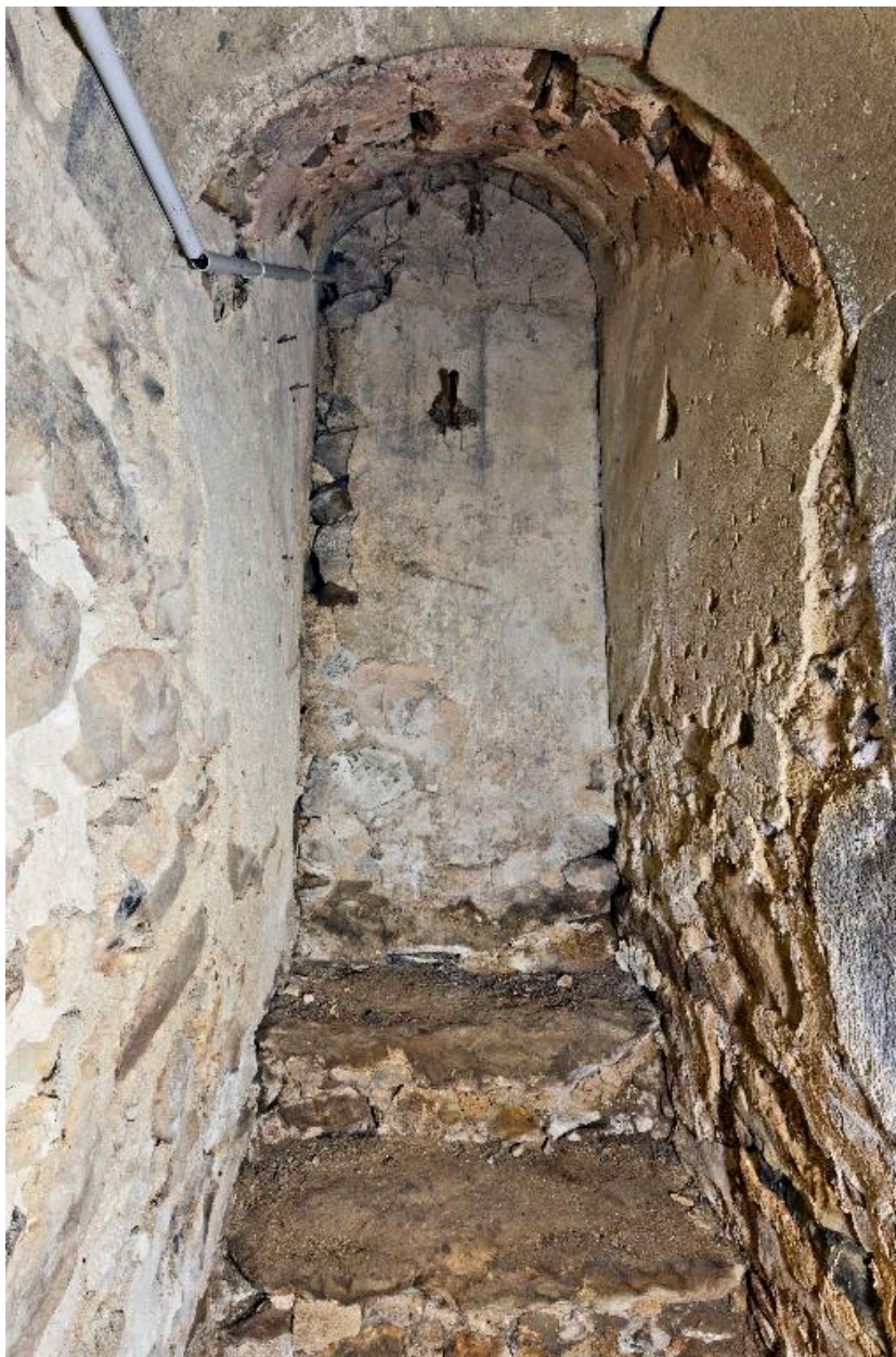
Escalier vers le comble à gauche de la cheminée.
