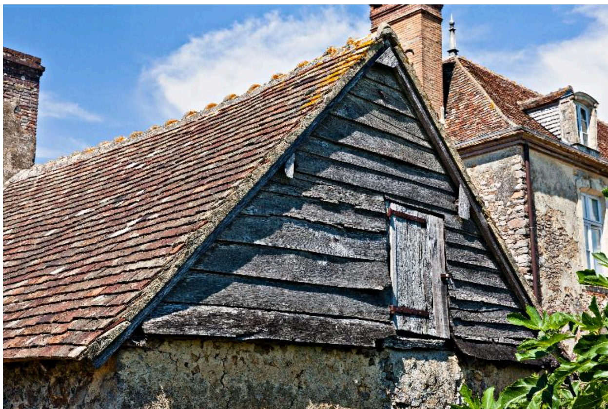
Détail du pignon sud du corps en prolongement du fournil.
