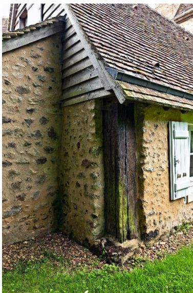
Détail de l'élévation postérieure de l'aile droite du logis, ancienne étable en pan-de-bois chemisée en maçonnerie de moellons. Phot. Yves Guillotin IVR52_20147201794NUCA
