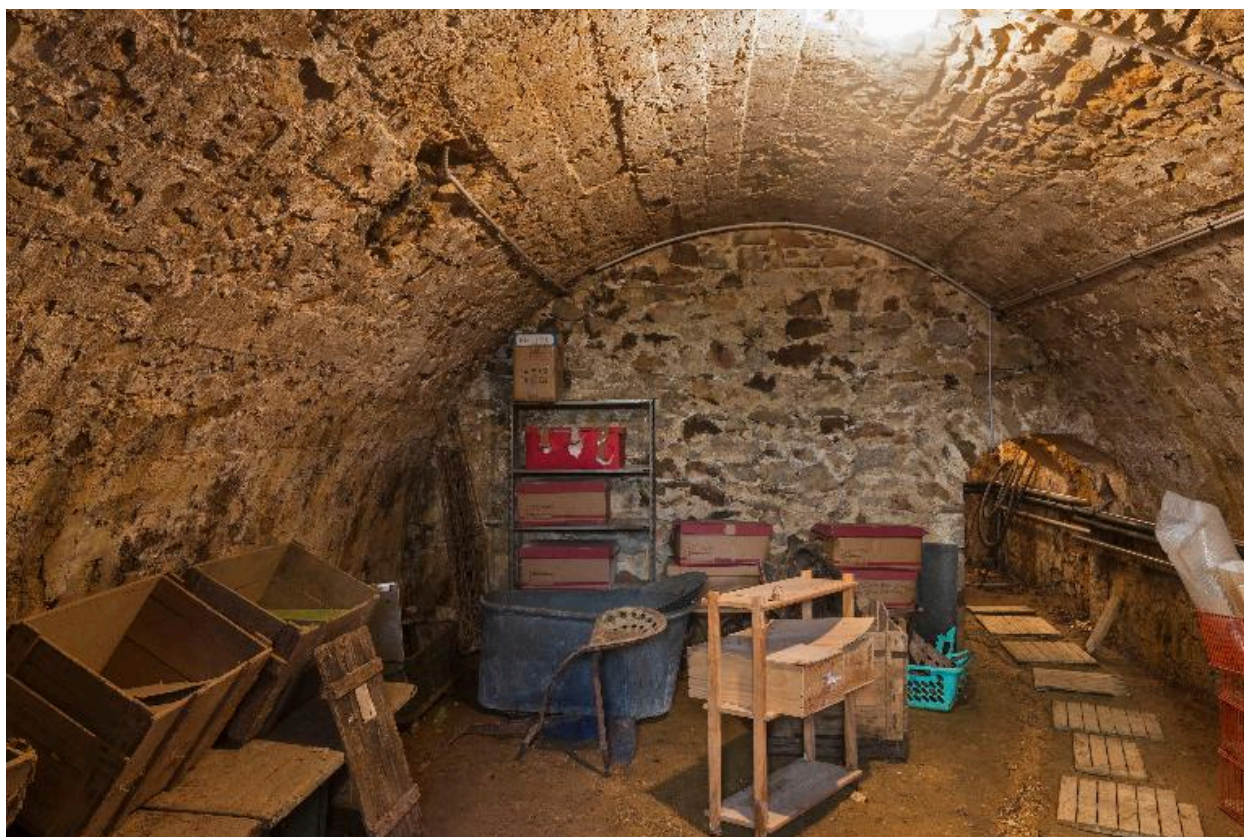
Partie droite des caves du logis.
