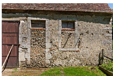
Détail de l'élévation sur cour du logement. Phot. Yves Guillotin IVR52_20147201691NUCA
