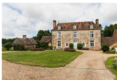
Elévations du logis sur la cour. Phot. Yves Guillotin IVR52_20147201788NUCA
