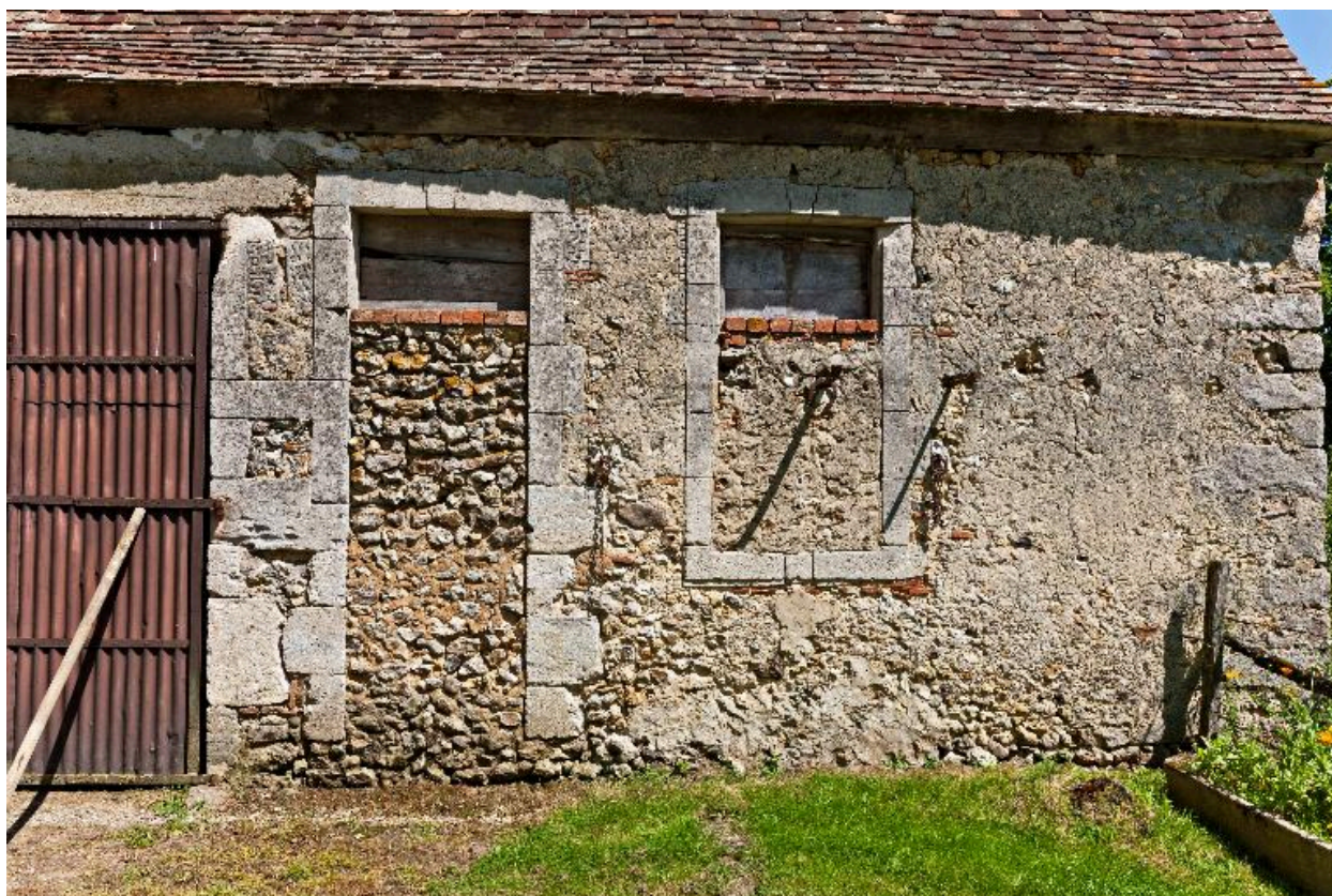
Détail de l'élévation sur cour du logement.
