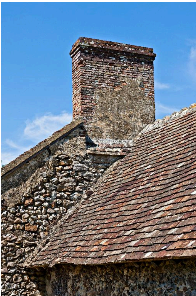
Détail du mur-pignon sud du fournil.
