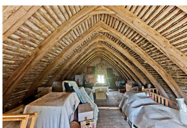
Vue de la charpente de la remise et du logement. Phot. Yves Guillotin IVR52_20147201688NUCA
