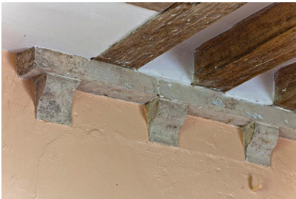
Détail de la corniche de la pièce gauche du rez-de-chaussée du logis.
