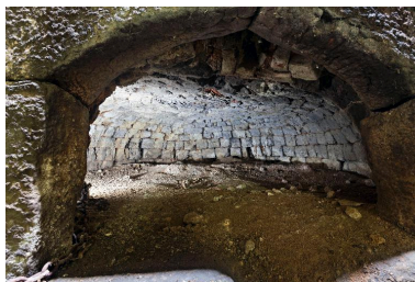
Voûte en pierres de taille du four à pain du fournil. Phot. Yves Guillotin IVR52_20147201802NUCA
