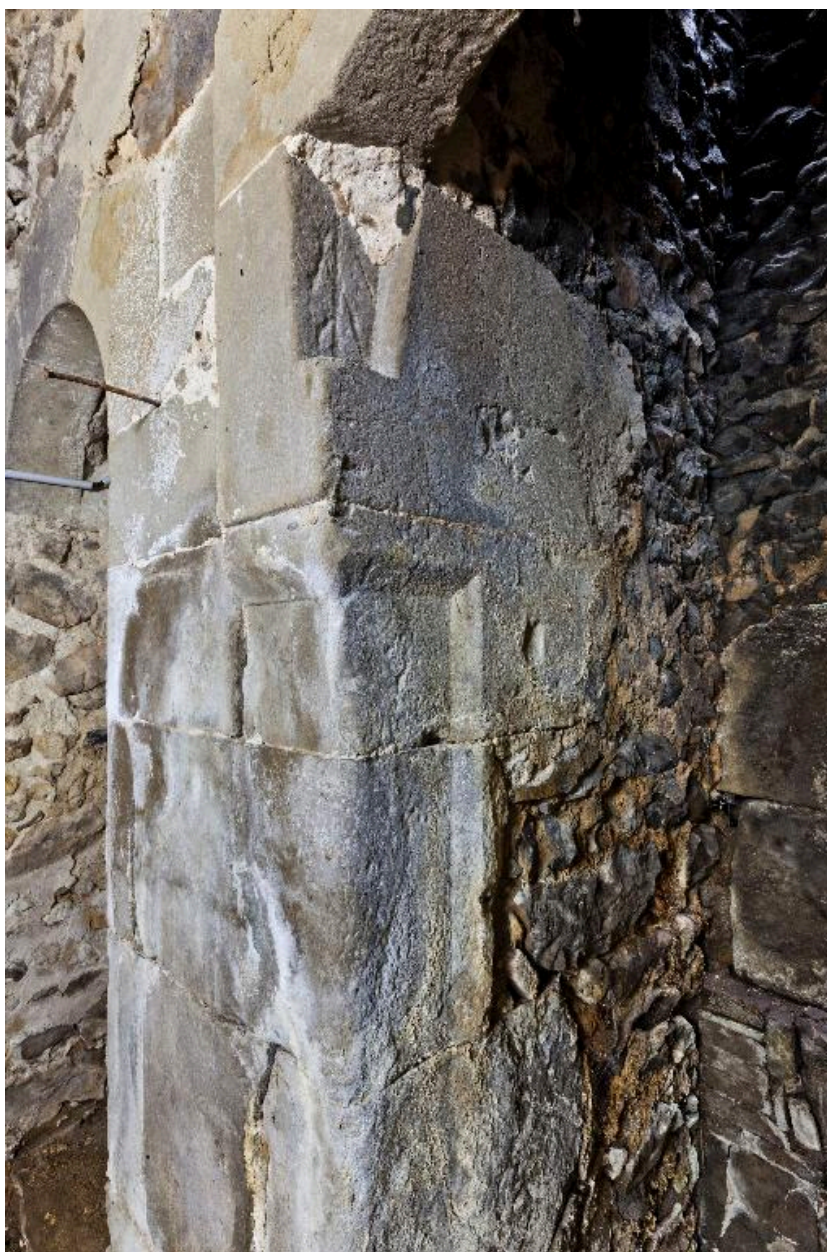
Détail de la cheminée du fournil. Le départ de l'arc qui couvrait la cheminée est bien visible sous le premier claveau de l'arc en place.
