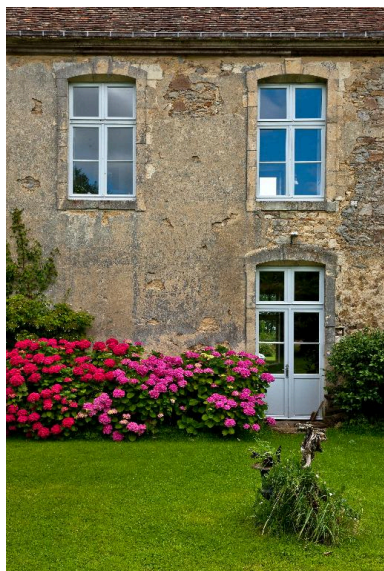
Détail de l'élévation sur jardin du corps central du logis : baie simulée dans l'enduit. Phot. Yves Guillotin IVR52_20147201796NUCA
