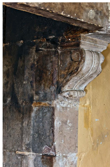
Détail de la cheminée. Phot. Yves Guillotin IVR52_20147201811NUCA
