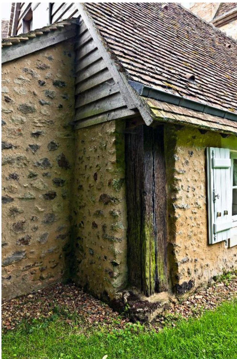
Détail de l'élévation postérieure de l'aile droite du logis, ancienne étable en pan-de-bois chemisée en maçonnerie de moellons.
