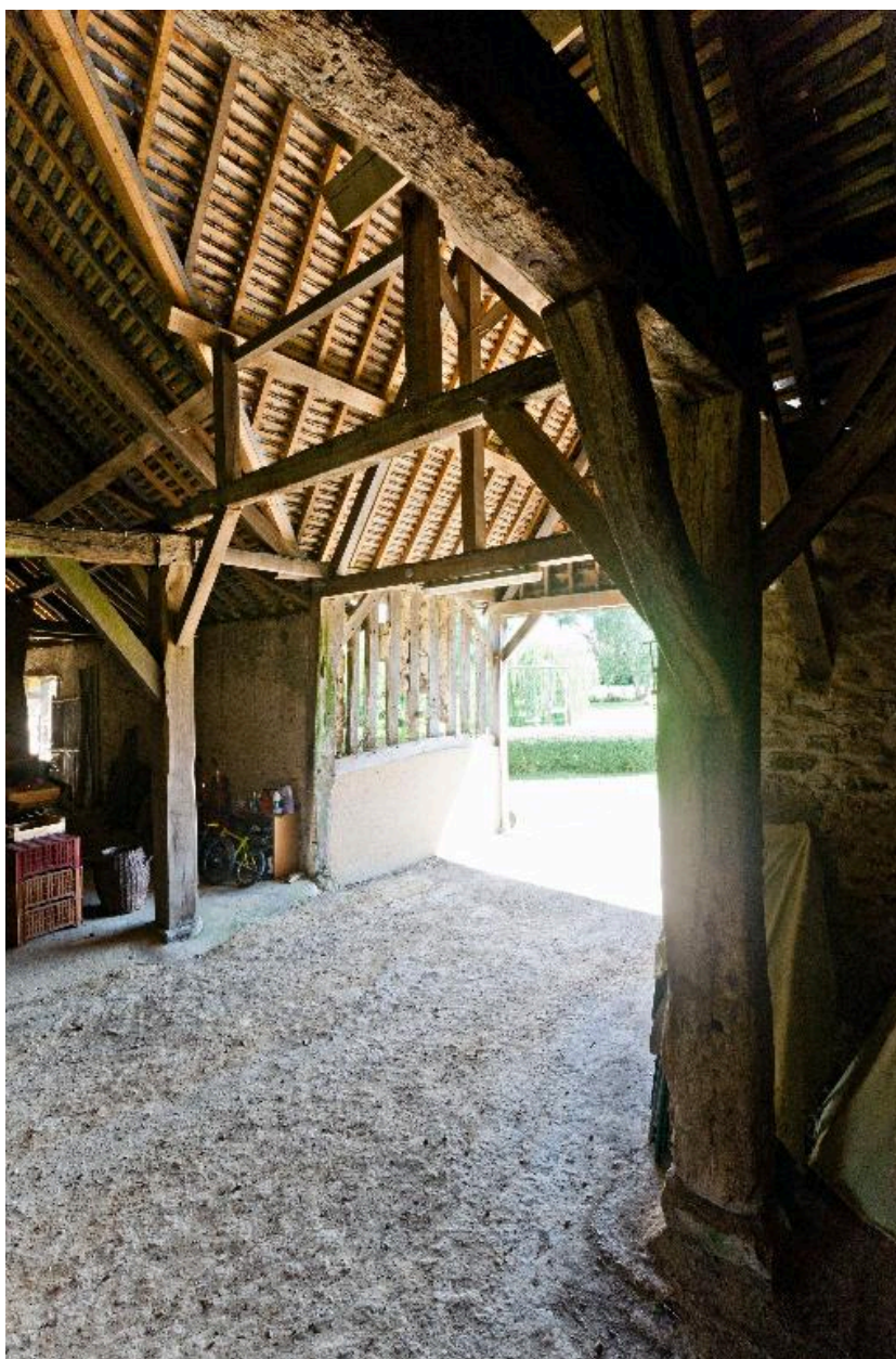
Vue intérieure du porche de la grange.
