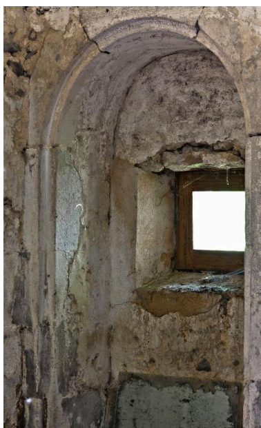
Arcade et meurtrière à l'angle nord-est du fournil. Phot. Yves Guillotin IVR52_20147201805NUCA
