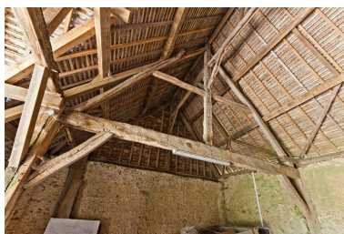
Charpentes de la partie gauche de la grange. Phot. Yves Guillotin IVR52_20147201687NUCA
