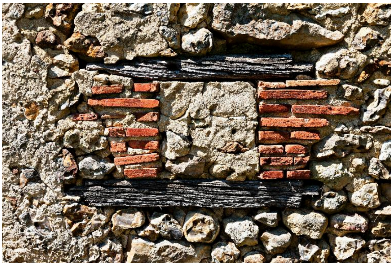
Baie du mur-pignon du corps en prolongement du fournil.
