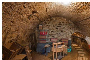
Partie droite des caves du logis. Phot. Yves Guillotin IVR52_20147201698NUCA
