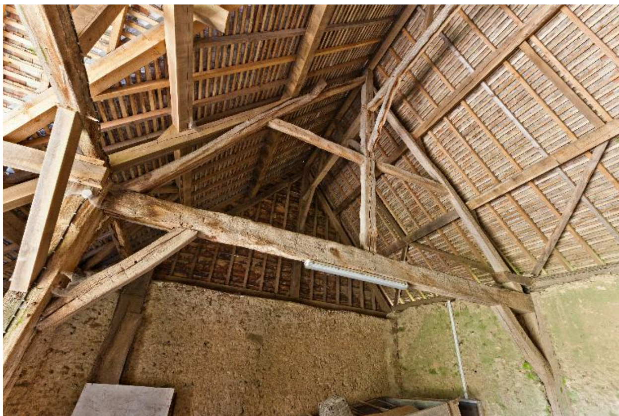
Charpentes de la partie gauche de la grange.
