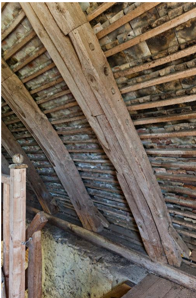
Détail de la charpente de la remise et du logement.
