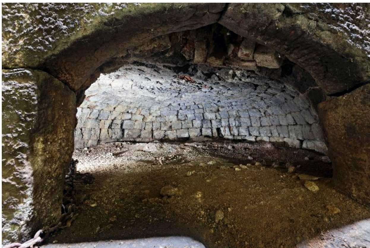
Voûte en pierres de taille du four à pain du fournil.
