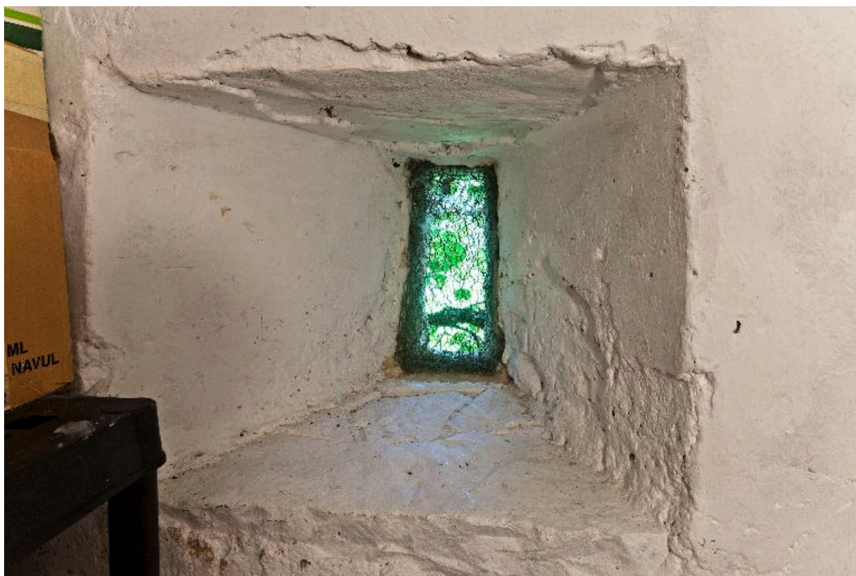
Meurtrière vers le jardin au rez-de-chaussée du logis.
