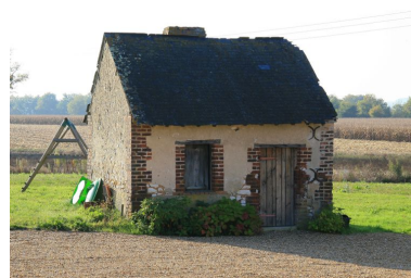
La buanderie : façade sur cour. Phot. Jean-Baptiste Darrasse IVR52_20077202445NUCA
