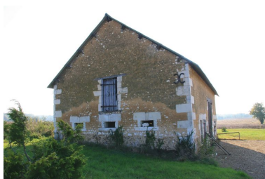
La grange : le pignon. Phot. Jean-Baptiste Darrasse IVR52_20077202448NUCA
