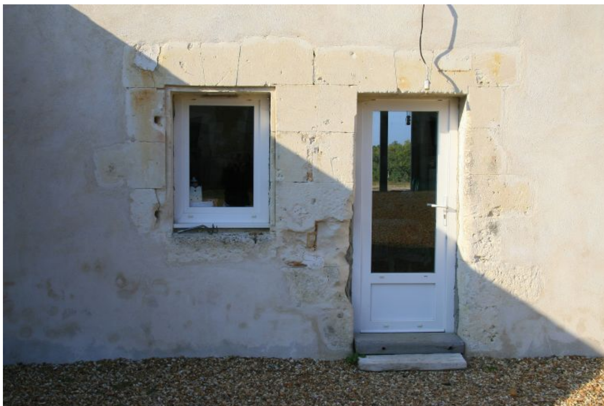
La maison, détail : porte et fenêtre.
