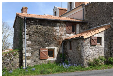
La Peltrie. Vue des bâtiments longeant la rue. Phot. Armelle Maugin IVR52_20254900537NUCA
