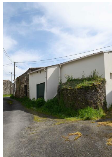
Ferme, rue de la Peltrie. Phot. Armelle Maugin IVR52_20254900532NUCA
