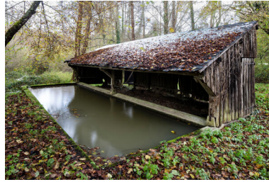
Vue d'ensemble. Phot. Thierry Seldubuisson IVR52_20247200436NUCA
