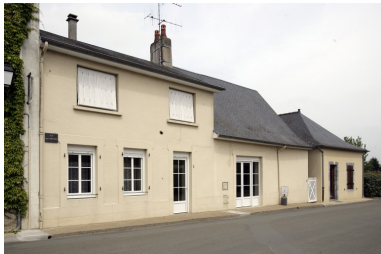
Vue depuis la rue au sud-ouest. Phot. François Lasa IVR52_20075302203NUCA
