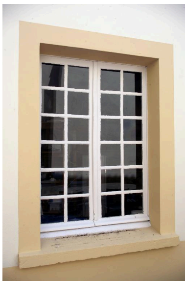
Le corps secondaire en appentis, la pièce située au nord : détail de la baie sud. Phot. Denis Pillet IVR52_20034400445NUCA
