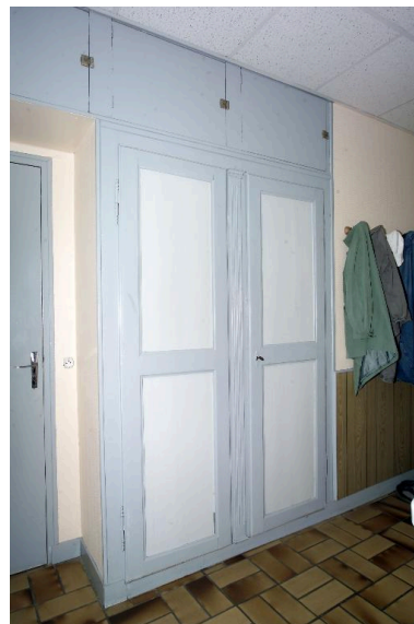
Les portes fermant actuellement la cage d'escalier de la première maison (escalier supprimé). Phot. Denis Pillet IVR52_20034400442NUCA
