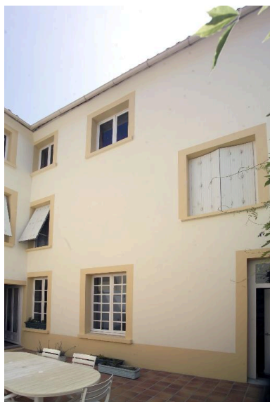
La façade du corps secondaire en retour sur la cour à l'est, vue partielle. Phot. Denis Pillet IVR52_20034400444NUCA
