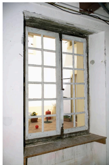
Le corps secondaire en appentis, la pièce située au nord : détail de la baie sud. Phot. Denis Pillet IVR52_20034400446NUCA
