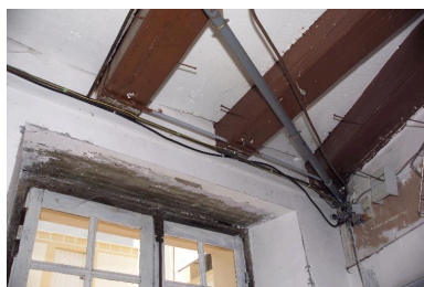
Le corps secondaire en appentis, la pièce située au nord : détail des solives. Phot. Denis Pillet
