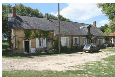
Vue d'ensemble de la maison. Phot. Jean-Baptiste Darrasse IVR52_20057203400NUCA
