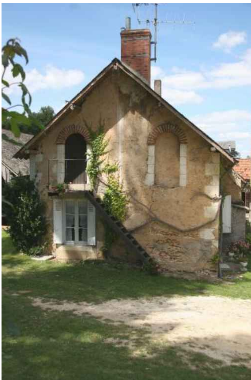
Pignon de la nouvelle maison.
