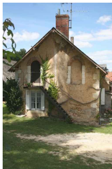
Pignon de la nouvelle maison. Phot. Jean-Baptiste Darrasse IVR52_20057203394NUCA
