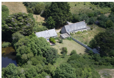
Vue aérienne de l'écart de l'Hôtel-Seignac. Phot. Denis Pillet IVR52_20104401174NUCA
