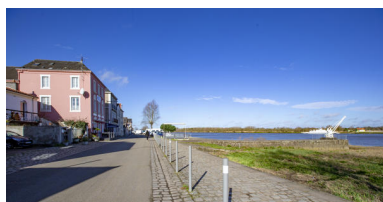
Vue générale du quai du Docteur-André-Provost en direction de l'ouest. Phot. Pierre-Bernard Fourny IVR52_20214400176NUCA
