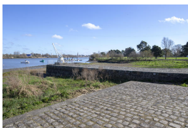
L'ancien môle du port du Pellerin. Phot. Pierre-Bernard Fourny IVR52_20214400178NUCA
