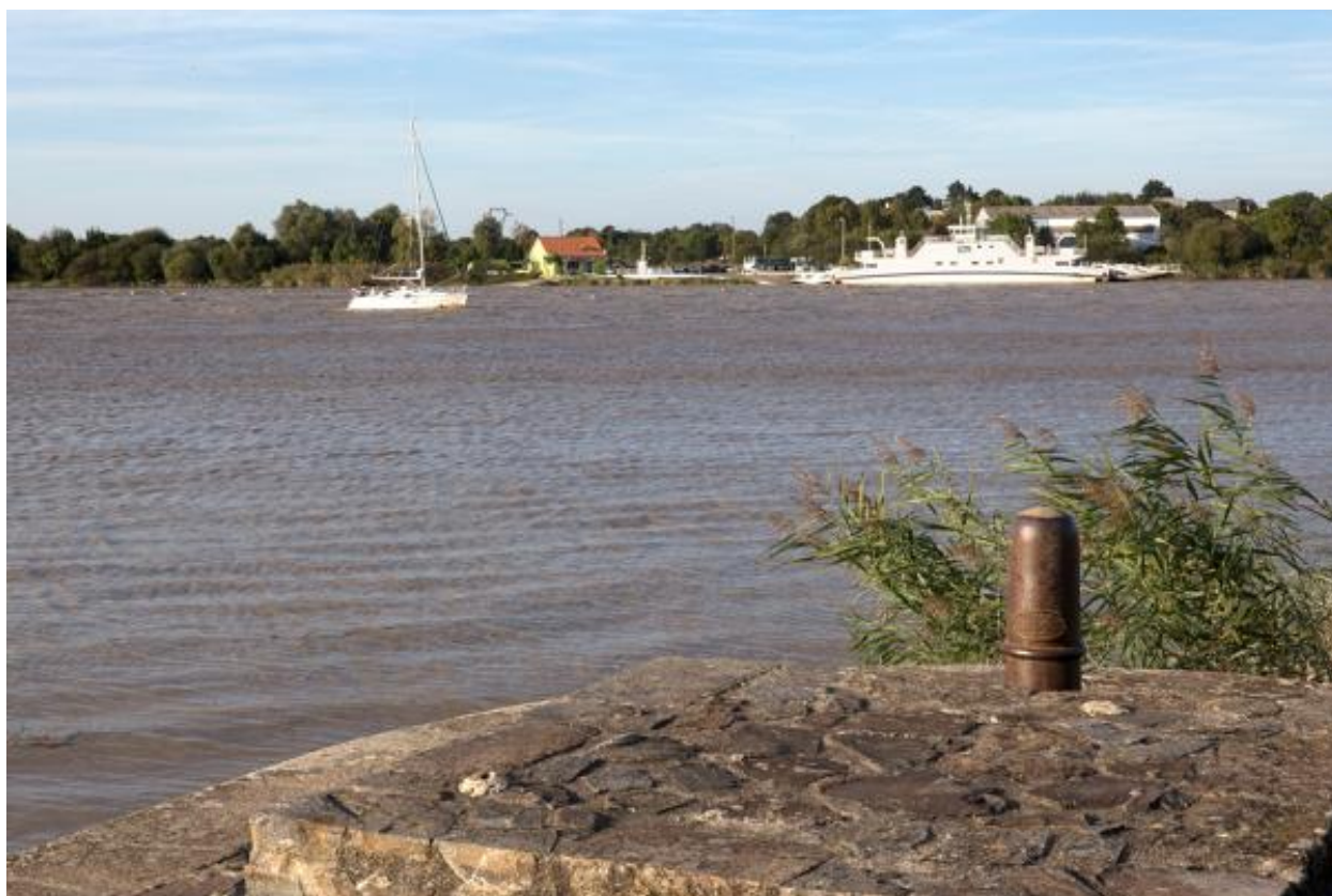
Le môle du port du Pellerin. Détail du bollard d'amarrage.
