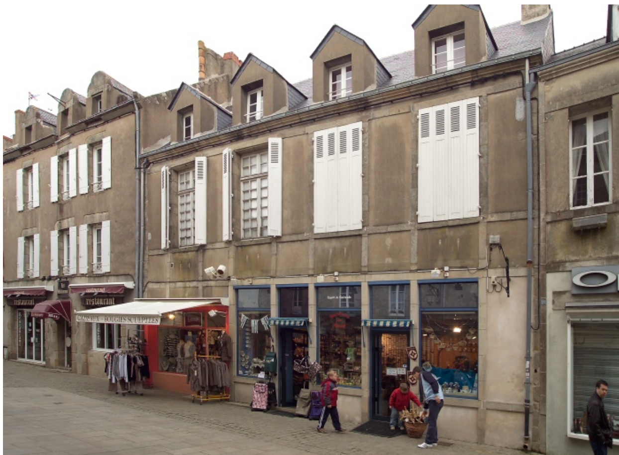
Vue de la façade sur la rue Saint-Michel.
