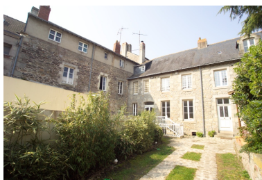
Vue de la façade sur jardin (à gauche de l'image).
