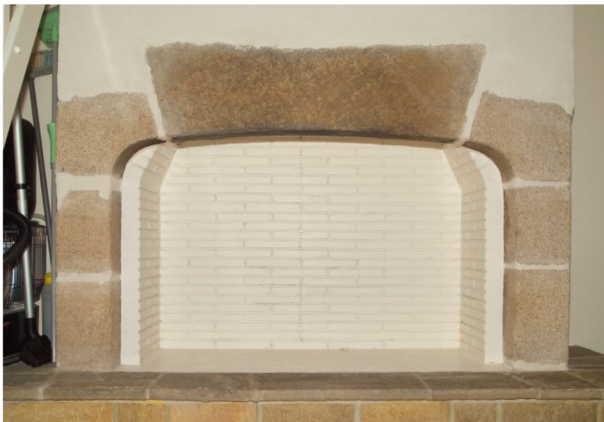
Cheminée au premier étage.
