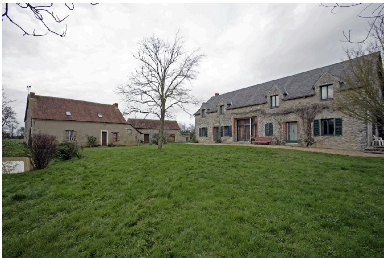
Vue d'ensemble depuis le sud-est : le logis, la petite étable ou bergerie et l'étable-grange.
