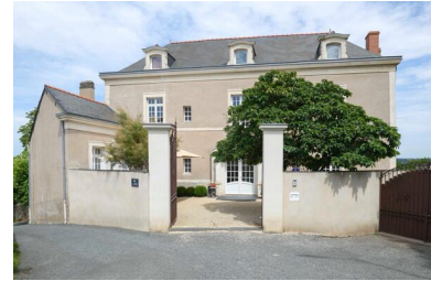
Vue d'ensemble de la façade sud de la maison dite Villa Margot, Montjean-sur-Loire. Phot. Armelle Maugin IVR52_20244900573NUCA
