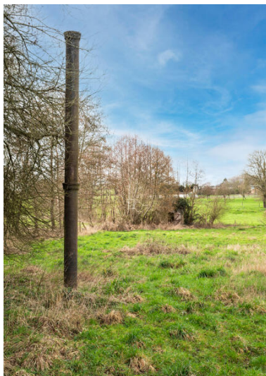
Colonne de chute branchée sur la conduite forcée souterraine (au premier plan) et l'abri pour le bélier (à l'arrière-plan)
