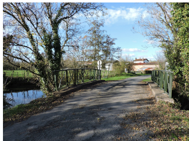
Le pont de la Mare vu depuis le sud. Phot. Yannis Suire IVR52_20218500567NUCA
