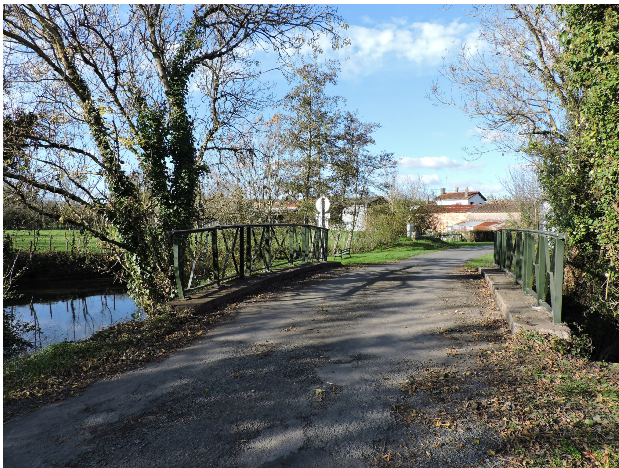
Le pont de la Mare vu depuis le sud.
