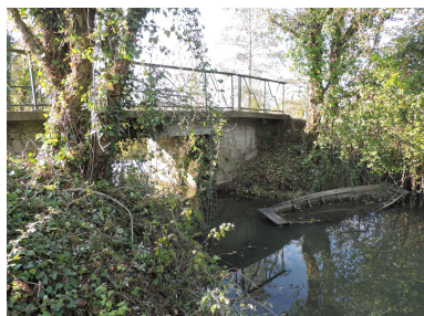
Le pont en amont, vu depuis le sud-est. Phot. Yannis Suire IVR52_20218500571NUCA
