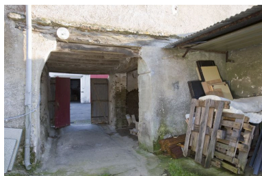
Le passage charretier : côté ouest, avec ses pieds-droits délaardés et l'appareillage de pierres au dessus de la poutre.
