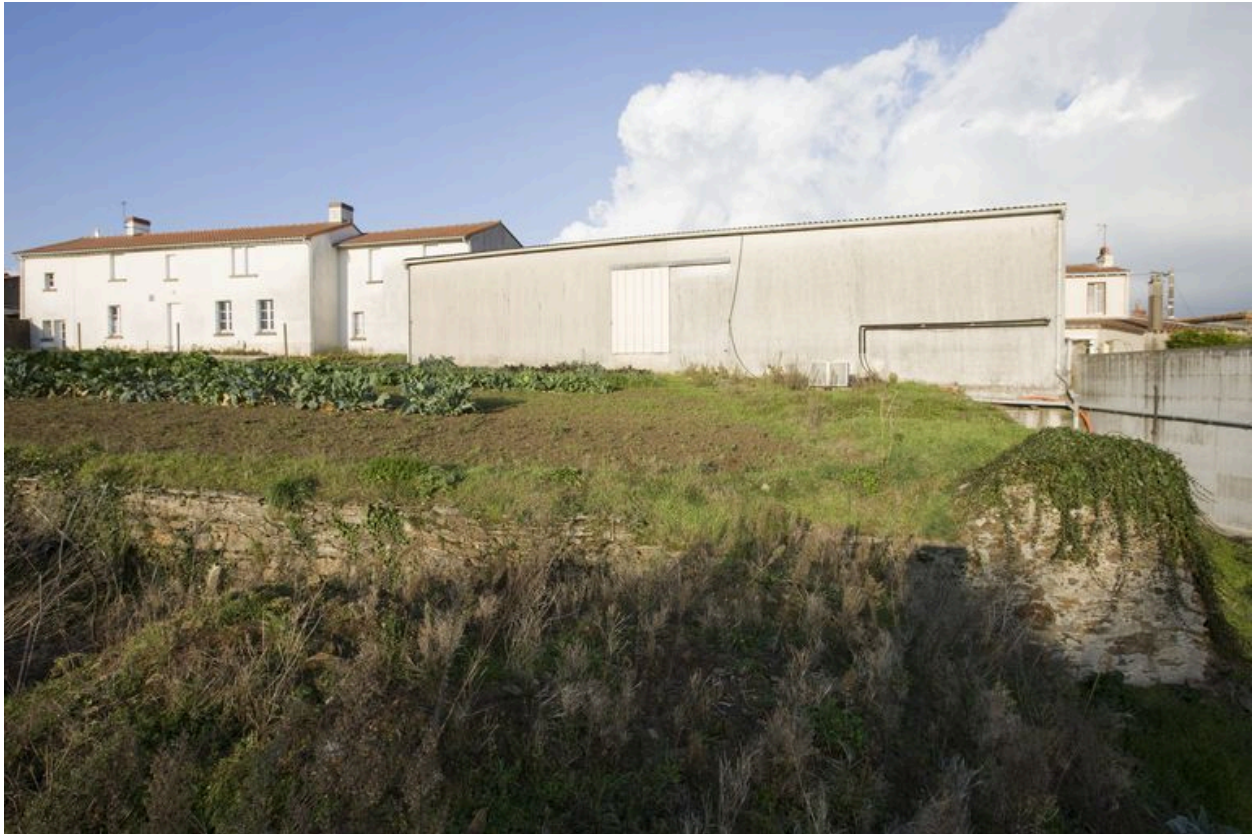
Le jardin : vestiges des murs de soutènement de la terrasse.
