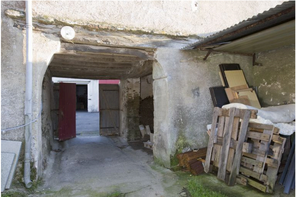
Le passage charretier : côté ouest, avec ses pieds-droits délardés et l'appareillage de pierres au dessus de la poutre.
