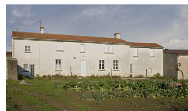
Le logis : la façade arrière, très remaniée vers 1980. Phot. Yves Guillotin IVR52_20104402995NUCA
