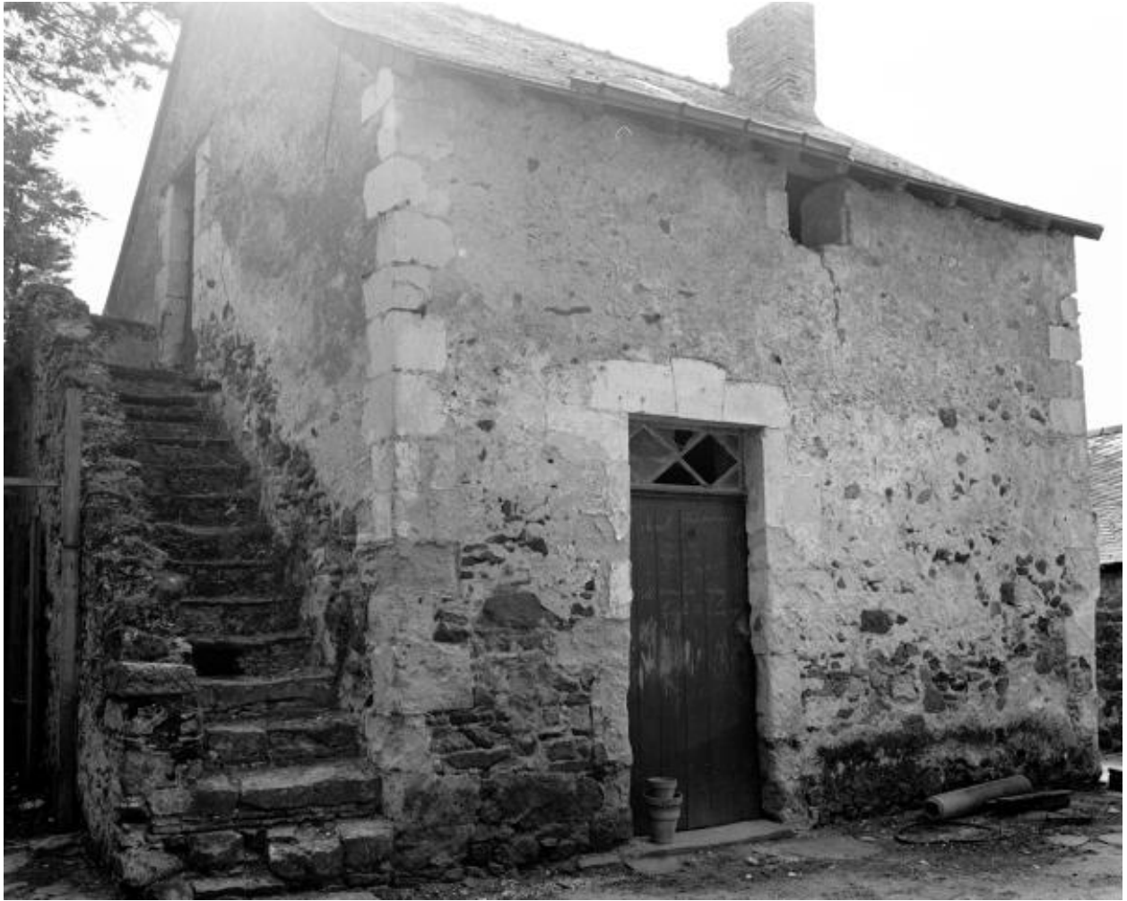
Maison, 1 rue de la Repiellerie, logement sur cour, 1985.
