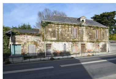
Vue d'ensemble de la maison 6 rue d'Anjou. Phot. Armelle Maugin IVR52_20254900196NUCA
