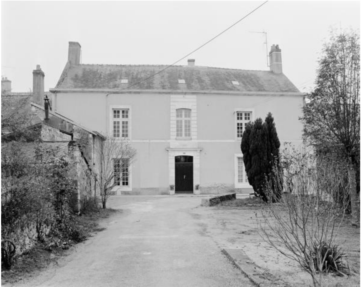
Maison, 7 quai des Mariniers, 1985.
