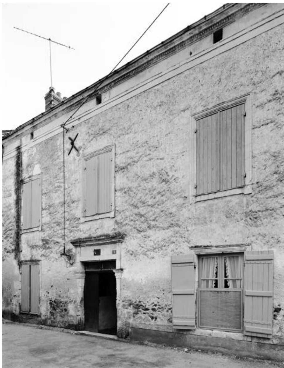
Maison, 1 rue de la Repiellerie, façade sur rue, 1985.
