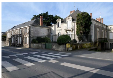
Vue d'ensemble du 2 et 4 rue d'Anjou. Phot. Armelle Maugin IVR52_20254900192NUCA
