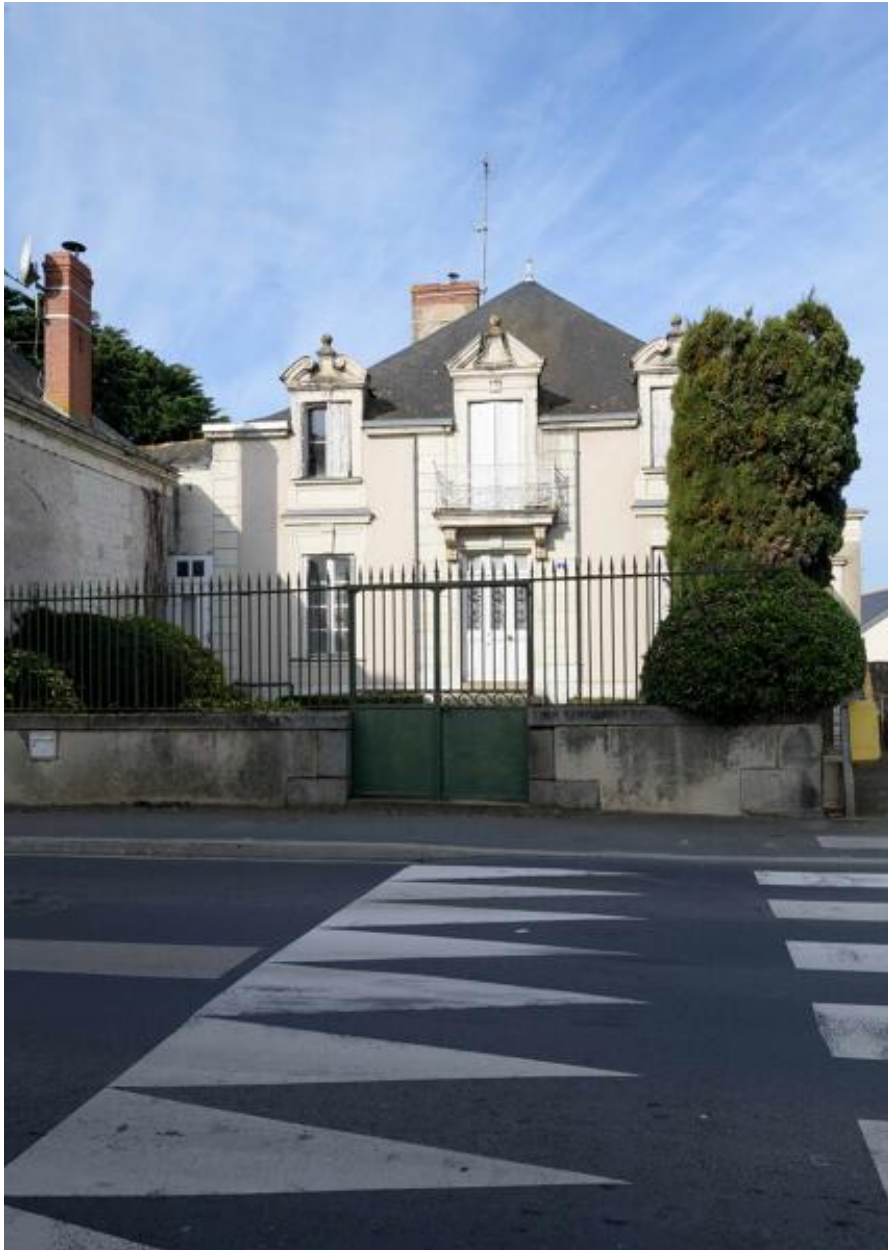
Vue d'ensemble de la maison du 2 rue d'Anjou (bâtie en 1850, augmentée en 1877).
