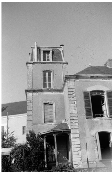
Maison, 6 rue de la Perrière, 1985. Phot. Marie-Anne Eon IVR52_19724900357Z
