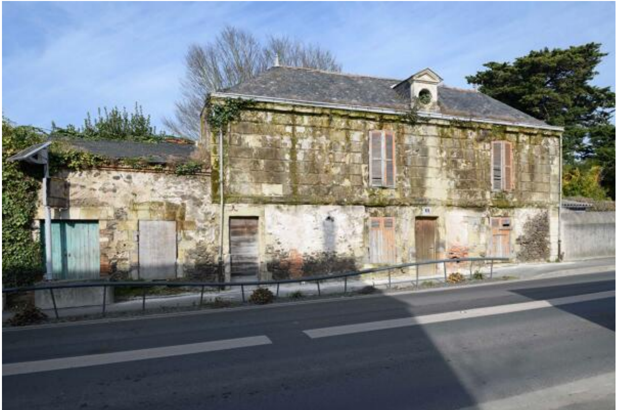
Vue d'ensemble de la maison 6 rue d'Anjou.
