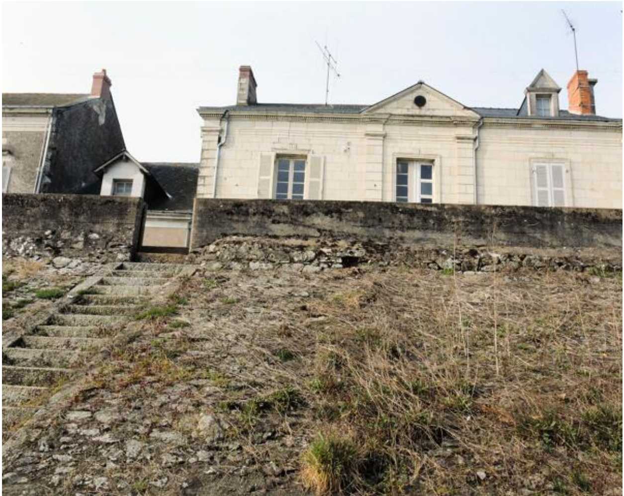
Maison, 12-13 quai Monseigneur-Provost, lucarne à fronton triangulaire vue depuis les berges de la Loire, 1992.
