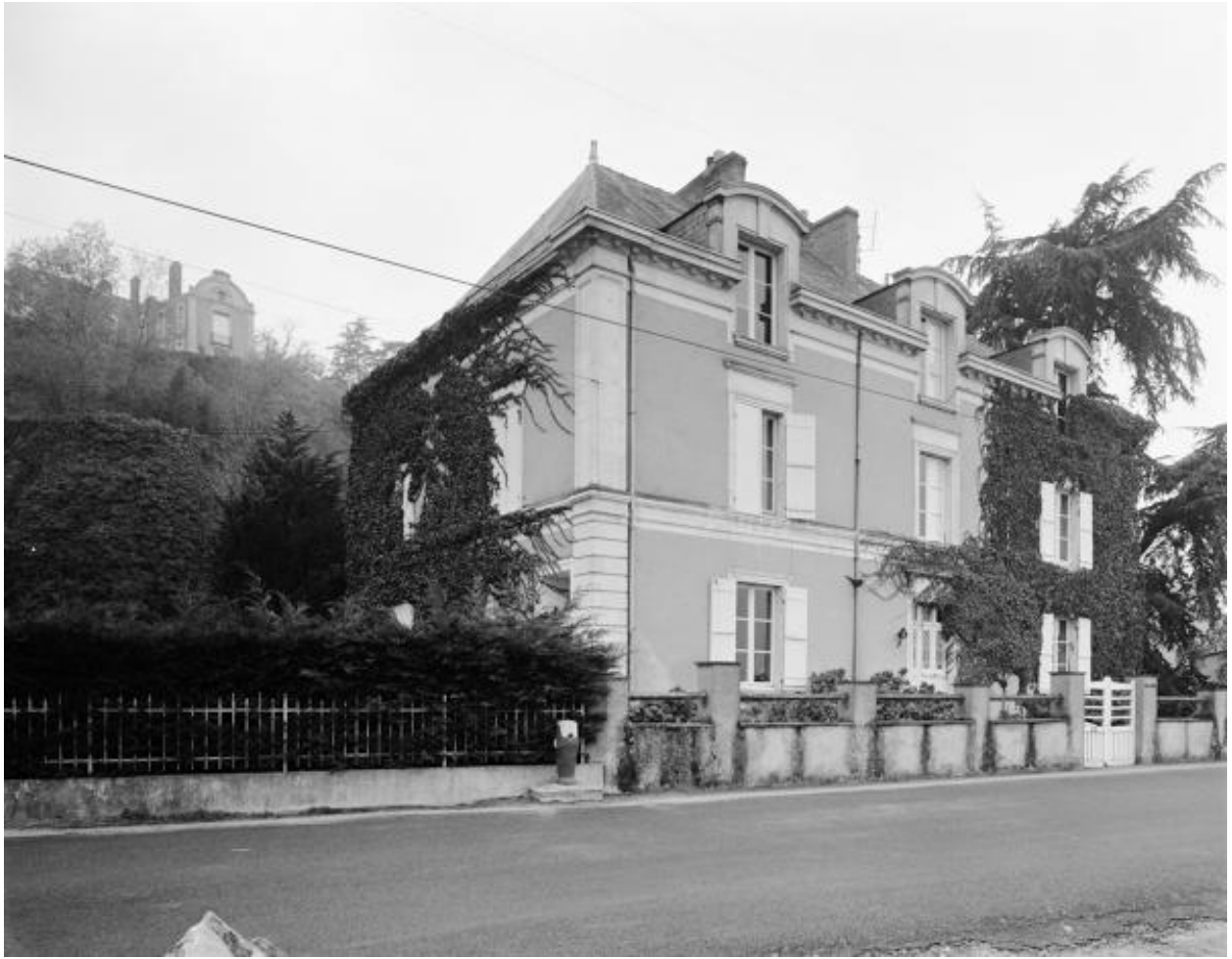
Maison de maître-chaufournier, chauxfournerie du Rivage, 33 quai Monseigneur-Provost, 1985.
