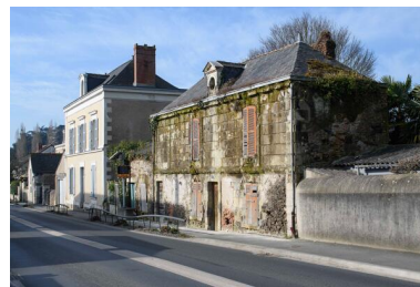
Vue d'ensemble des maisons du 6 et 10 rue d'Anjou. Phot. Armelle Maugin IVR52_20254900195NUCA
