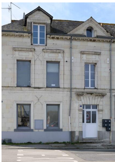
Vue de la maison du 1 Quai des Mariniers, partie est. Phot. Armelle Maugin IVR52_20254900220NUCA
