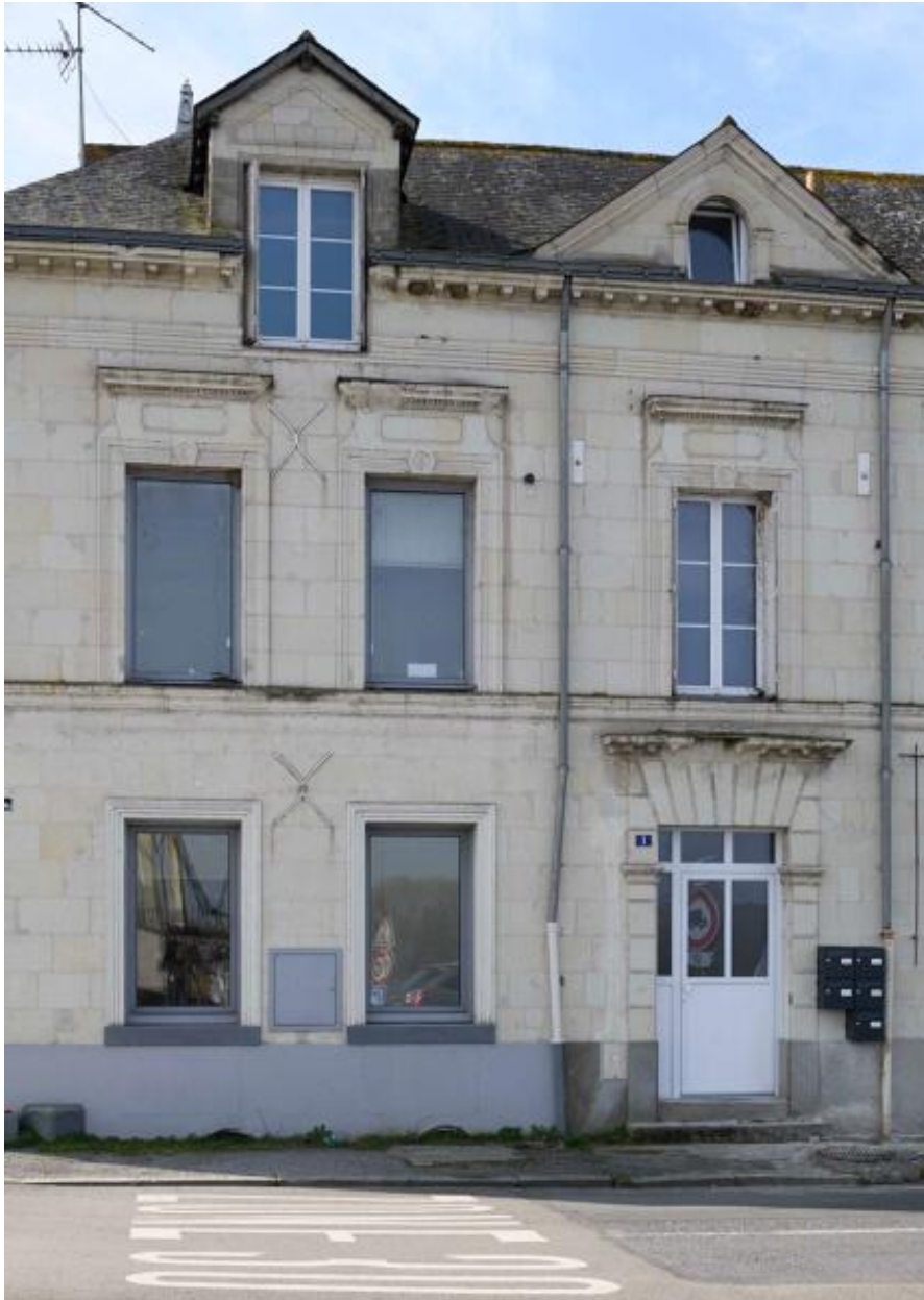
Vue de la maison du 1 Quai des Mariniers, partie est.
