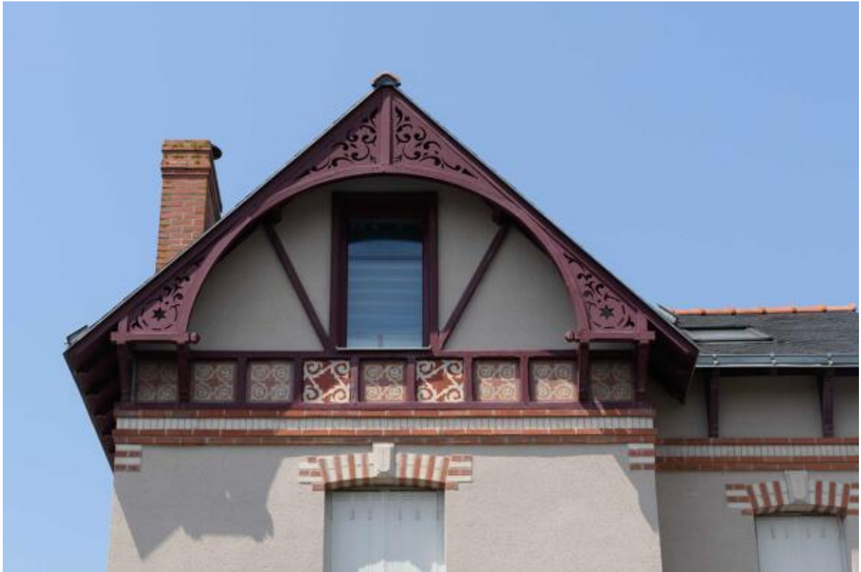
Détail, frise et lambrequin, de la façade principale du 6 avenue Jeanne-d'Arc.
