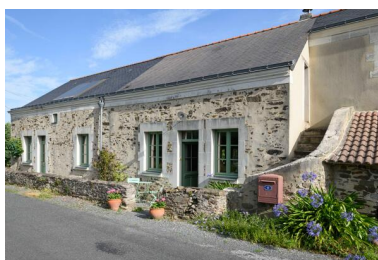
Ferme, le Pressoir (1829). Phot. Armelle Maugin IVR52_20244900533NUCA
