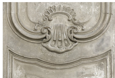
Détail d'un motif ornemental. Phot. Patrice Giraud IVR52_20078500613NUCA
