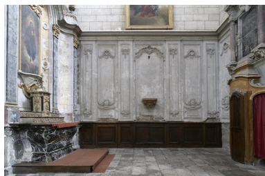
Revêtement intérieur, vue d'ensemble. Phot. Patrice Giraud IVR52_20078500611NUCA
