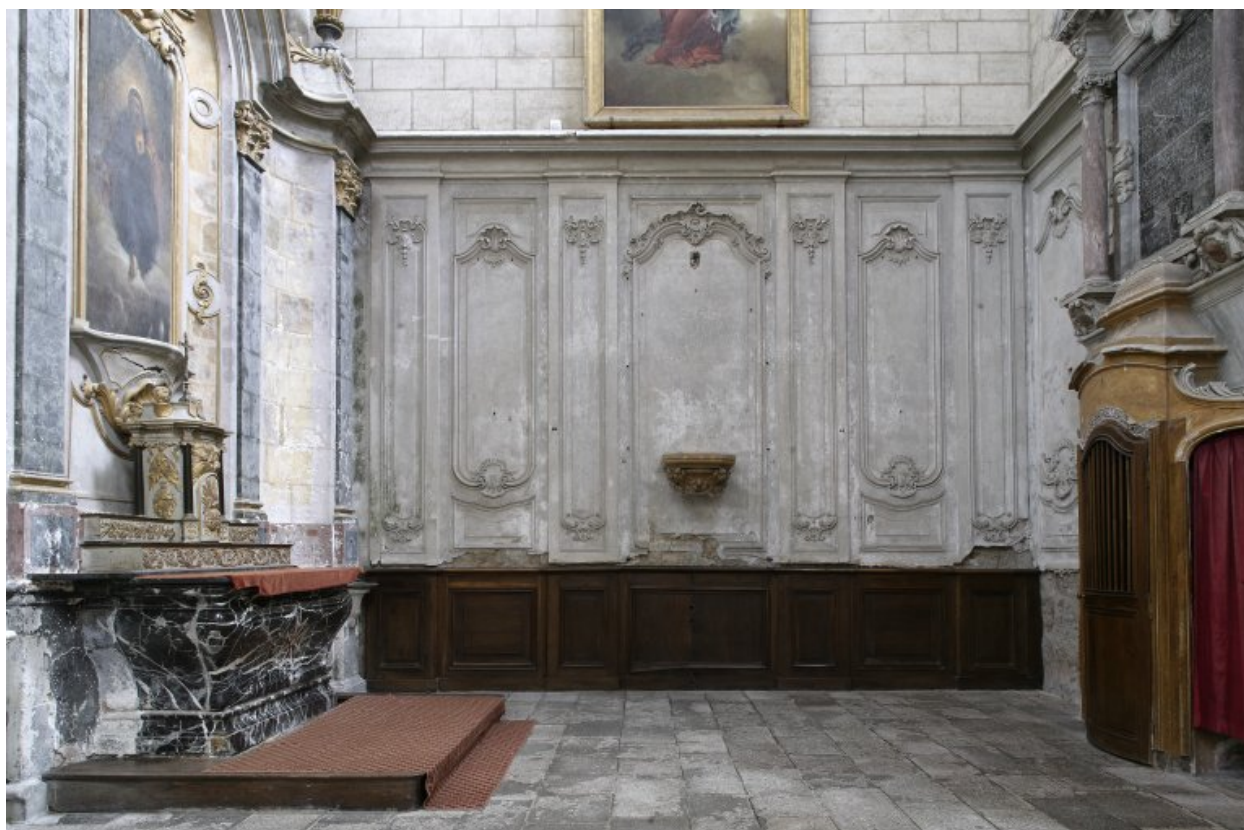
Revêtement intérieur, vue d'ensemble.
