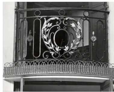
Vestibule, balcon de droite, détail du garde corps. Phot. François Lasa IVR52_19804900273X
