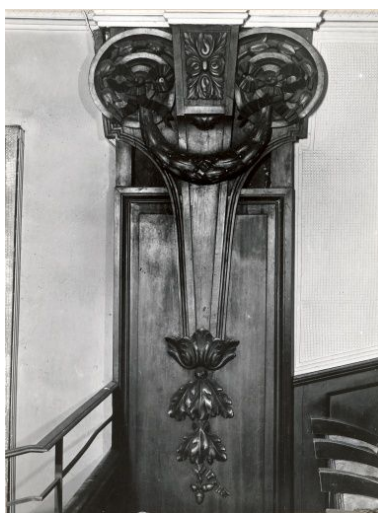
Salle de spectacle, détail d'un pilastre en bois ciré. Phot. François Lasa IVR52_19804900275X
