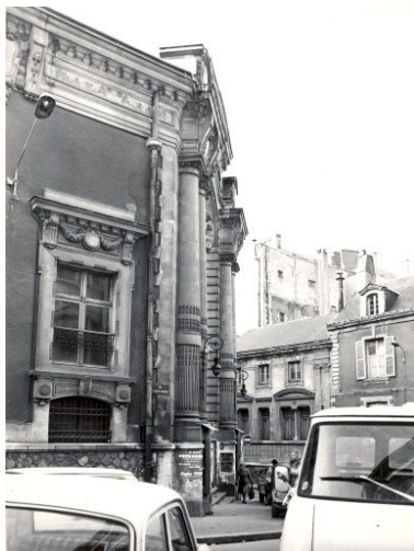
Façade antérieure, profil. Phot. François Lasa IVR52_19804900289X
