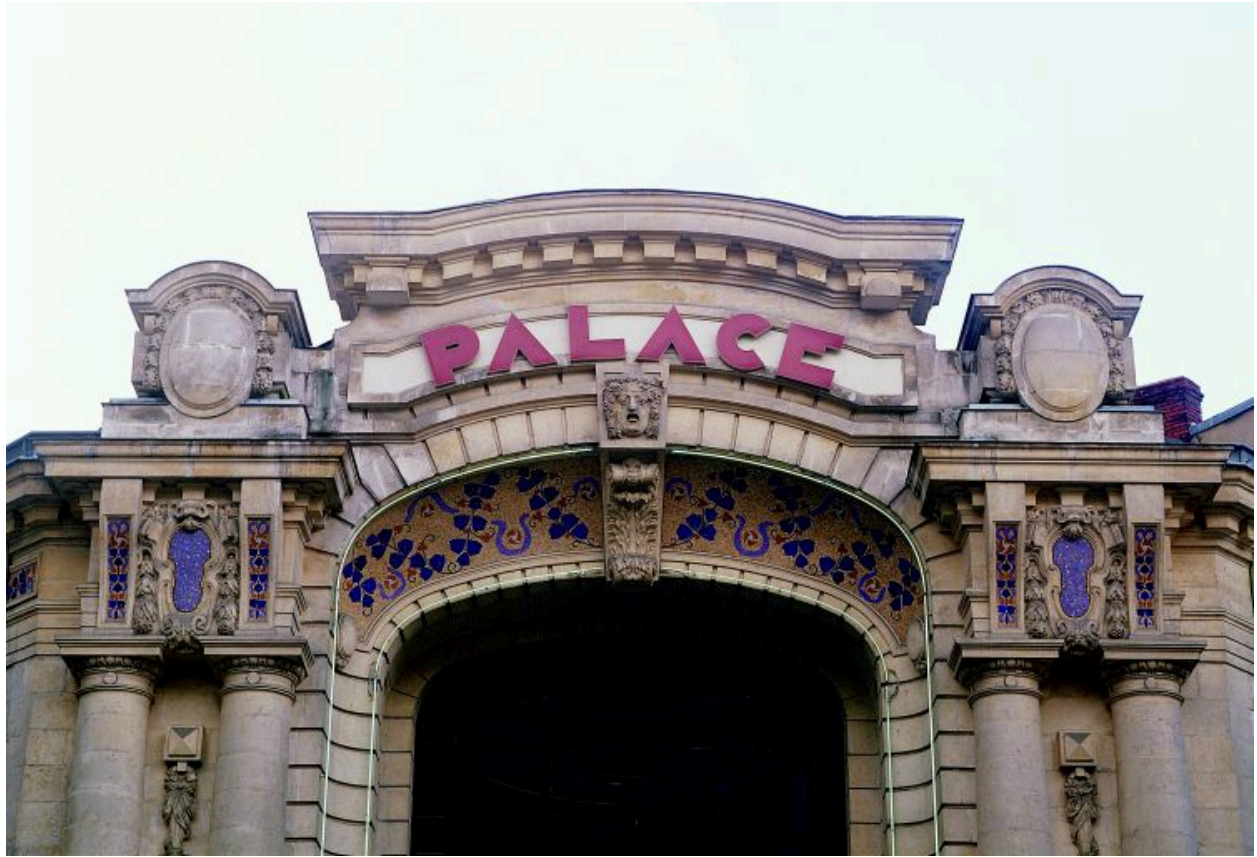
Portail : vue d'ensemble de la partie supérieure.
