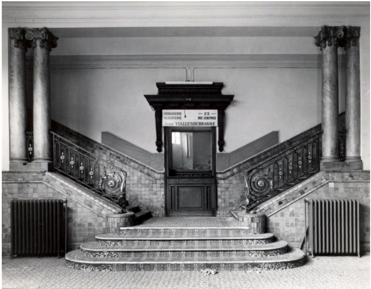
Vestibule, l'escalier d'honneur.
