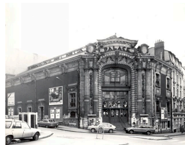
Vue d'ensemble. Phot. François Lasa IVR52_19804900258V
