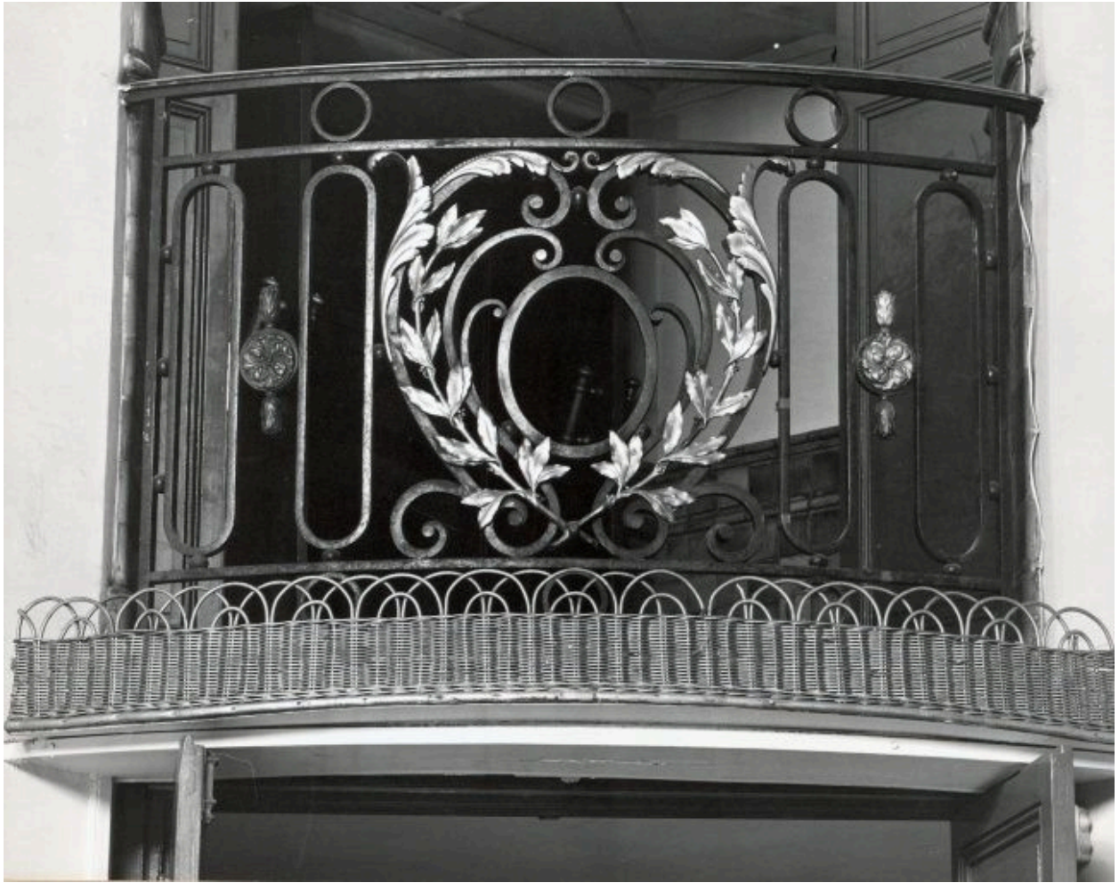
Vestibule, balcon de droite, détail du garde corps.
