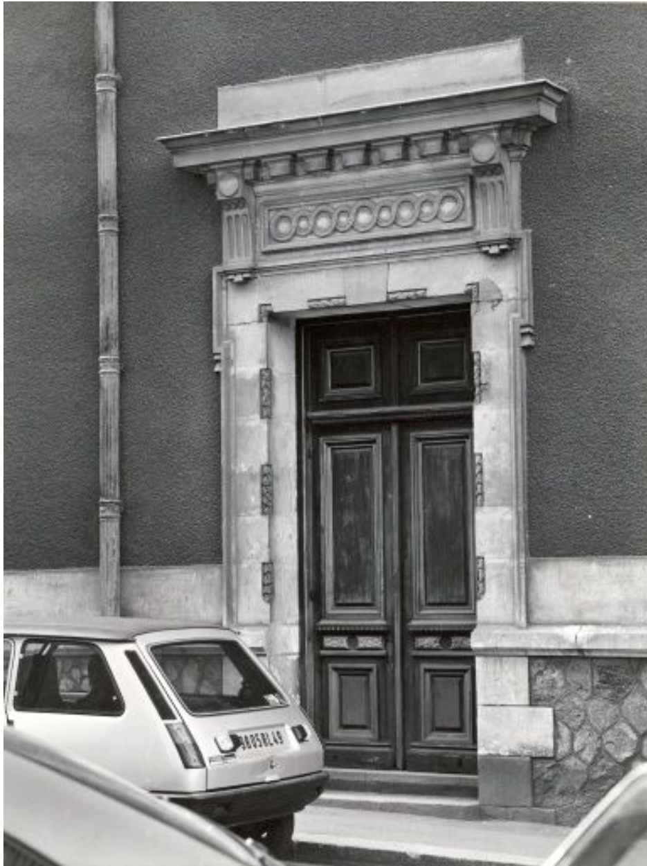
Façade latérale gauche, accès à la salle.
