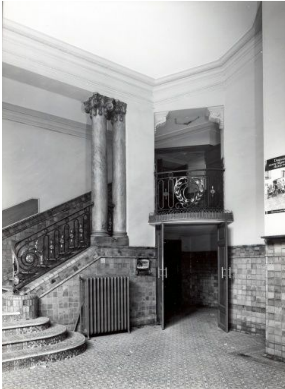
Vestibule, angle nord-ouest.
