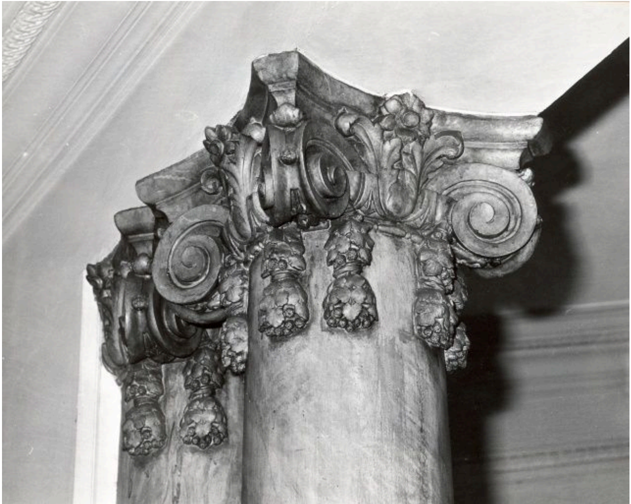
Escalier d'honneur : détail des colonnes jumelées.
