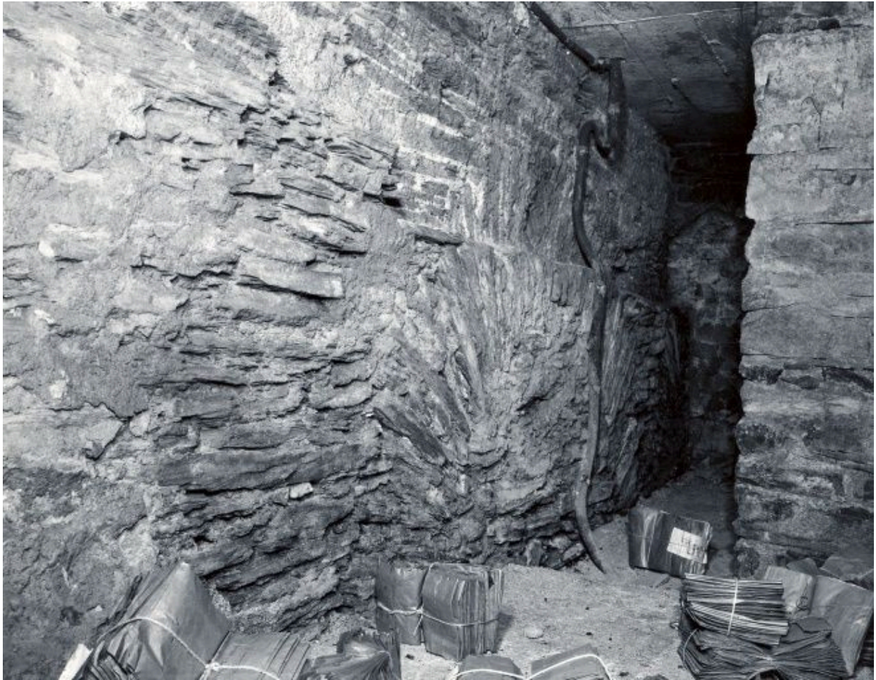
Second sous-sol, arc de schiste.
