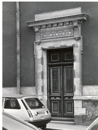
Façade latérale gauche, accès à la salle. Phot. François Lasa IVR52_19804900285X
