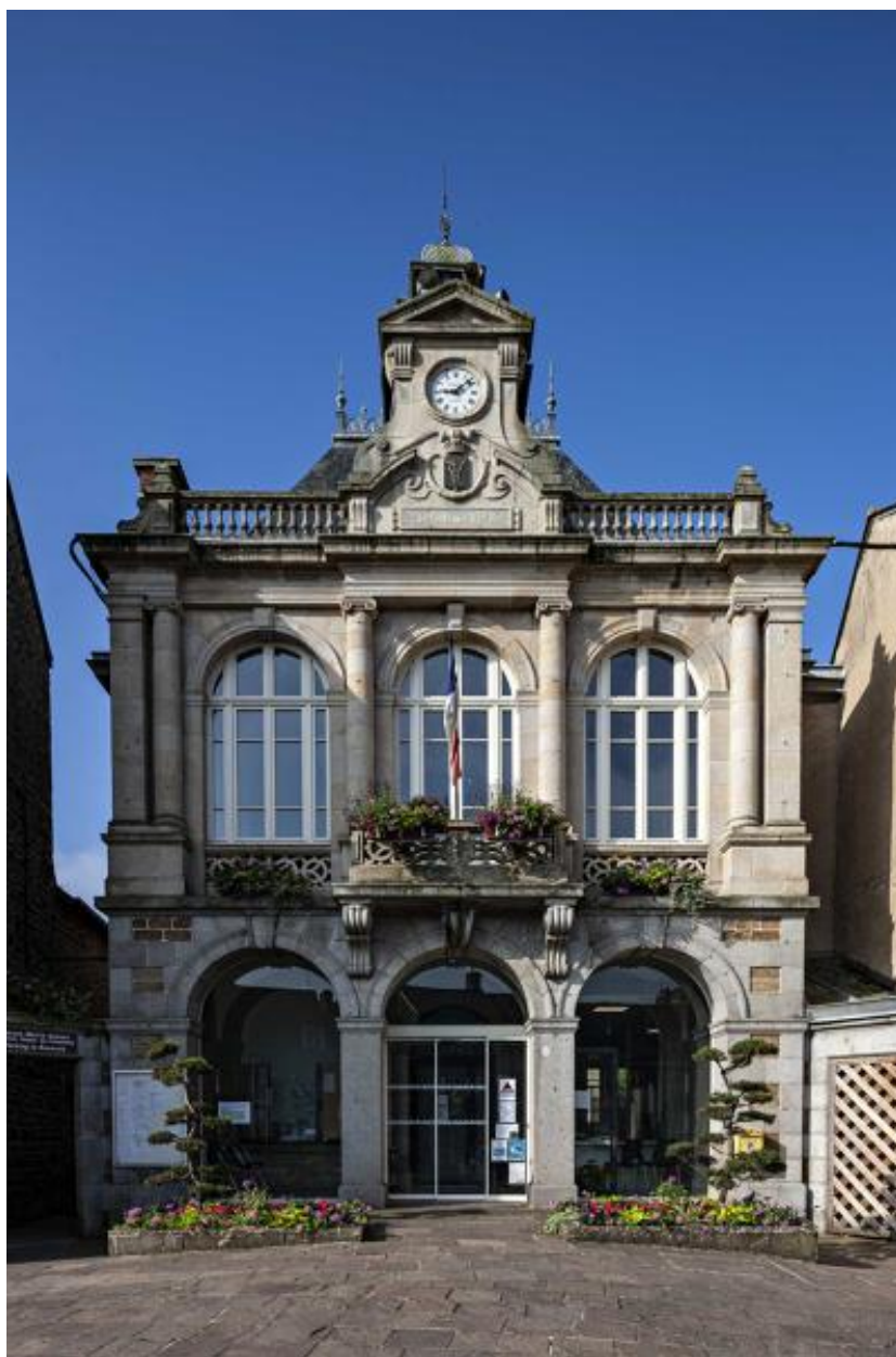
Mairie de Lassay, façade principale.
