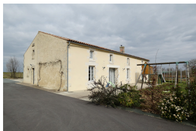
Le logis et les dépendances accolées vues depuis le sud-ouest.
