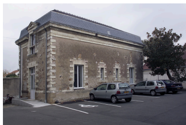
La façade postérieure de l'ancienne conciergerie. Phot. Denis Pillet IVR52_20034401933NUCA
