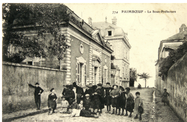
Vue prise depuis la rue de l'Eglise (1er quart XXe siècle). Autr. Vassellier, Phot. Denis (reproduction) Pillet IVR52_20034401717NUCA
