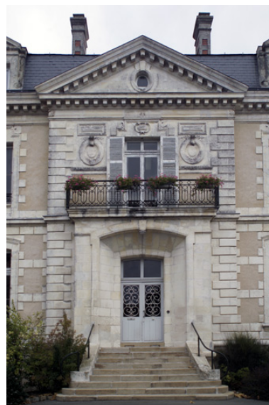
La façade sud, détail de l'avant-corps. Phot. Denis Pillet IVR52_20034401922NUCA
