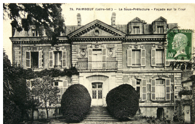
Vue de la façade sud (1er quart XXe siècle). Phot. Denis (reproduction) Pillet IVR52_20034401718NUCA
