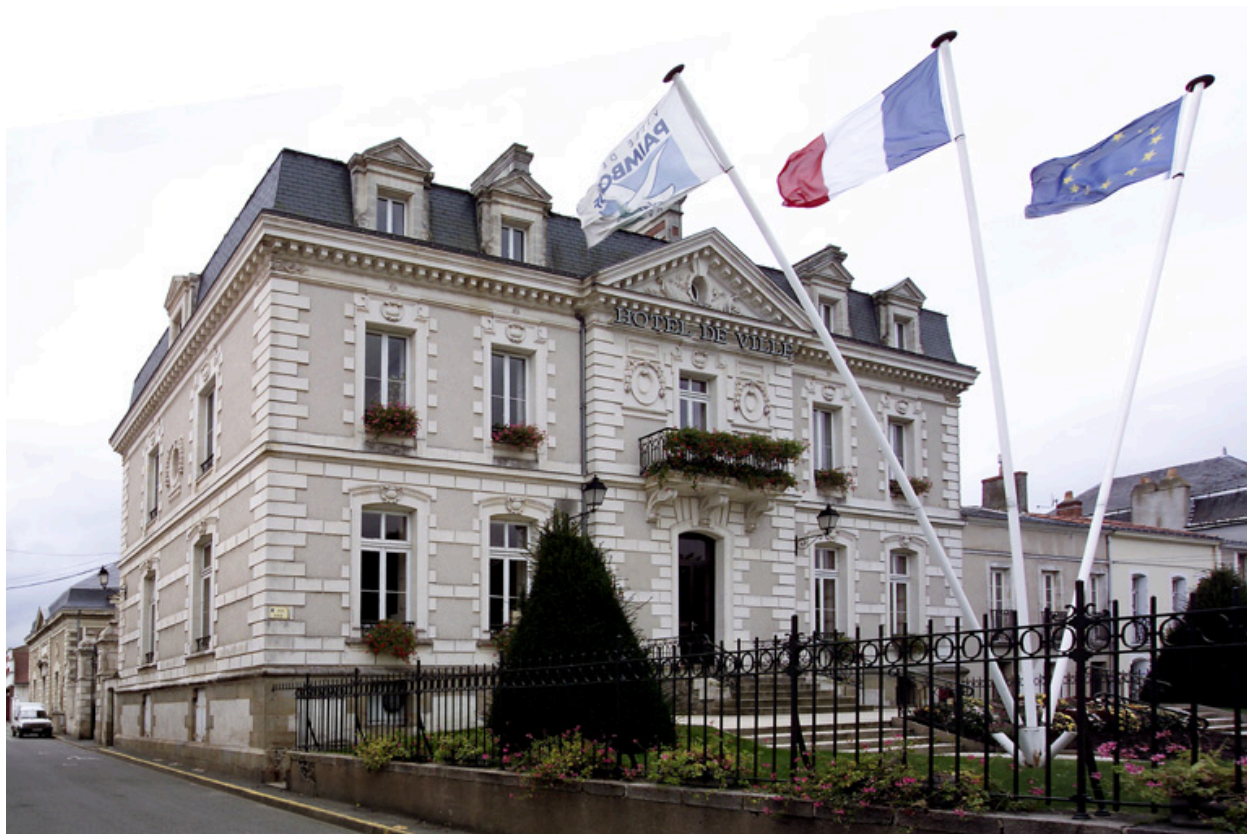
La façade nord.
