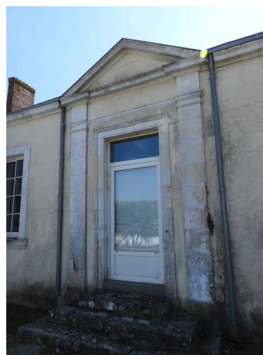
La porte centrale nord de la salle des fêtes. Phot. Yannis Suire IVR52_20188501384NUCA
