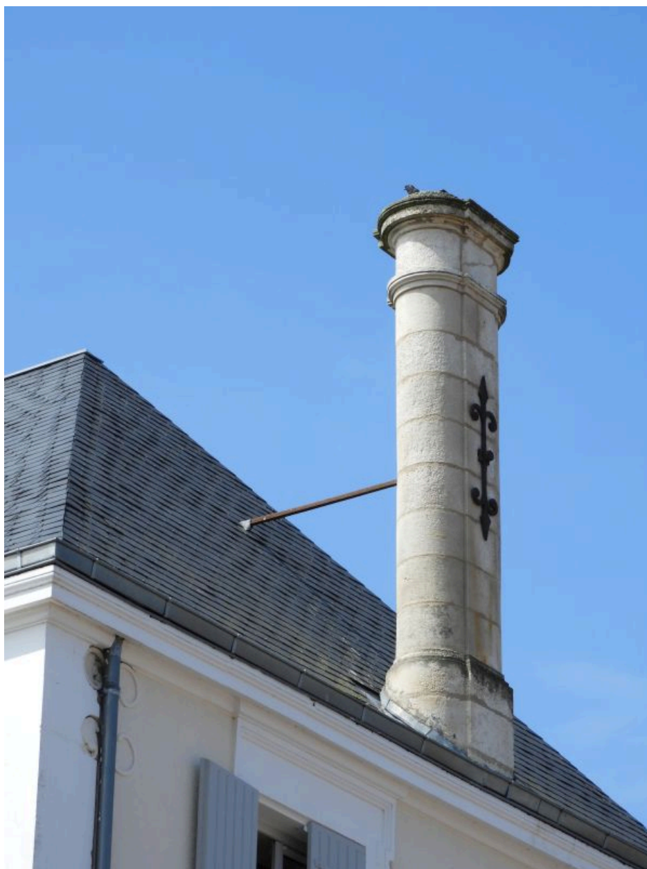
La souche de cheminée
