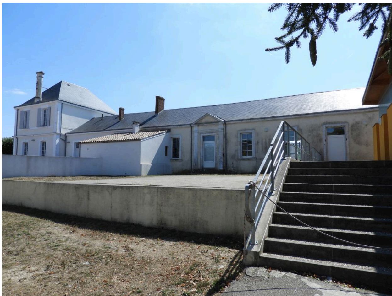
Les bâtiments vus depuis le nord.
