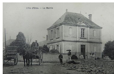
La mairie vue depuis le sud-est vers 1900. Phot. Yannis (reproduction) Suire IVR52_20198501038NUCA
