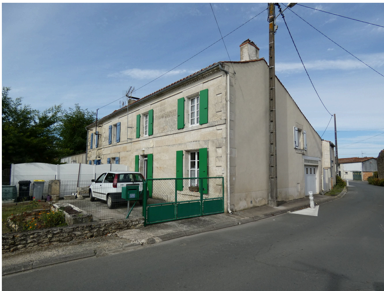
Vue depuis le sud-est.
