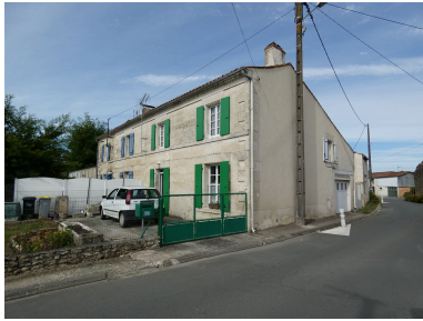
Vue depuis le sud-est. Phot. Yannis Suire IVR52_20228500454NUCA
