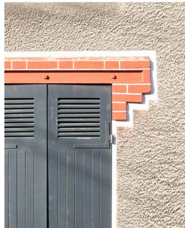
Détail d'un linteau métallique et encadrement de brique sur une fenêtre d'une maison de la collectivité.
