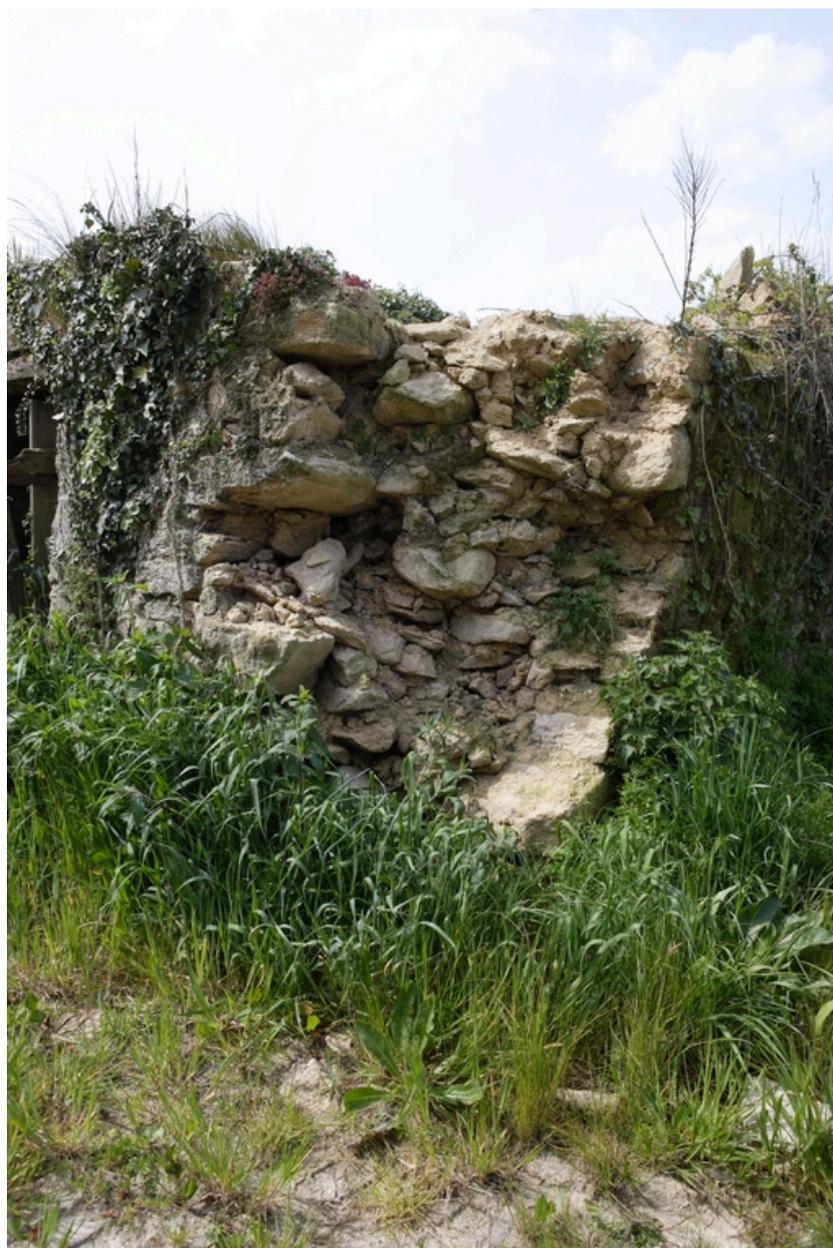
Détail du blocage du mur en moellons de granite et en terre.
