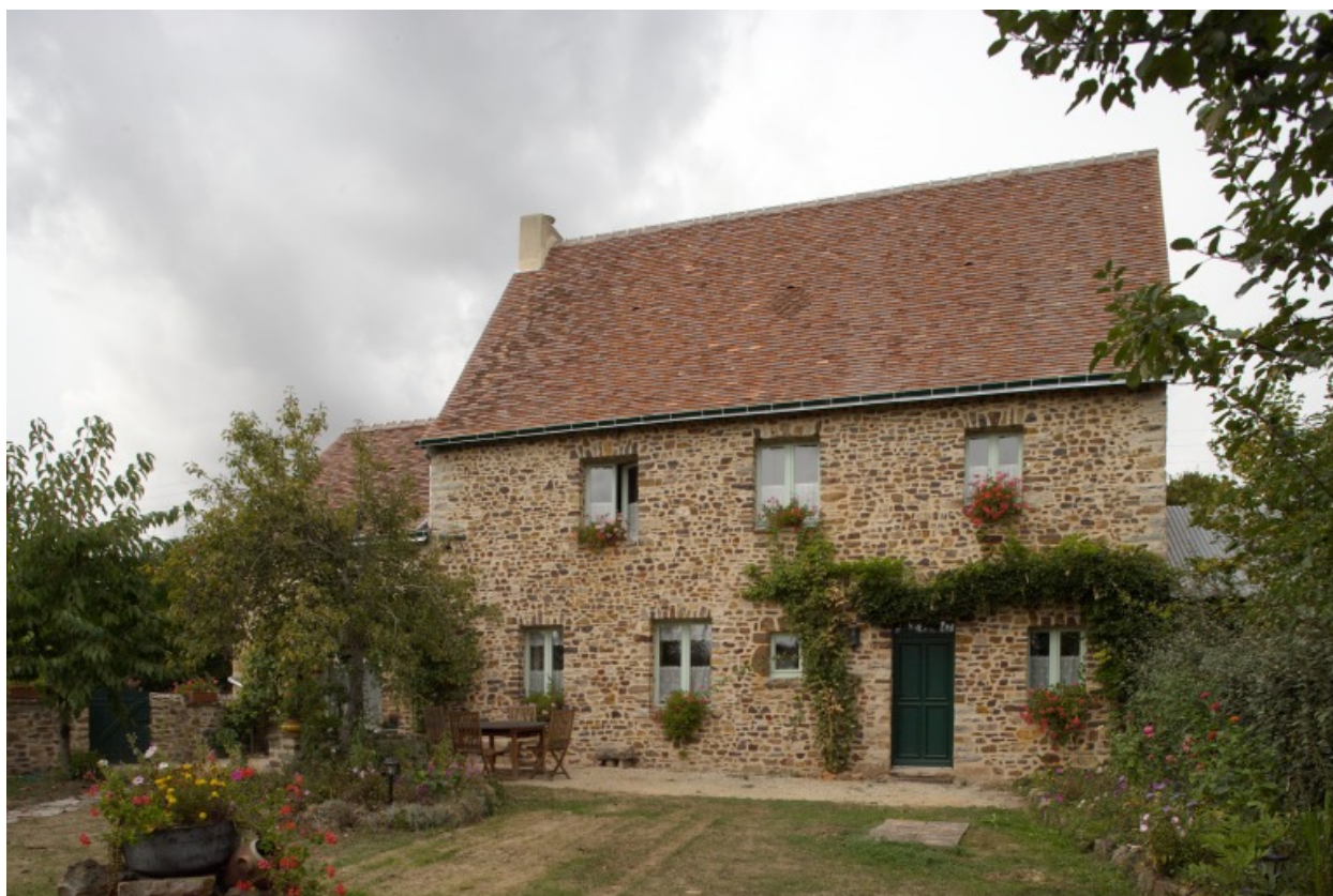
Vue actuelle de la façade principale depuis le jardin.
