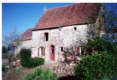
Photographie, vers 1985. Vue avant travaux de la façade principale depuis le jardin à l'est. Autr. Dominique Tavenon, Repro. François Lasa IVR52_20055302114NUCA
