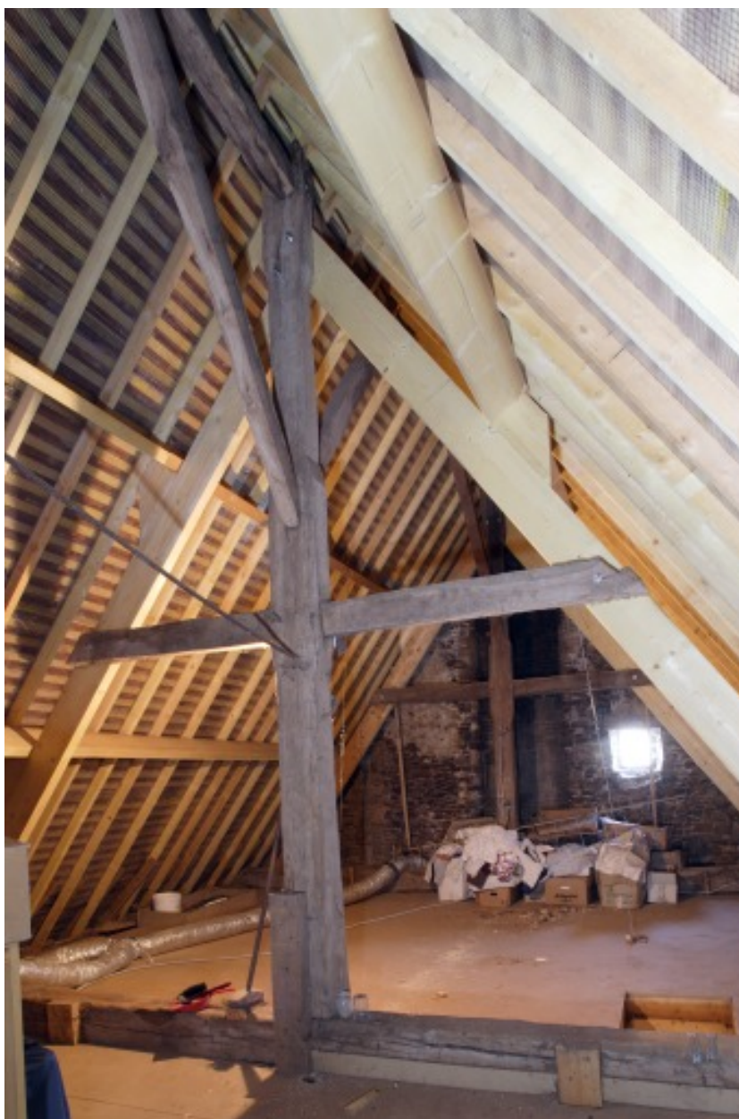
Vue après travaux de la charpente depuis l'ouest.
