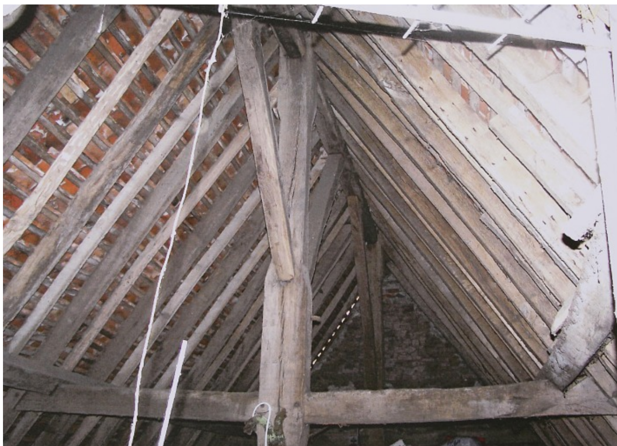
Photographie, 2005. La partie supérieure de la ferme centrale de la charpente vue depuis l'ouest avant travaux.
