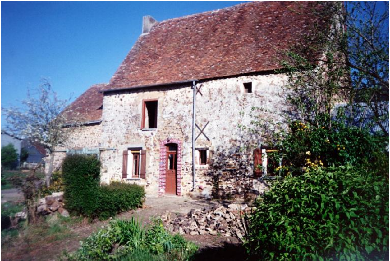
Photographie, vers 1985. Vue avant travaux de la façade principale depuis le jardin à l'est.
