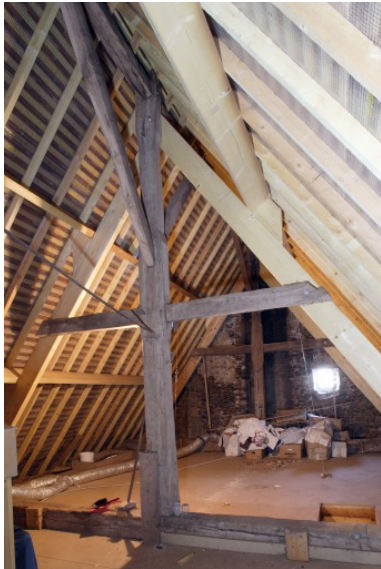
Vue après travaux de la charpente depuis l'ouest. Phot. François Lasa IVR52_20055302132NUCA
