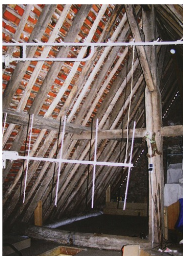
Photographie, 2005. La ferme centrale de la charpente vue depuis l'ouest avant travaux.
