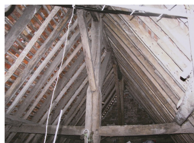
Photographie, 2005. La partie supérieure de la ferme centrale de la charpente vue depuis l'ouest avant travaux. Autr. Nicolas Foisneau, Phot. François Lasa IVR52_20055302263NUCA
