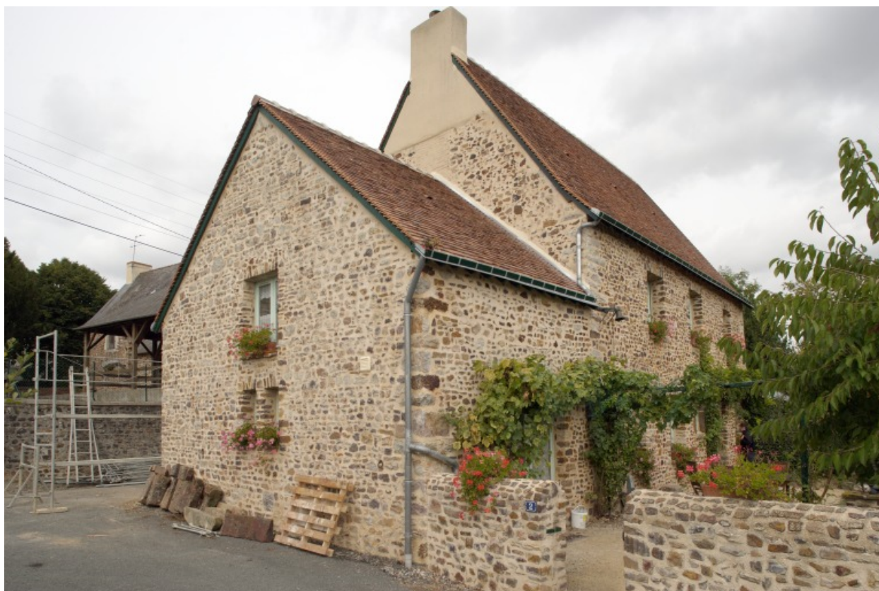
Vue de la façade principale et des murs pignons ouest depuis la ruelle.
