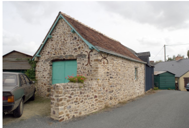
La remise vue depuis la ruelle. Phot. François Lasa IVR52_20055302110NUCA
