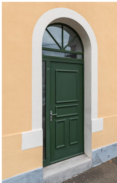
Vue d'une porte piétonne de la caserne Mangin. Phot. Thierry Seldubuisson IVR52_20227200911NUCA
