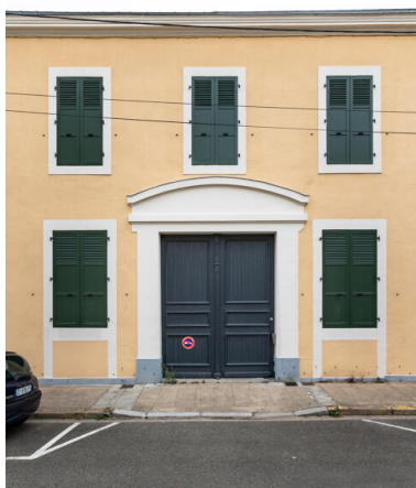
Vue d'une porte cochère de la caserne Mangin. Phot. Thierry Seldubuisson IVR52_20227200909NUCA
