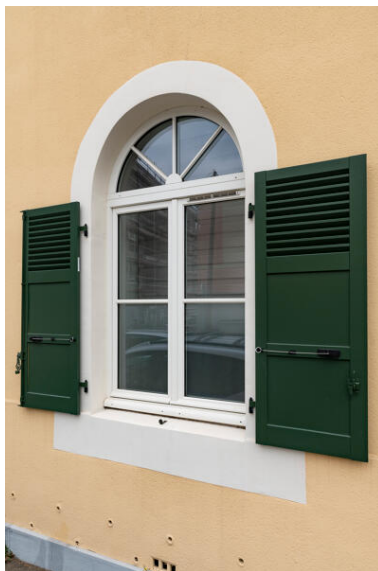
Vue d'une fenêtre de la caserne Mangin. Phot. Thierry Seldubuisson IVR52_20227200912NUCA
