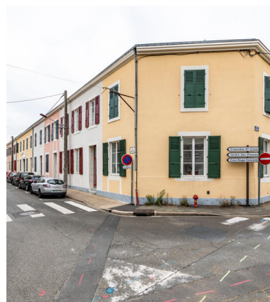
Vue de l'aile ouest de la caserne Mangin. Phot. Thierry Seldubuisson IVR52_20227200910NUCA
