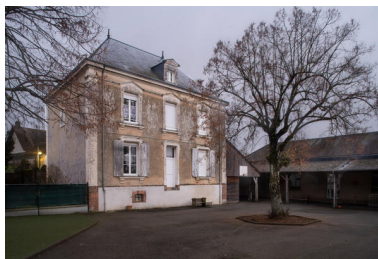
Élévation postérieure. Phot. Thierry Seldubuisson IVR52_20247200028NUCA
