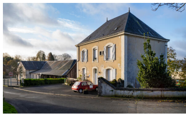
Elévation principale et mur-pignon. Phot. Thierry Seldubuisson IVR52_20237201982NUCA
