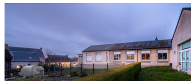
Bâtiment des classes de 1932-1933, identifiable à son décor de briques, et des extensions réalisées entre 1994 et 2002. Phot. Thierry Seldubuisson IVR52_20247200029NUCA
