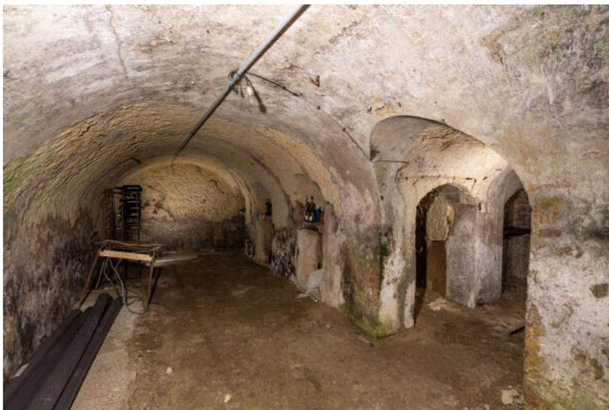
Cellier troglodytique (ouest) : intérieur.
