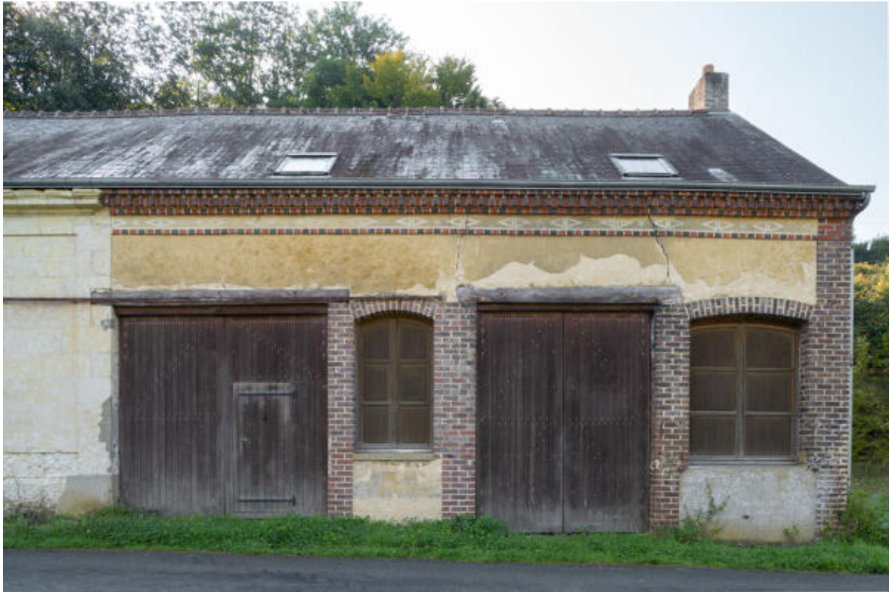
Façade de la maréchalerie.
