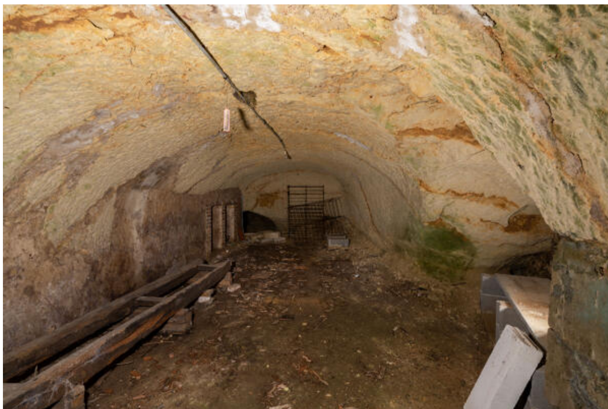
Cellier troglodytique (est) : vue intérieure.
