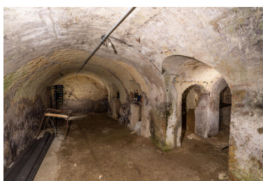
Cellier troglodytique (ouest) : intérieur. Phot. Jeanne Minier IVR52_20257200514NUCA
