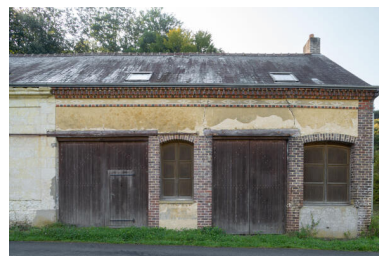
Façade de la maréchalerie. Phot. Jeanne Minier IVR52_20257200700NUCA
