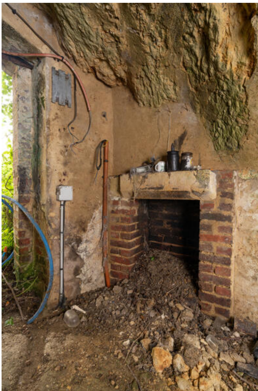
Cellier troglodytique (est) : cheminée.
