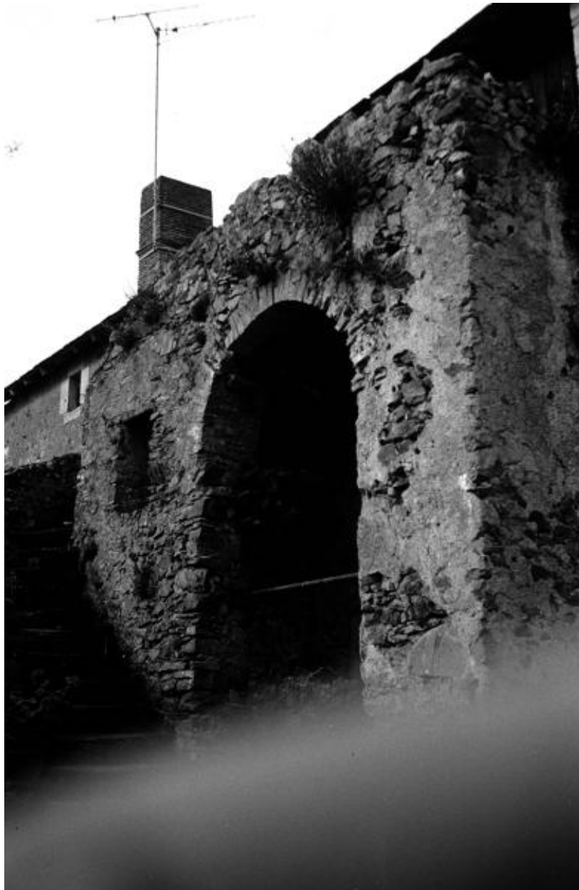
Escalier et voûte en brique, 1972.
