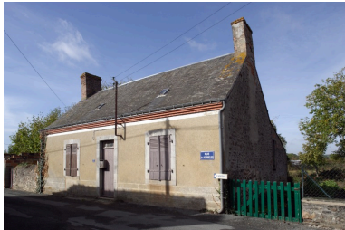
Vue depuis la route de Chammes. Phot. François Lasa IVR52_20055302041NUCA
