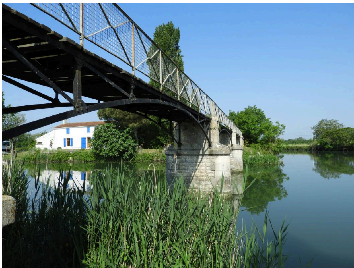
La passerelle vue depuis la rive gauche de la Vieille Sèvre, côté amont, au nord-est.
