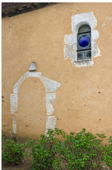
Ancienne porte vers le cimetière et fenêtre de l'élévation nord. Phot. Yves Guillotin IVR52_20107202277NUCA
