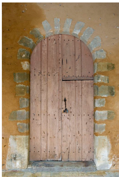
Portail ouest. Phot. Yves Guillotin IVR52_20107202274NUCA
