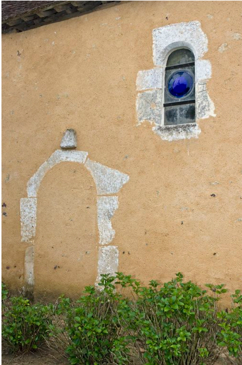
Ancienne porte vers le cimetière et fenêtre de l'élévation nord.
