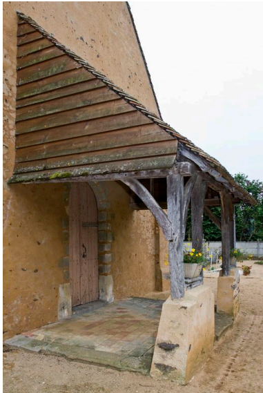
Porche d'entrée ouest (balet). Phot. Yves Guillotin IVR52_20107202275NUCA
