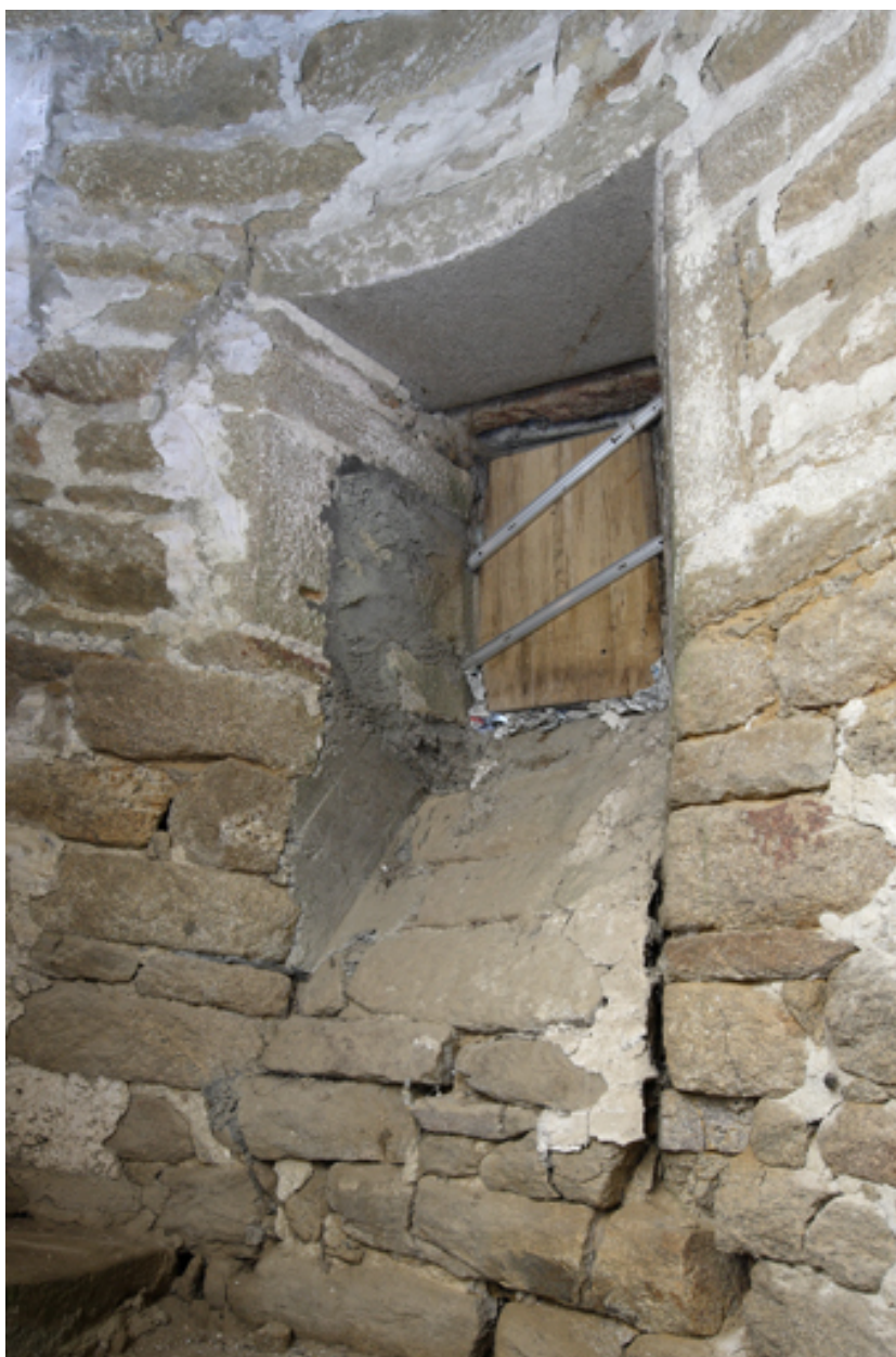
Logis. Tour d'escalier. 1er niveau. Jour d'éclairage.
