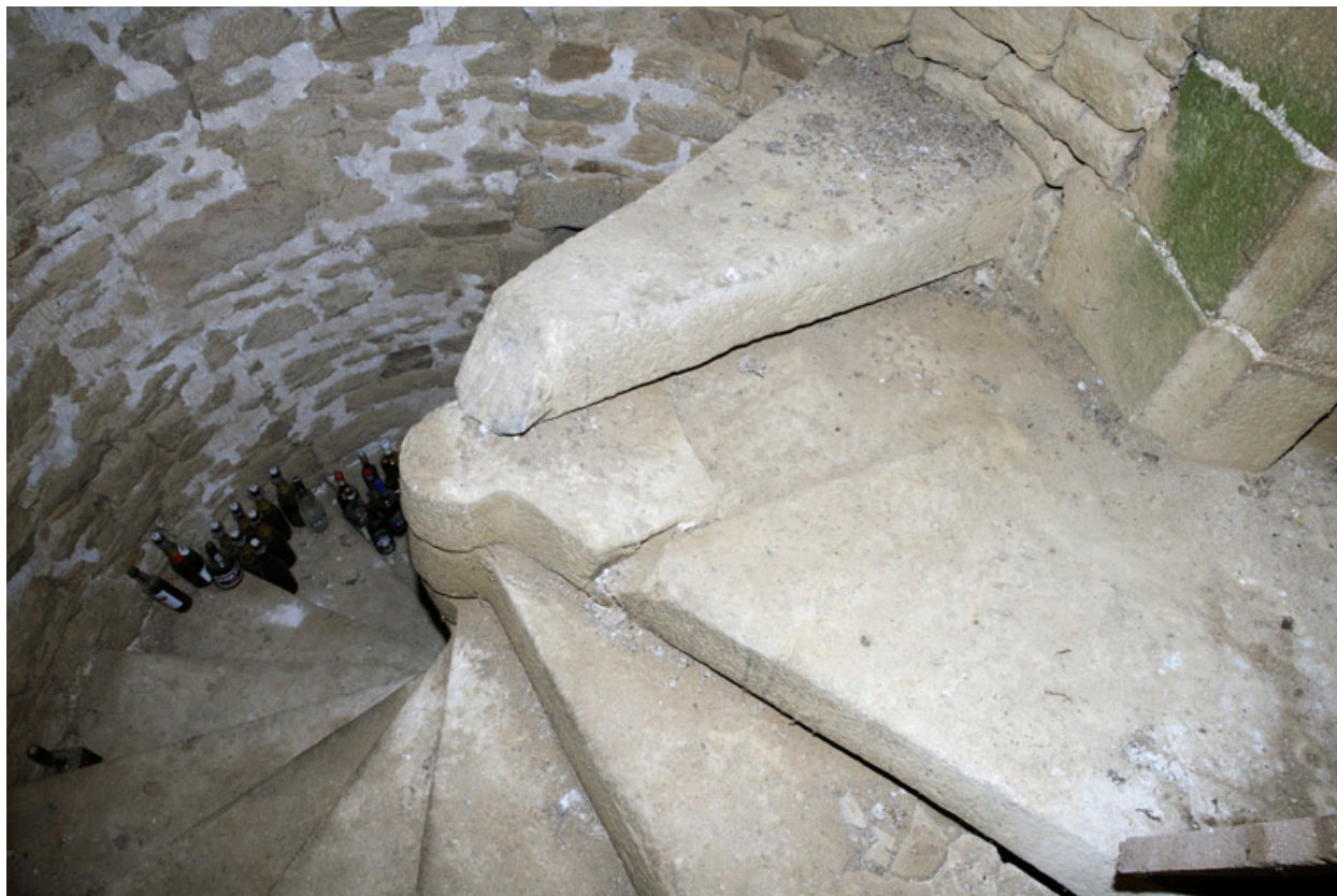
Logis. Tour d'escalier. Vue du dernier palier.
