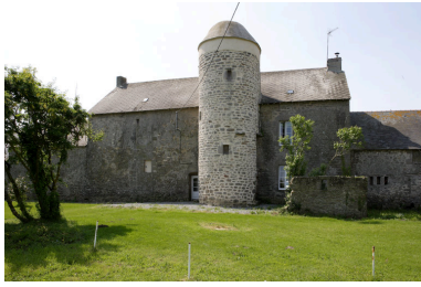
Logis. Vue de la façade nord. Phot. Denis Pillet IVR52_20084401695NUCA
