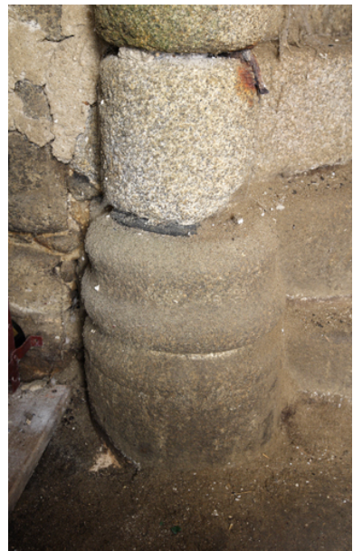
Logis. Tour d'escalier. 1er niveau. Détail de la base du noyau de l'escalier. Phot. Denis Pillet IVR52_20084401676NUCA
