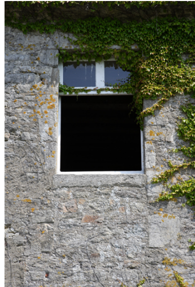
Logis. Façade sud. Croisée au 2e niveau de la 3e travée. Phot. Denis Pillet IVR52_20084401711NUCA
