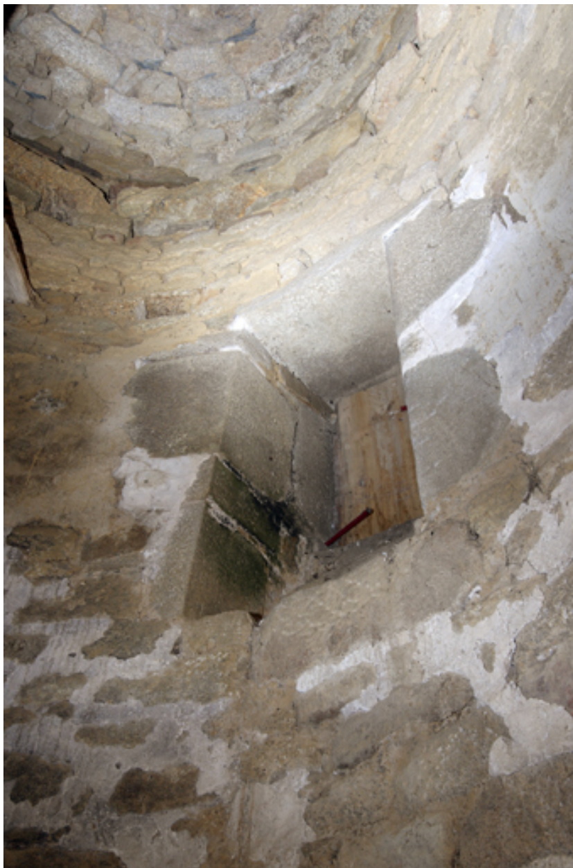
Logis. Tour d'escalier. 3e niveau. Jour d'éclairage.
