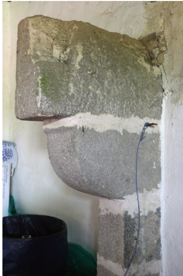
Logis. 2e niveau. Salle est. Détail du corbeau gauche de la cheminée sur le mur pignon est. Phot. Denis Pillet IVR52_20084401687NUCA
