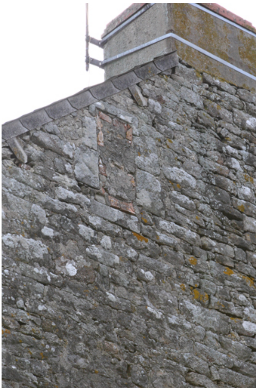
Logis. Pignon ouest. Vestige d'une baie au niveau du comble.
