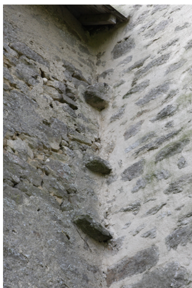
Logis. Façade nord. Détail des pierres d'attente à l'angle du mur gouttereau et de la tour d'escalier. Phot. Denis Pillet IVR52_20084401699NUCA
