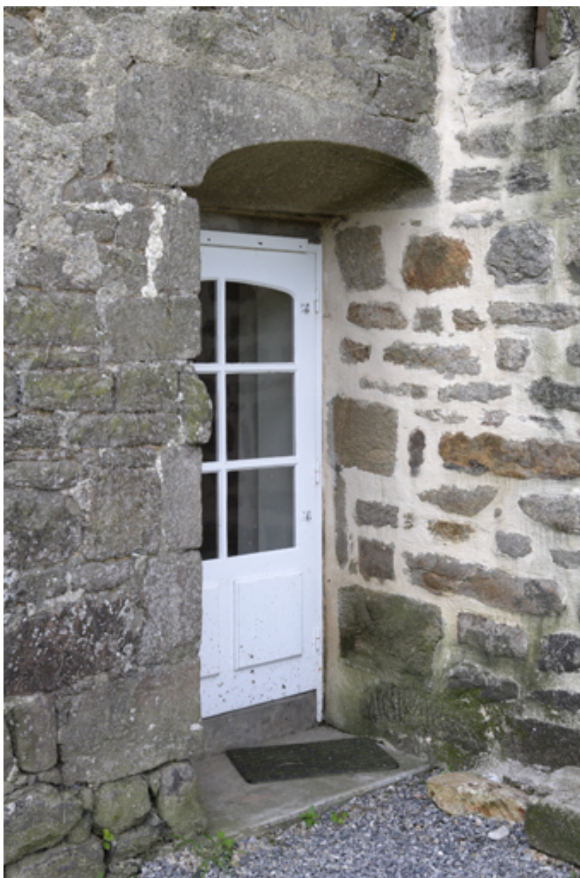
Logis. Façade nord. Porte. 3e travée.
