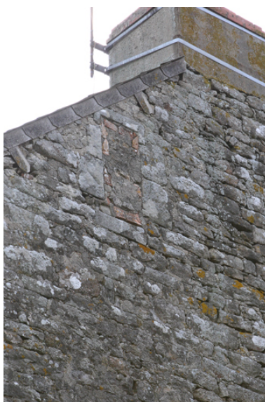
Logis. Pignon ouest. Vestige d'une baie au niveau du comble. Phot. Denis Pillet IVR52_20084401706NUCA
