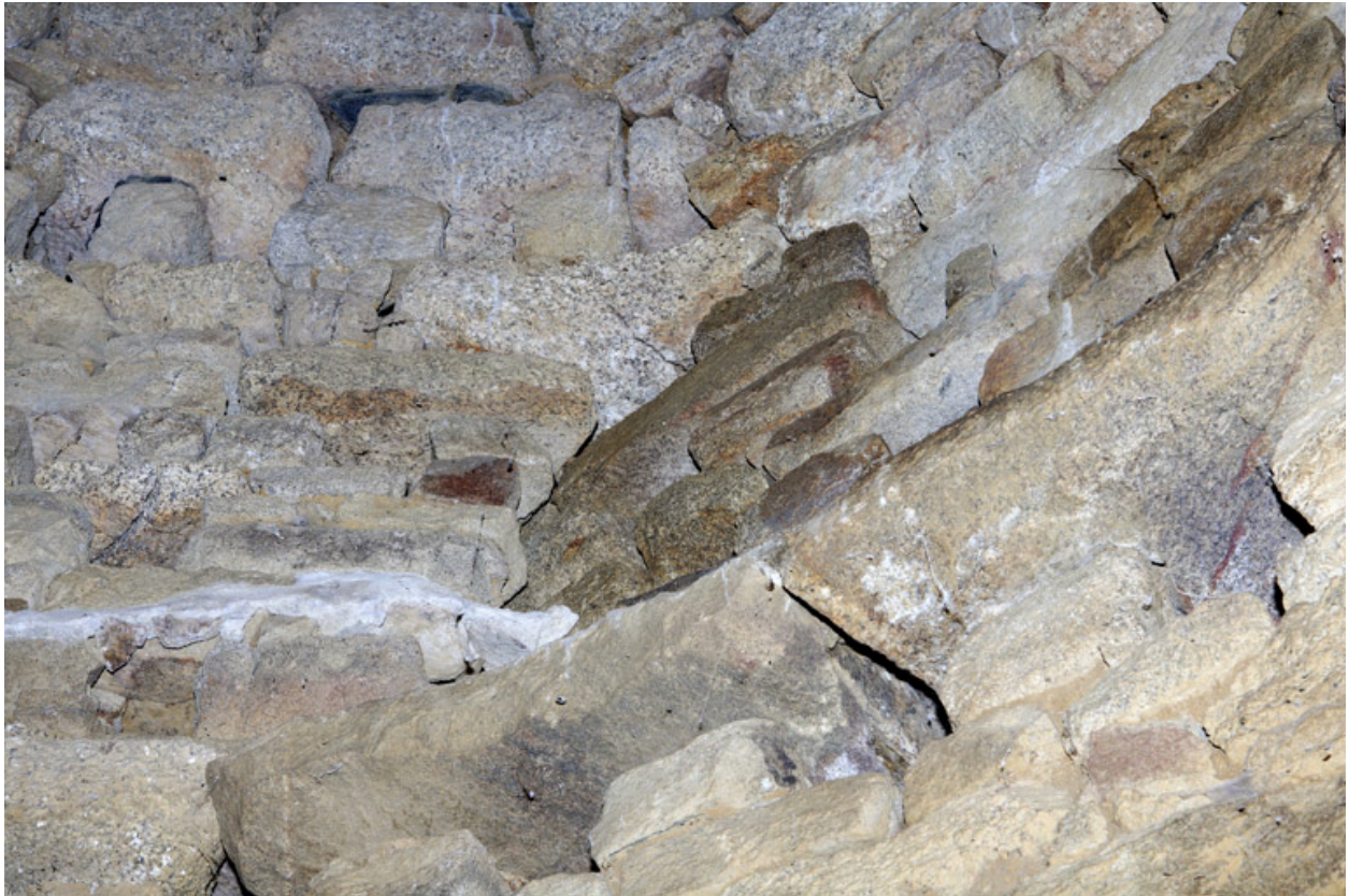
Logis. Tour d'escalier. Détail de l'entrée bouchée pour les pigeons.
