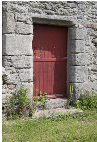
Dépendances. Façade sud. Porte ouest. Phot. Denis Pillet IVR52_20084401710NUCA
