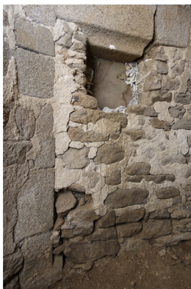
Logis. Tour d'escalier. 1er niveau. Porte ouvrant sur la salle ouest. Phot. Denis Pillet IVR52_20084401677NUCA
