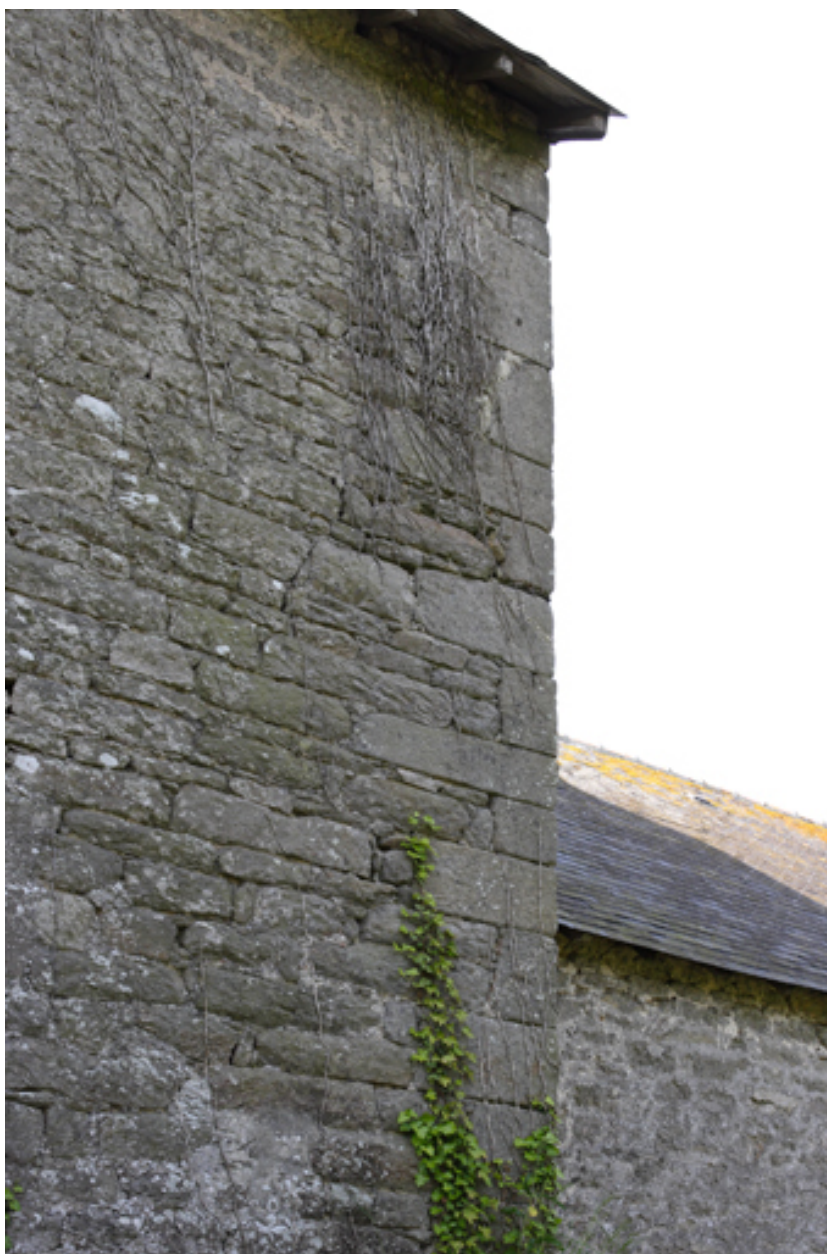
Logis. Façade nord. Détail du chaînage d'angle nord-ouest.
