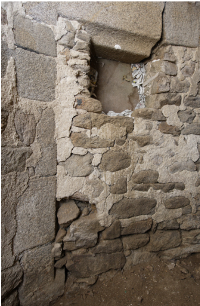
Logis. Tour d'escalier. 1er niveau. Porte ouvrant sur la salle ouest.
