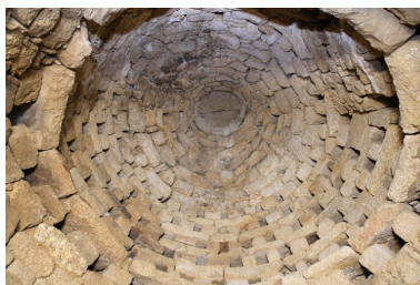
Logis. Tour d'escalier. Pigeonnier. Phot. Denis Pillet IVR52_20084401686NUCA
