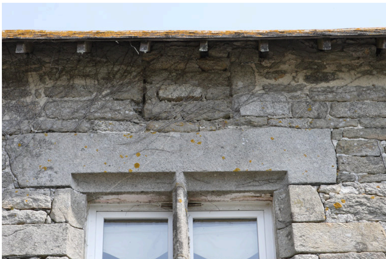
Logis. Façade sud. Ancienne lucarne au 3e niveau de la 1ère travée.
