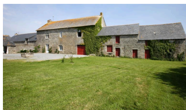
Vue d'ensemble du manoir depuis le sud. Phot. Denis Pillet IVR52_20084401691NUCA
