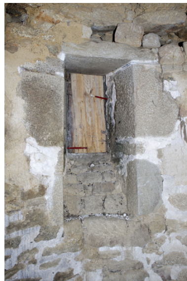
Logis. Tour d'escalier. 3e niveau. Jour d'éclairage. Phot. Denis Pillet IVR52_20084401721NUCA
