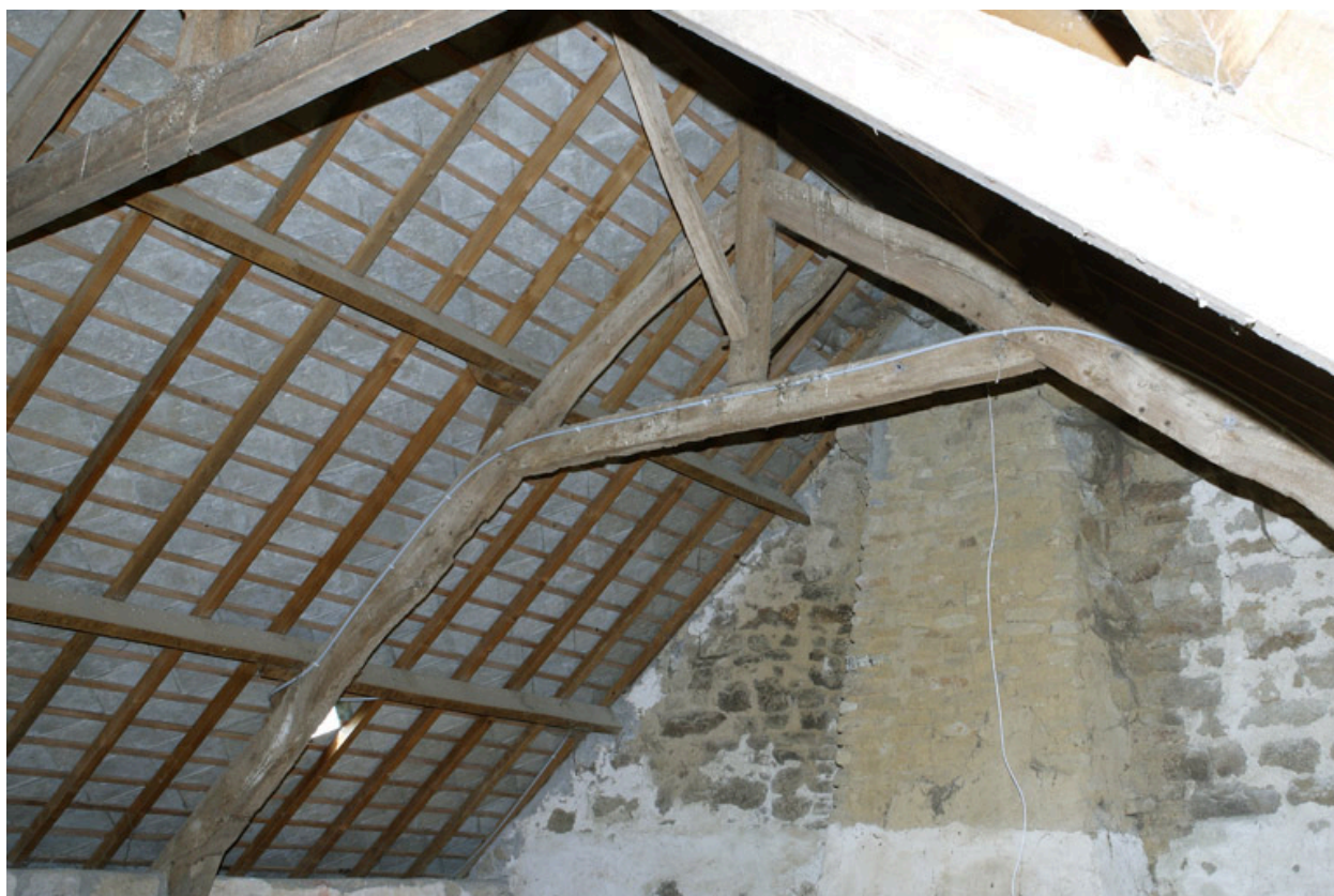
Logis. 3e niveau. Salle ouest. Détail de la charpente.
