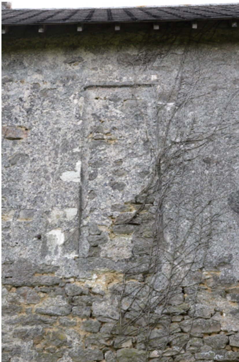
Logis. Façade nord. Croisée au 2e niveau de la 1ère travée.
