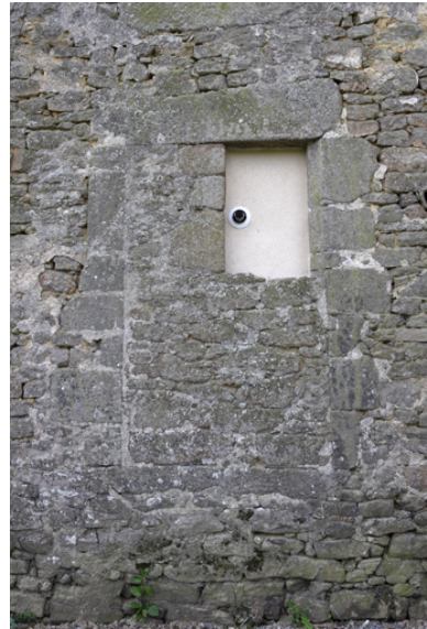
Logis. Façade nord. Croisée au 1er niveau de la 2e travée. Phot. Denis Pillet IVR52_20084401701NUCA
