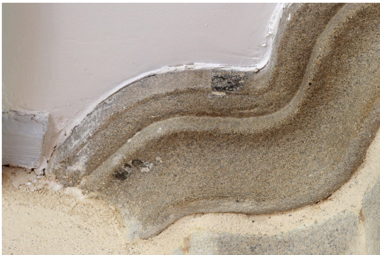
Logis. 1er niveau. Salle ouest. Vestige d'enduit peint (?) sur le manteau de la cheminée.
