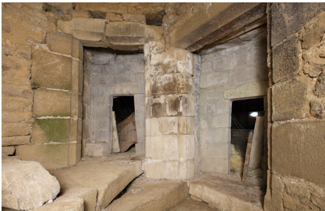
Logis. Tour d'escalier. 3e niveau. Portes d'accès aux salles du niveau de comble.
