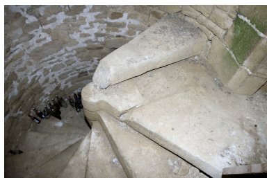
Logis. Tour d'escalier. Vue du dernier palier. Phot. Denis Pillet IVR52_20084401723NUCA
