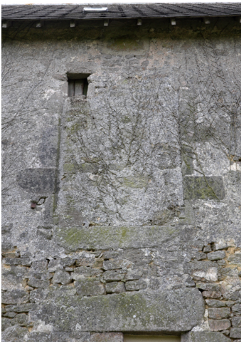
Logis. Façade nord. Croisée au 2e niveau de la 2e travée.
