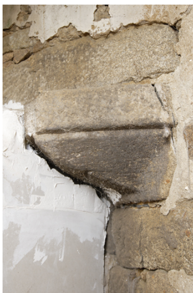
Logis. Tour d'escalier. 1er niveau. Détail du coussinet portant le linteau de la porte d'accès à la salle est. Phot. Denis Pillet IVR52_20084401678NUCA
