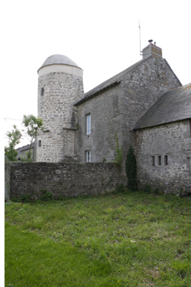
Logis. Vue de trois-quarts depuis le nord-ouest. Phot. Denis Pillet IVR52_20084401705NUCA
