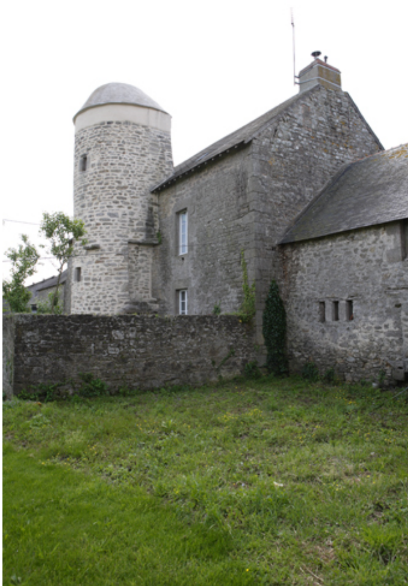
Logis. Vue de trois-quarts depuis le nord-ouest.
