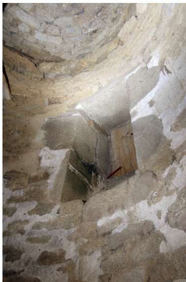
Logis. Tour d'escalier. 3e niveau. Jour d'éclairage. Phot. Denis Pillet IVR52_20084401684NUCA
