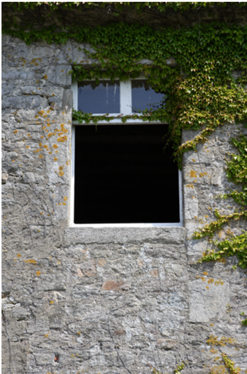
Logis. Façade sud. Croisée au 2e niveau de la 3e travée.
