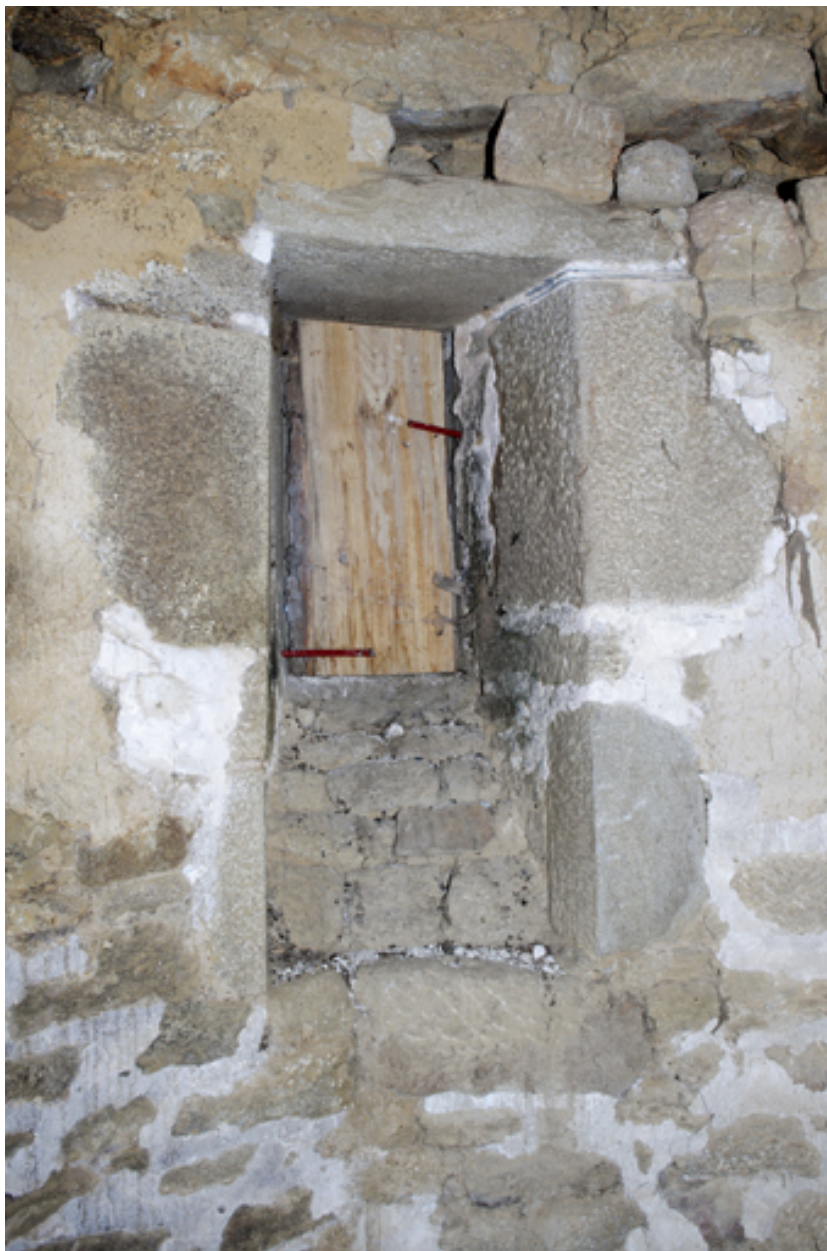
Logis. Tour d'escalier. 3e niveau. Jour d'éclairage.
