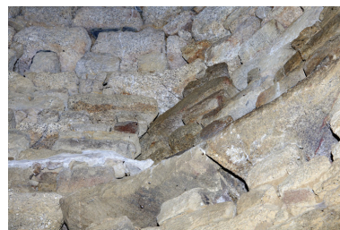
Logis. Tour d'escalier. Détail de l'entrée bouchée pour les pigeons. Phot. Denis Pillet IVR52_20084401722NUCA
