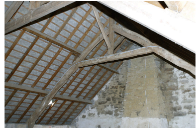
Logis. 3e niveau. Salle ouest. Détail de la charpente. Phot. Denis Pillet IVR52_20084401719NUCA
