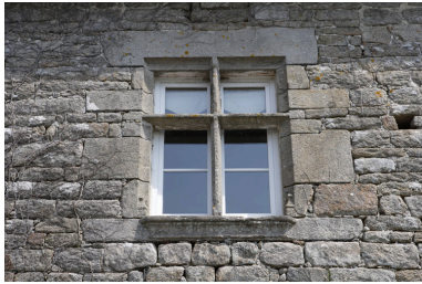
Logis. Façade sud. Croisée au 2e niveau de la 1ère travée. Phot. Denis Pillet IVR52_20084401714NUCA
