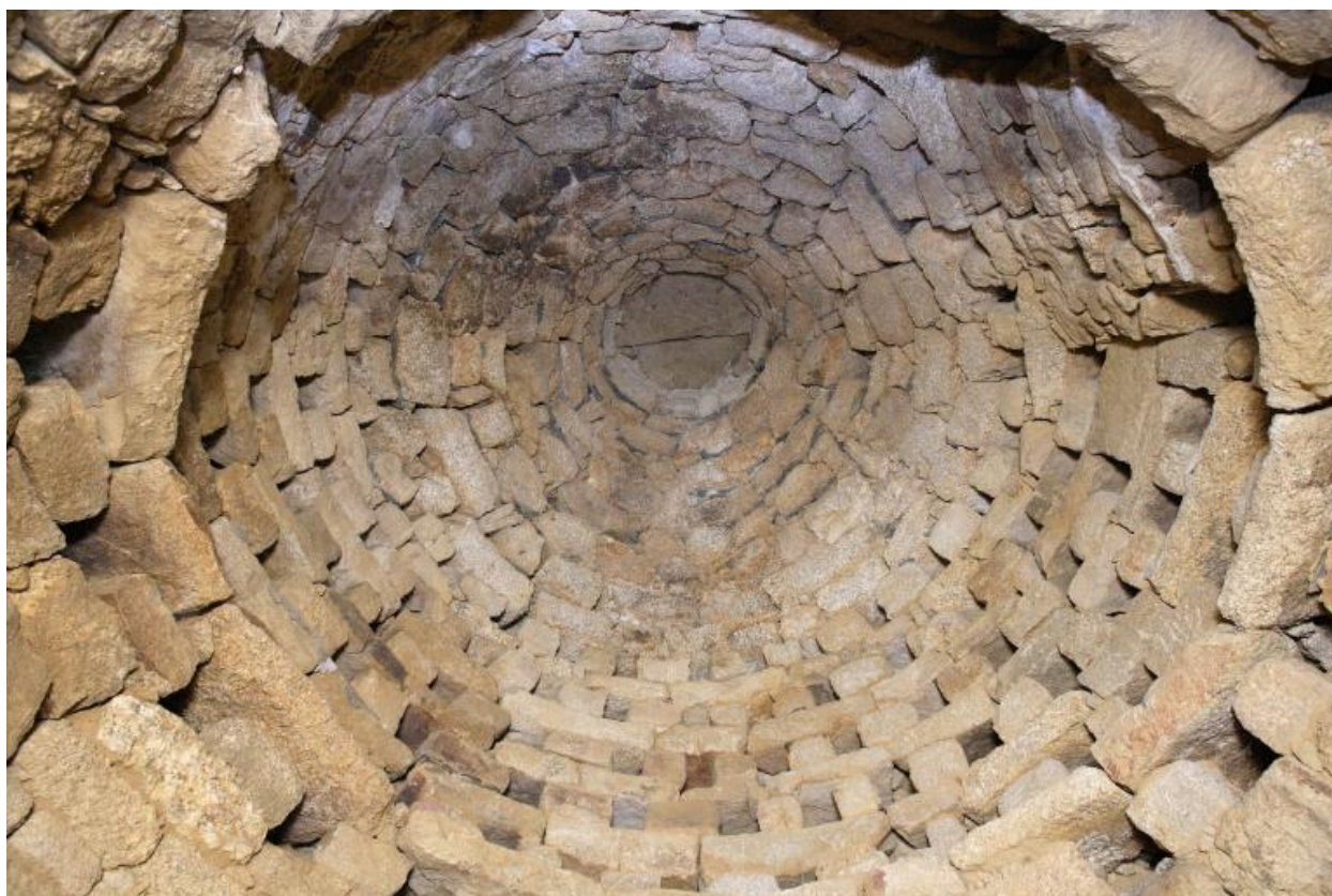
Logis. Tour d'escalier. Pigeonnier.
