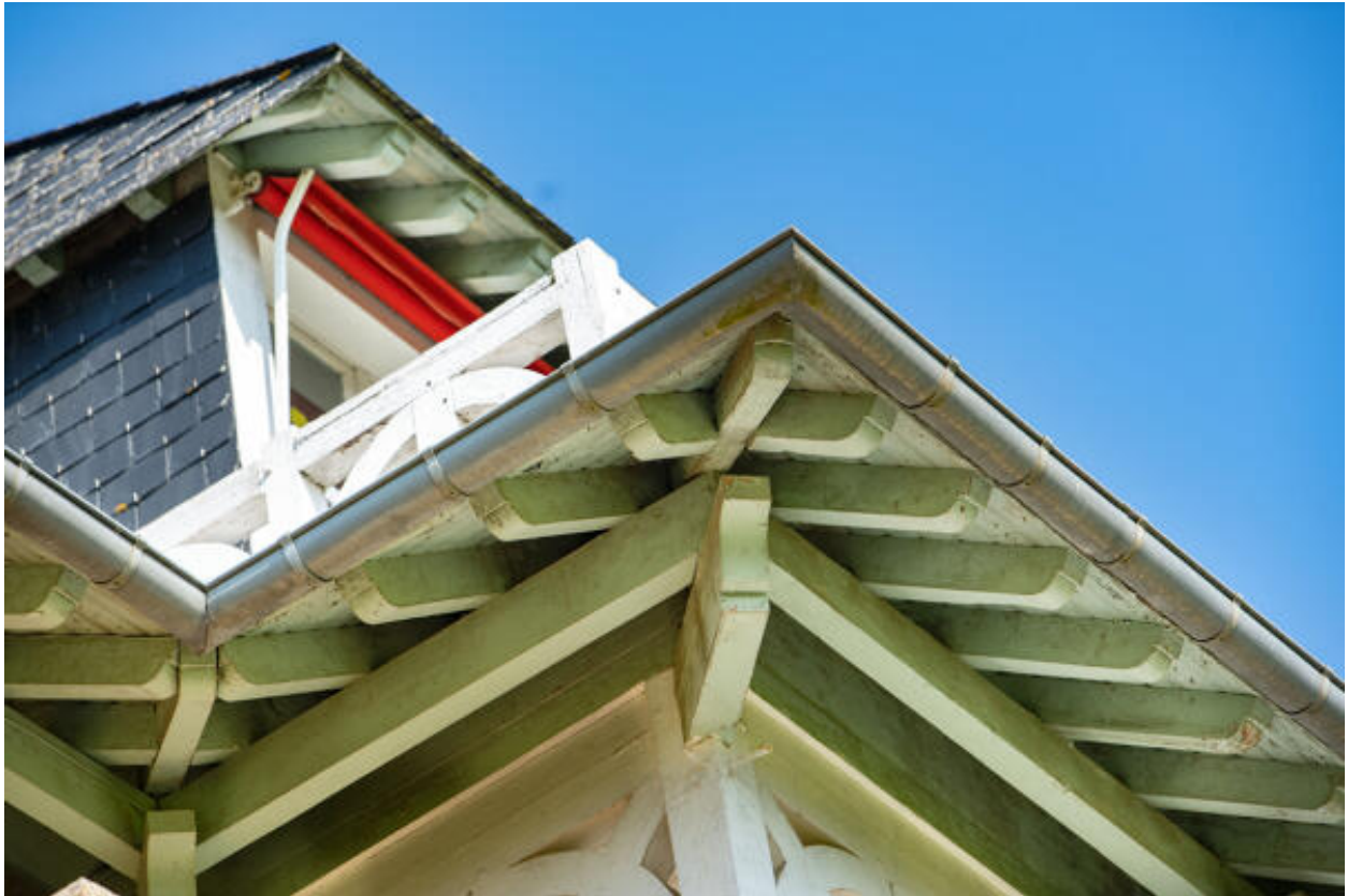
Un détail des débords de toit.
