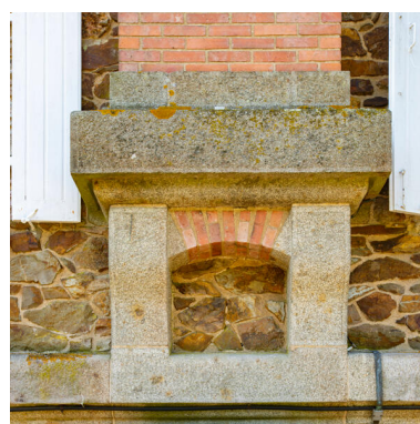
La base d'une souche de cheminée. Phot. Pierre-Bernard Fourny IVR52_20235301300NUCA
