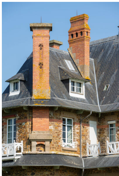
Les souches de cheminées. Phot. Pierre-Bernard Fourny IVR52_20235301290NUCA
