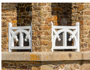
Le garde-corps de la terrasse. Phot. Pierre-Bernard Fourny IVR52_20235301294NUCA
