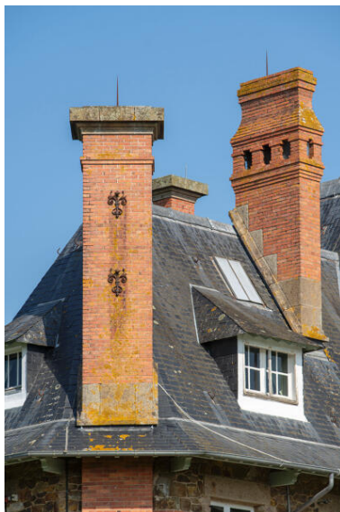
Les souches de cheminées. Phot. Pierre-Bernard Fourny IVR52_20235301291NUCA
