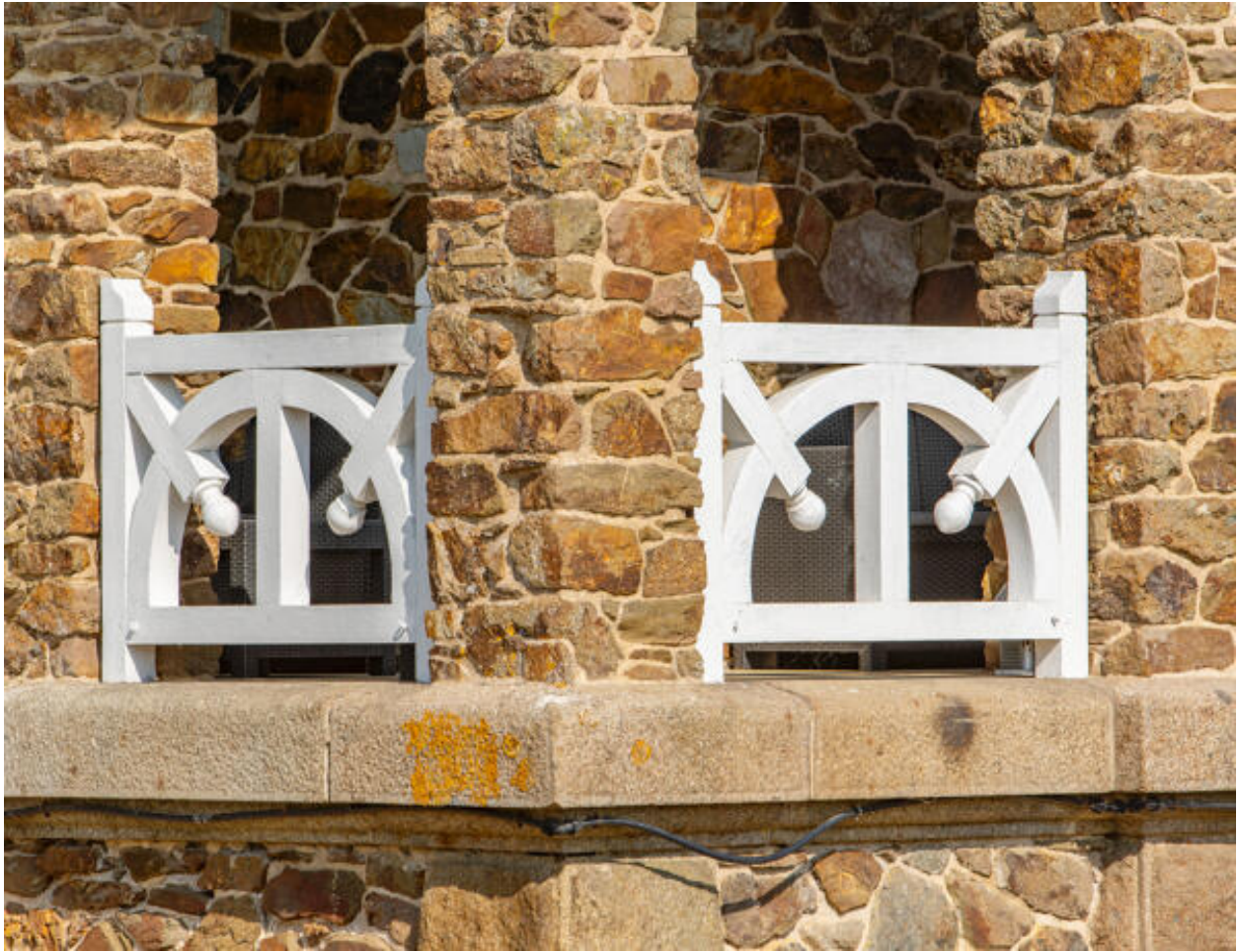
Le garde-corps de la terrasse.
