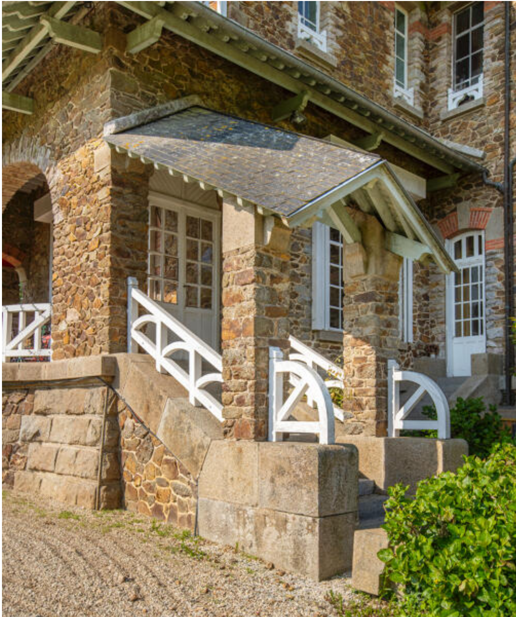
Le porche d'accès à la terrasse.
