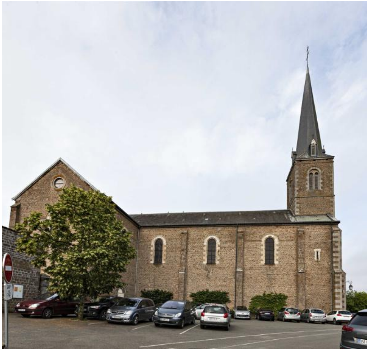
Eglise Saint-Fraimbault, vue depuis l'est.
