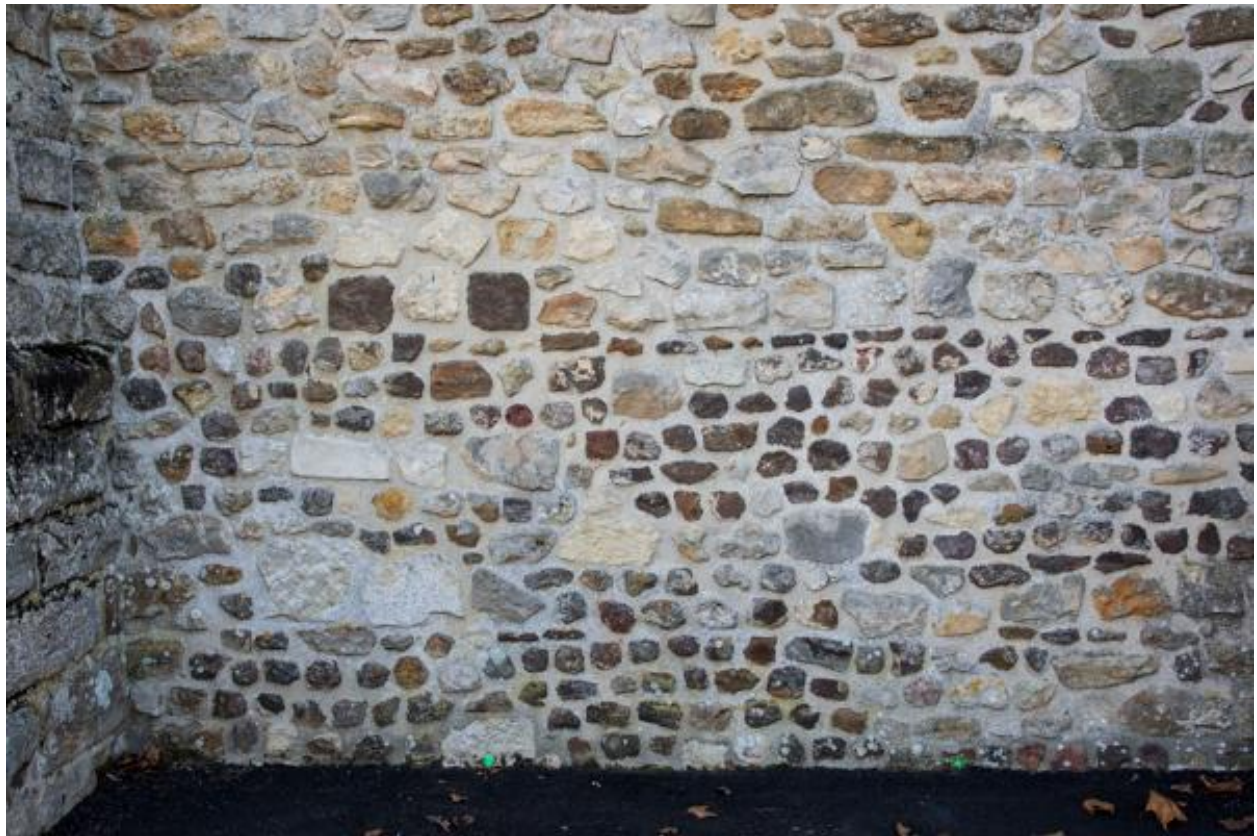
Vue des matériaux au chevet de l'église.
