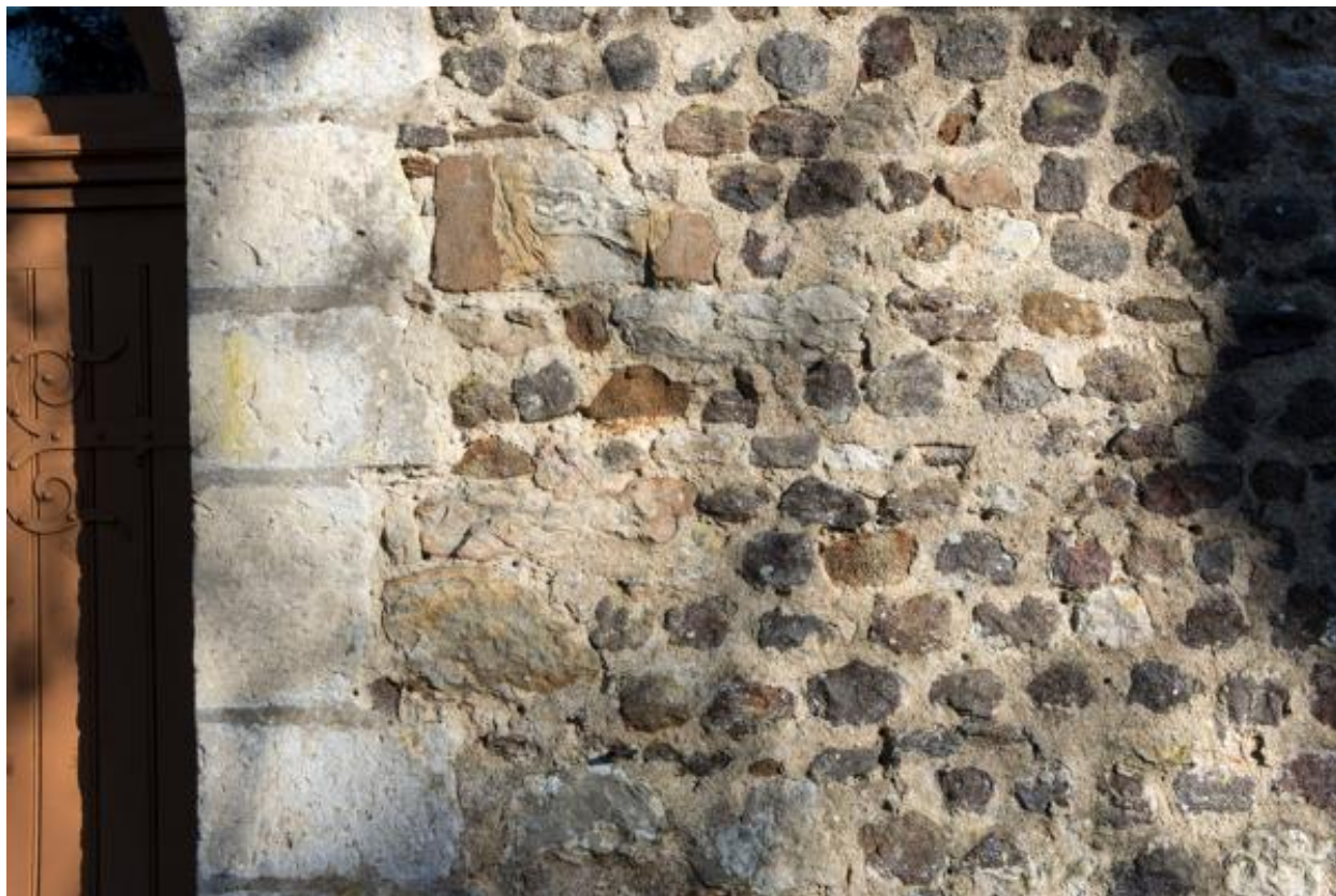
Vue des matériaux de construction au porche de l'église.
