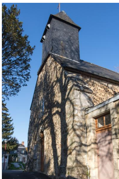
Vue du porche de l'église. Phot. Bruno Rousseau IVR52_20207201168NUCA
