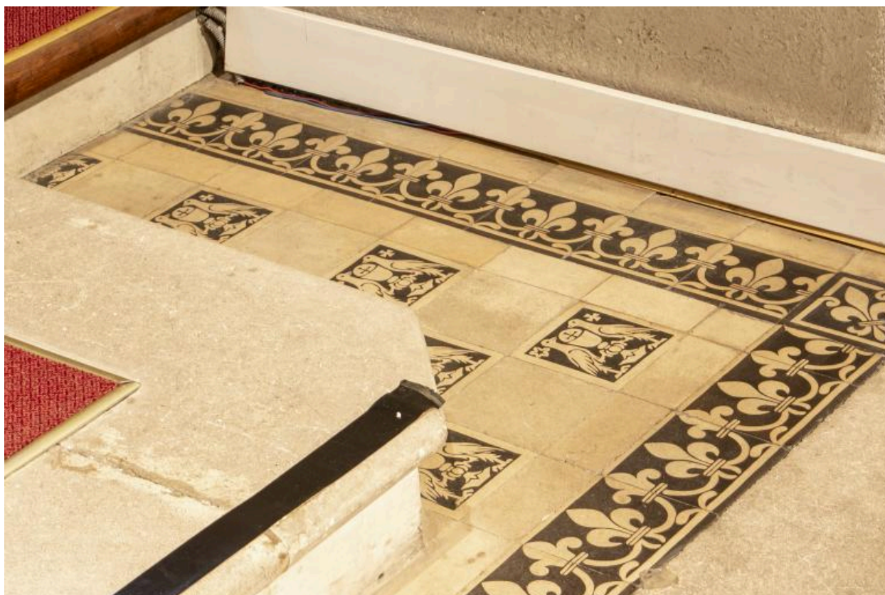
Vue du dallage dans la chapelle.
