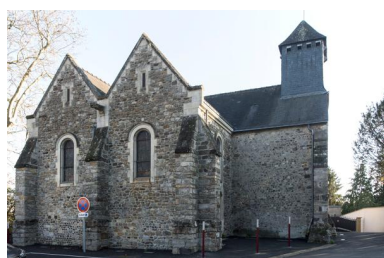
Vue du flanc nord de l'église. Phot. Bruno Rousseau IVR52_20207201171NUCA
