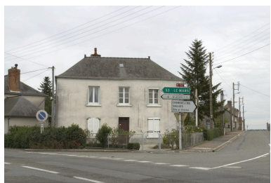
Vue depuis la route. Phot. François Lasa IVR52_20045303321NUCA
