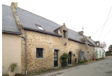
Vue vers l'Est. Phot. Denis Pillet IVR52_20074400235NUCA
