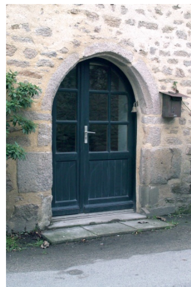
Porte en arc brisé du n°19. Phot. Denis Pillet IVR52_20074400236NUCA
