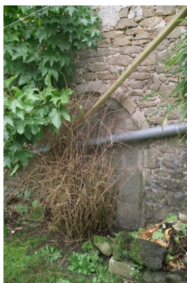
Façade postérieure, détail d'une porte condamnée. Phot. Denis Pillet
