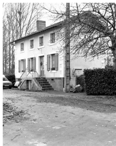
La maison éclusière. Phot. François Lasa IVR52_20015300762X
