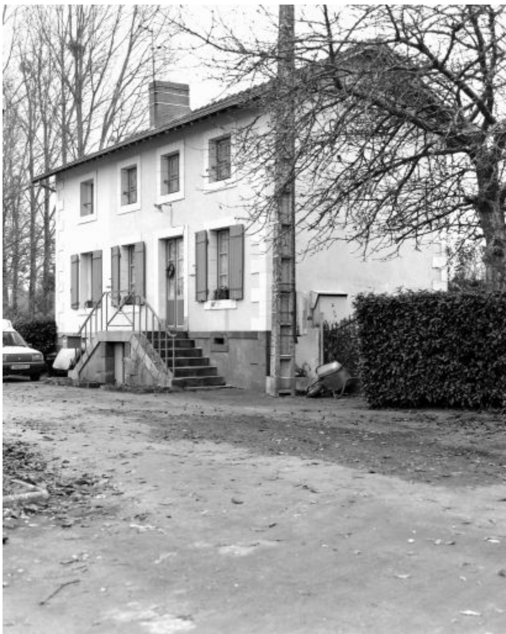
La maison éclusière.
