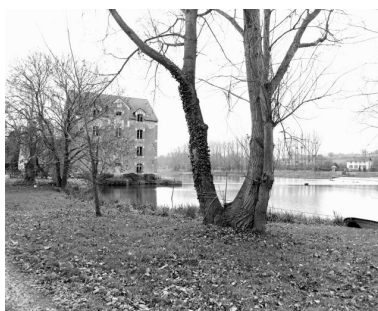
Vue d'ensemble du site depuis la rive gauche en amont : ancien et nouveau moulin (façade nord), barrage, pertuis, maison éclusière.
