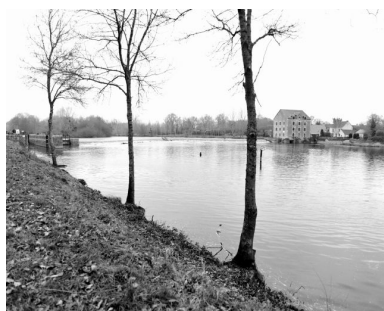
Vue d'ensemble du site depuis la rive droite en aval : écluse, pertuis, barrage, moulin et ses dépendances.
