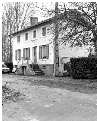
La maison éclusière. Phot. François Lasa IVR52_20015300762X
