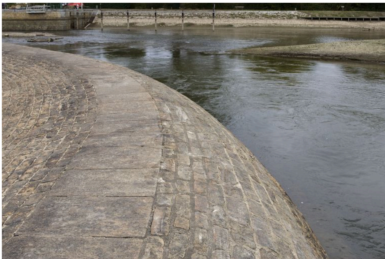
Vue partielle du barrage vers la rive droite, pendant les écourues de 2009.
