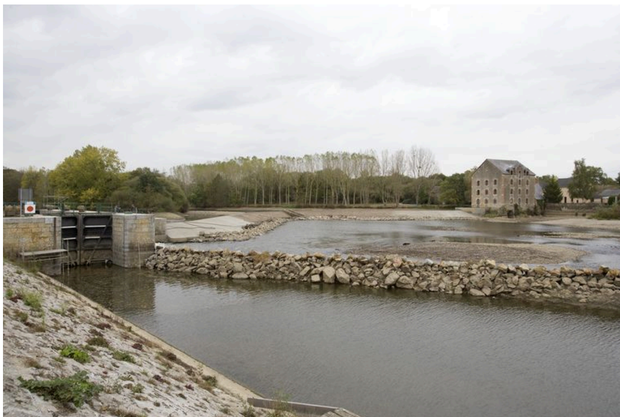
Vue d'ensemble du site depuis la rive droite en aval, pendant les écourues de 2009 : écluse, barrage, moulin et ses dépendances.
