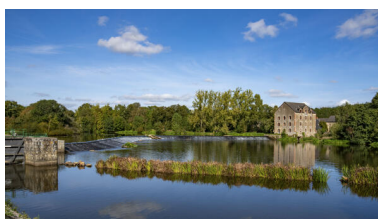
Le barrage de Formusson. Phot. Pierre-Bernard Fourny IVR52_20235301657NUCA
