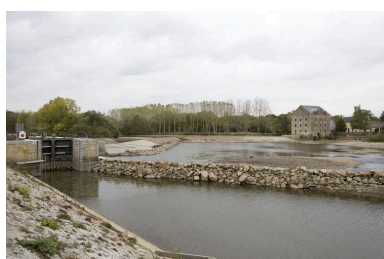
Vue d'ensemble du site depuis la rive droite en aval, pendant les écoures de 2009 : écluse, barrage, moulin et ses dépendances.
