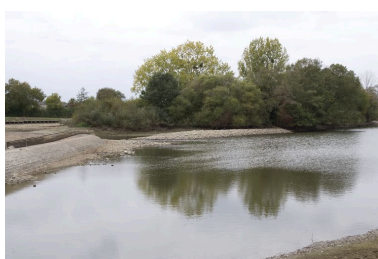
Vue partielle depuis la rive gauche du barrage actuel et des vestiges du barrage détruit en 1860, pendant les écoures de 2009.
