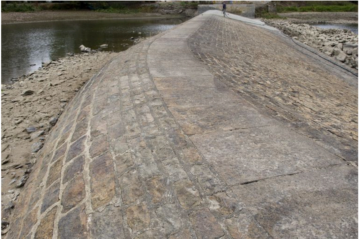
Vue partielle du barrage vers la rive gauche, pendant les écourtes de 2009.
