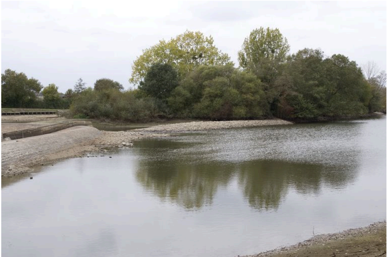
Vue partielle depuis la rive gauche du barrage actuel et des vestiges du barrage détruit en 1860, pendant les écourues de 2009.
