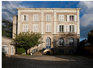
Elévation antérieure : vue d'ensemble depuis la cour. Phot. Yves Guillotin IVR52_20135300758NUCA
