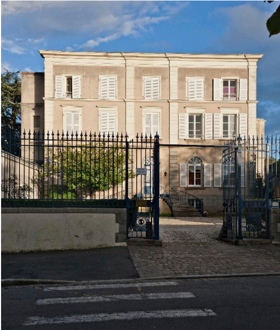
Elévation antérieure : vue d'ensemble depuis la rue.
