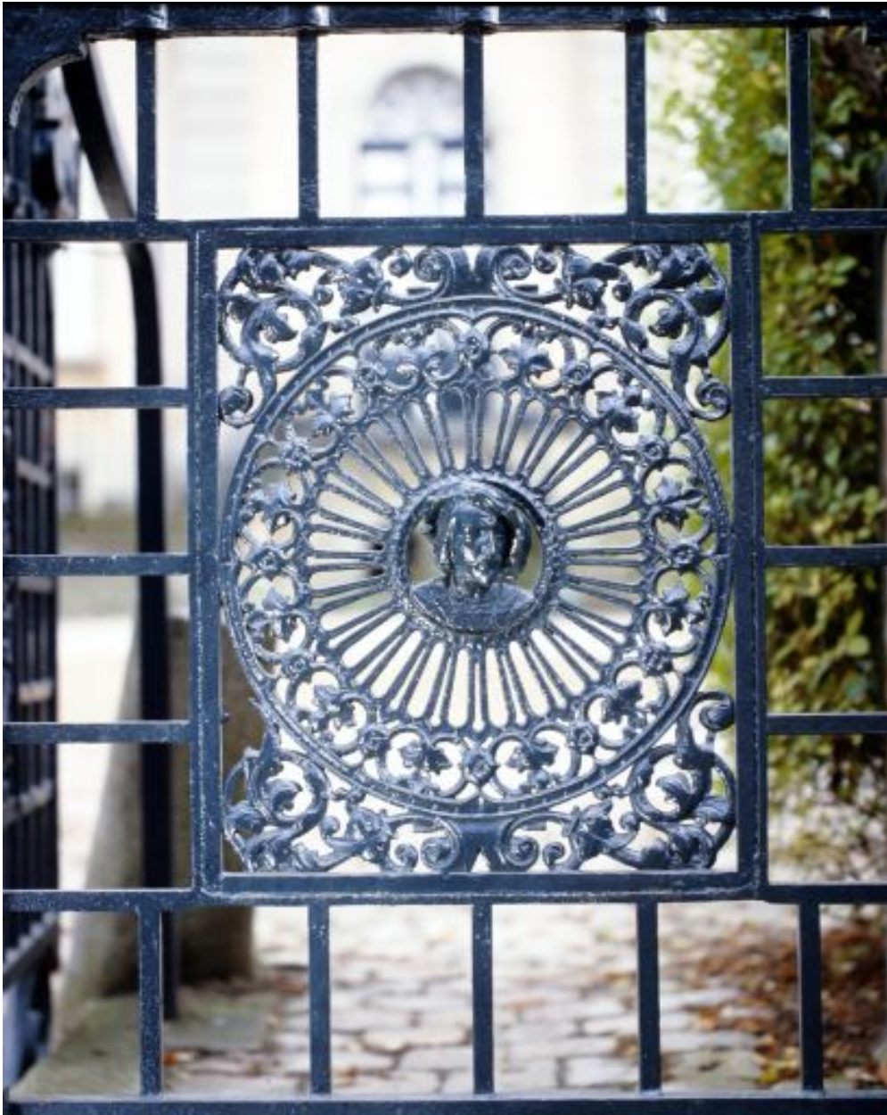
Grille de clôture : détail.
