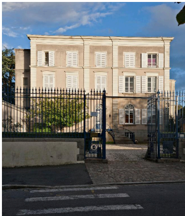
Elévation antérieure : vue d'ensemble depuis la rue. Phot. Yves Guillotin IVR52_20135300757NUCA
