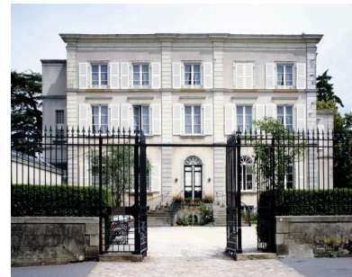
Elévation antérieure sur cour. Phot. François Lasa IVR52_19885300599XA
