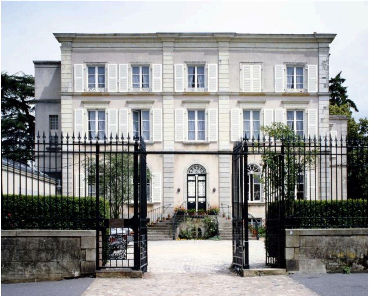
Elévation antérieure sur cour.
