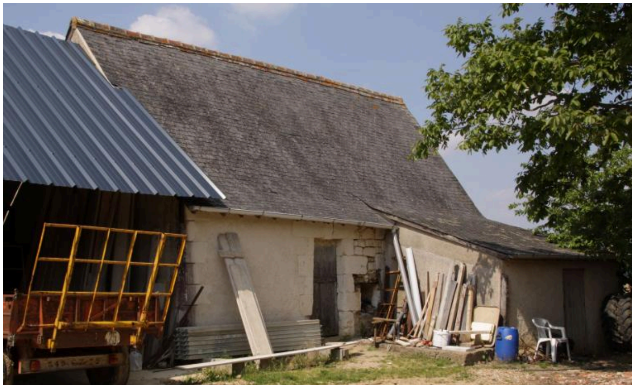
Maison : façade antérieure.
