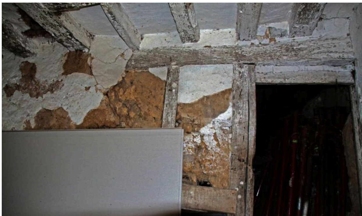
Maison, porte de communication intérieure : cloison à pan de bois.
