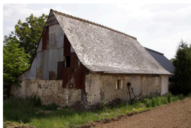
Vue de volume avec façade postérieure et mur-pignon est. Phot. Jean-Baptiste Darrasse IVR52_20107200998NUCA
