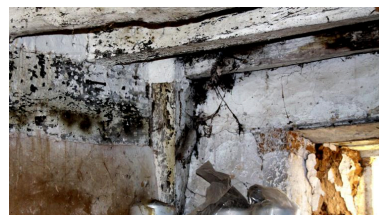
Maison, intérieur : détail poteau de bois. Phot. Jean-Baptiste Darrasse IVR52_20107201000NUCA
