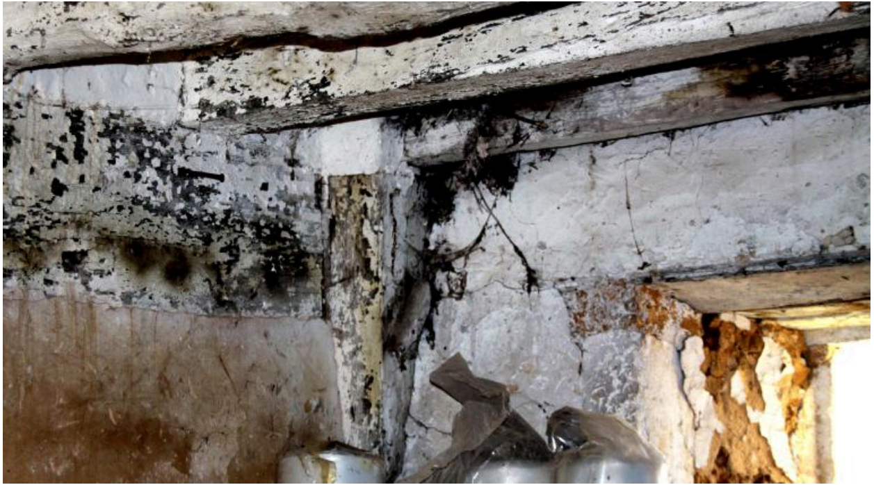
Maison, intérieur : détail poteau de bois.
