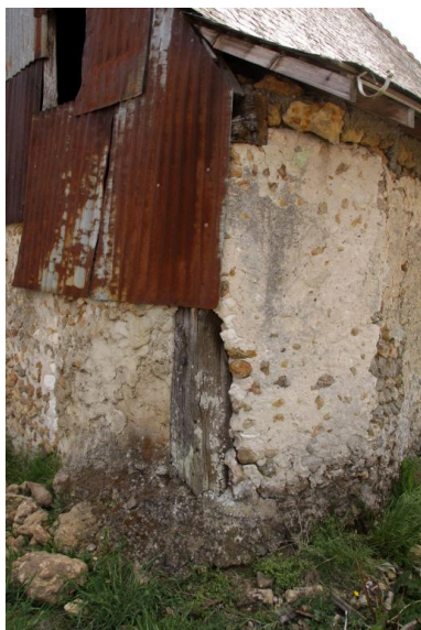
Maison, angle mur-pignon est et façade nord : poteau en bois. Phot. Jean-Baptiste Darrasse IVR52_20107200999NUCA
