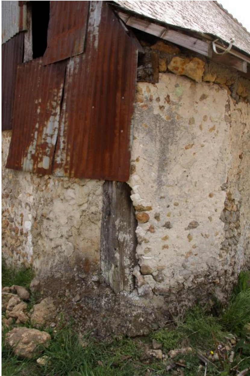
Maison, angle mur-pignon est et façade nord : poteau en bois.
