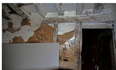
Maison, porte de communication intérieure : cloison à pan de bois. Phot. Jean-Baptiste Darrasse IVR52_20107201001NUCA
