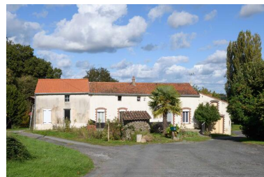
Vue de la façade sud de la ferme de la Papinière, Saint-Laurent-du-Mottay. Phot. Armelle Maugin IVR52_20244901046NUCA
