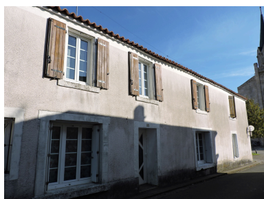
La façade vue depuis le sud-ouest. Phot. Yannis Suire IVR52_20218500245NUCA
