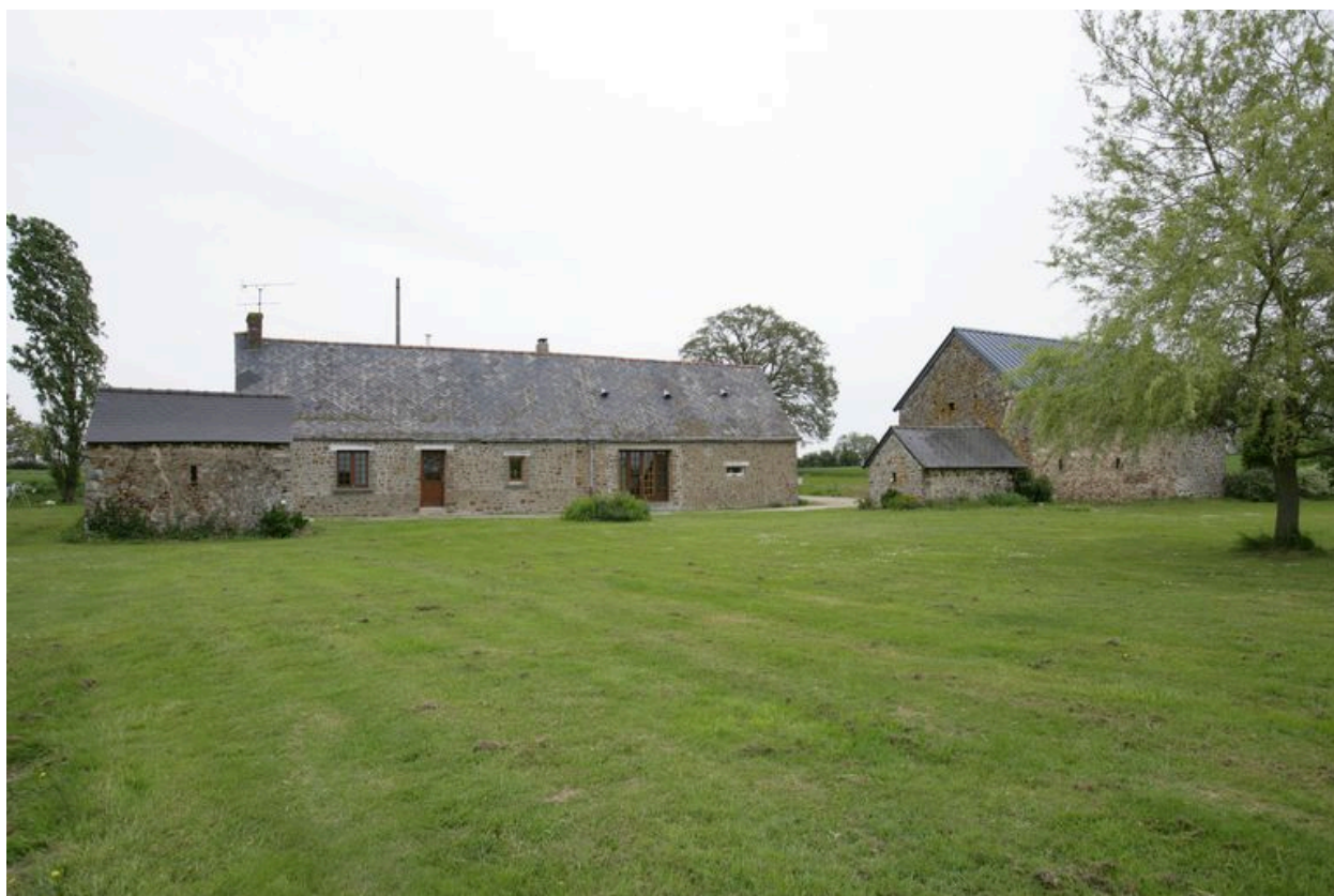
Vue d'ensemble depuis le sud : la porcherie, le logis-étable, l'étable indépendante.
