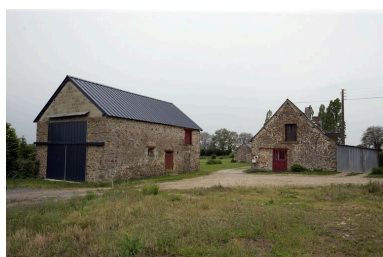
L'étable indépendante et le logis-étable vus depuis l'est. Phot. François Lasa IVR52_20055301514NUCA
