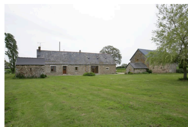
Vue d'ensemble depuis le sud : la porcherie, le logis- étable, l'étable indépendante. Phot. François Lasa IVR52_20055301513NUCA
