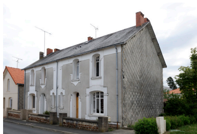
Vue générale des deux maisons de contremaîtres de la Société Anonyme de Chaussures. Phot. Bruno Rousseau, Phot. Youenn Communeau IVR52_20114901521NUCA
