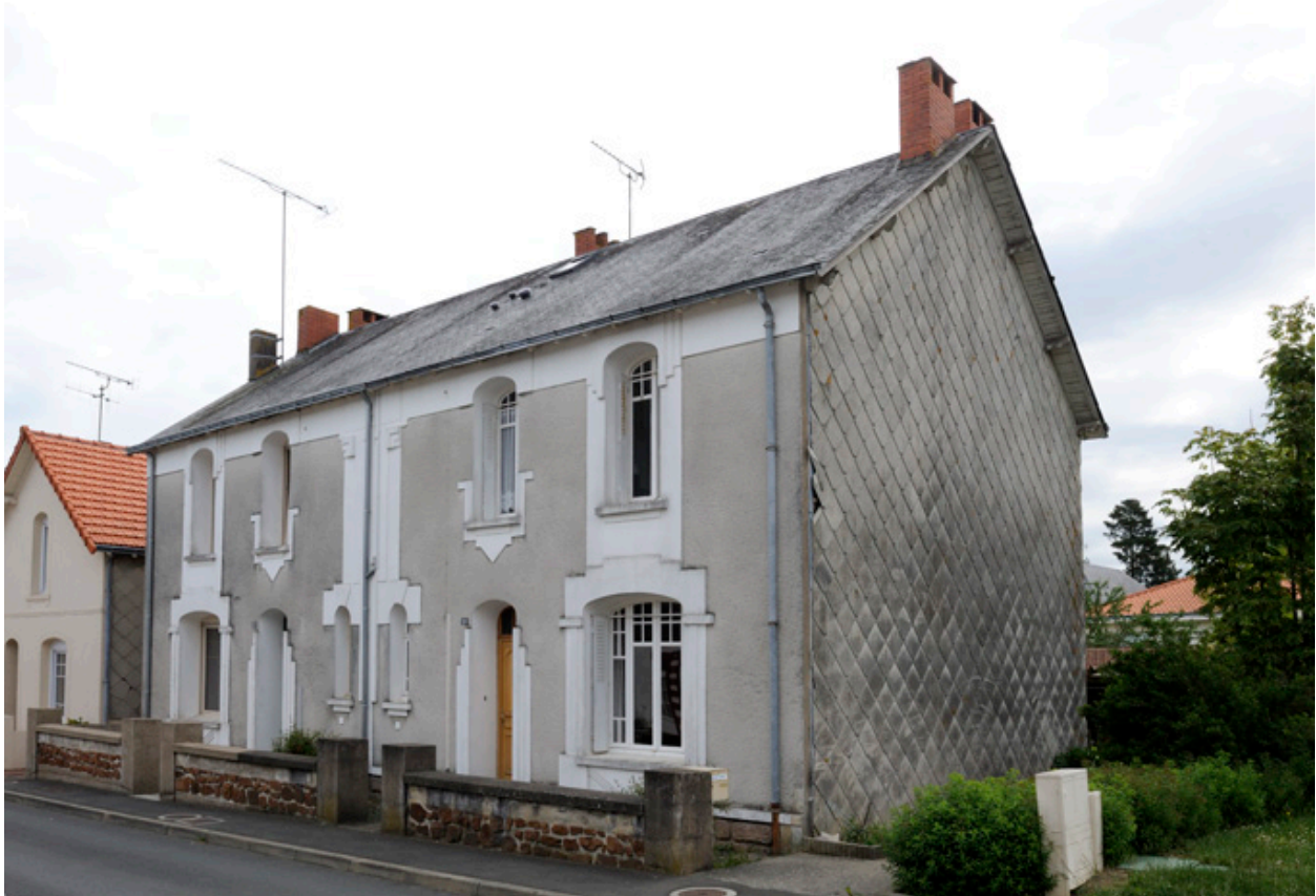
Vue générale des deux maisons de contremaîtres de la Société Anonyme de Chaussures.
