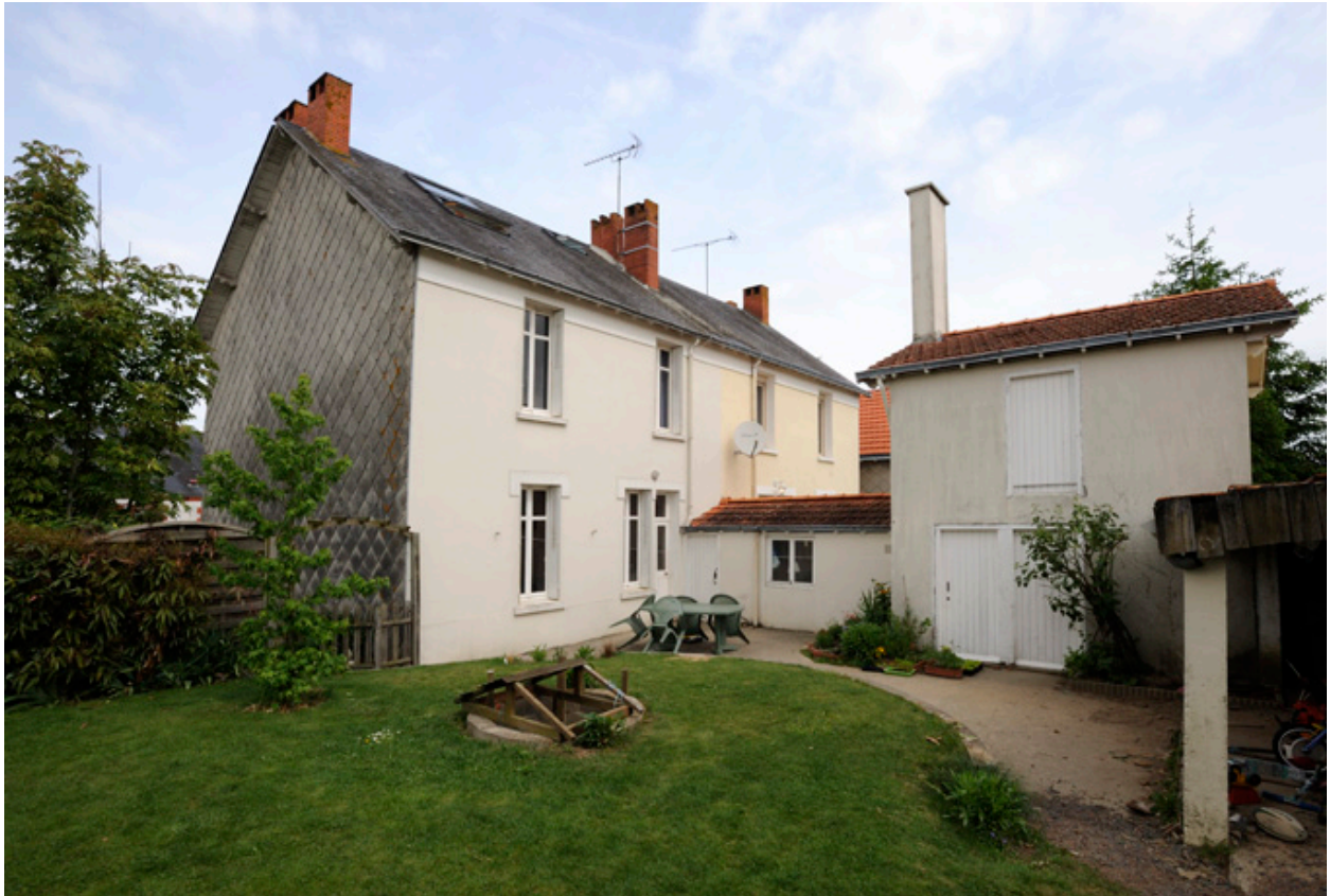
Maison de contremaître de la Société Anonyme de Chaussures : façade arrière..
