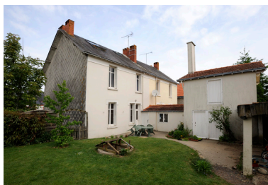
Maison de contremaître de la Société Anonyme de Chaussures : façade arrière.. Phot. Bruno Rousseau, Phot. Youenn Communeau IVR52_20114901524NUCA
