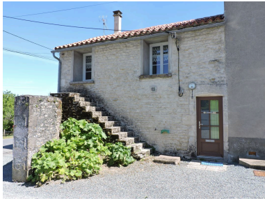
La maison du numéro 3 vue depuis le nord, avec l'escalier extérieur.
